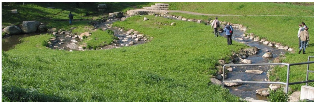
Obr. 14 Obtokové koryto. RP typu bypass. © fotoarchiv AOPK ČR
