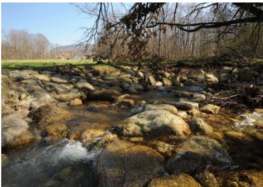
Obr. 19 Balvanitý skluz. (pozn. Je zde zřejmá jasně vymodelovaná kyneta pro soustředění nižších průtoků; skluz nevyužívá celou plochu – šířku – koryta vodního toku.) © fotoarchiv AOPK ČR
