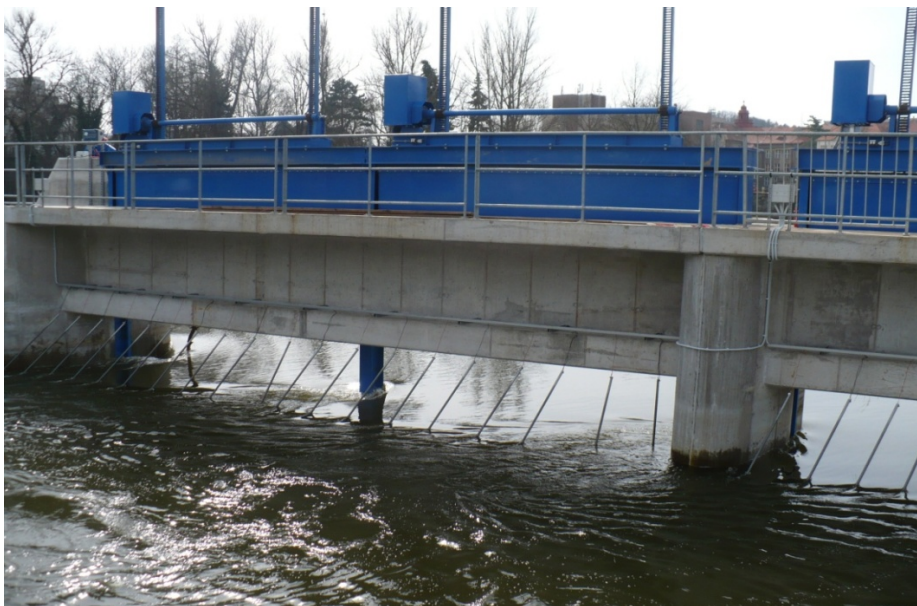
Obr. 25 Elektronické plašiče (odpuzovače) ryb (typ Elza 2). © Petr Hartvich
