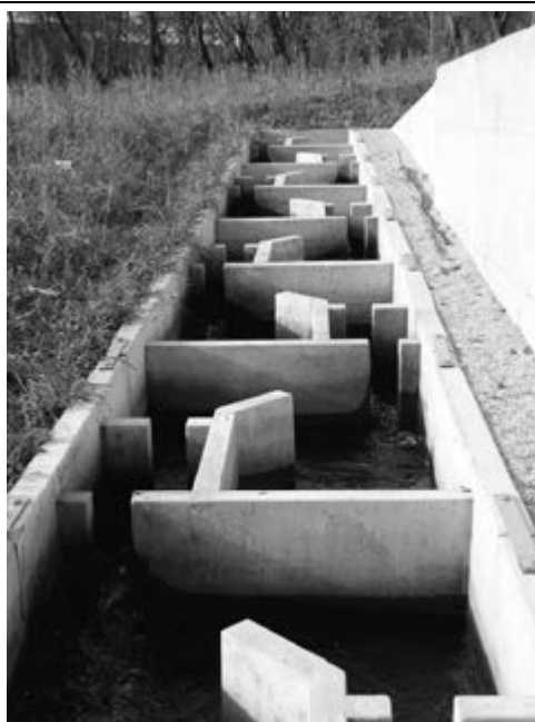
Realizace multi-štěrbínového RP na jezu Glöckler – řeka Piesting (pilotní projekt)
