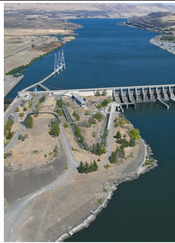
Obr. 19: Na přehradě Dalles, Portland, Oregon, USA, je migrace ryb řešena pomocí tří rybích přechodů, které mají vzhledem k výšce přehrady lomenou trasu. Voda k navedení ryb do přechodů je dodávána pomocí speciálních turbín, v případě poruchy turbín pak rezervním potrubím.
