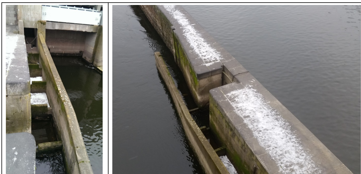
Obr. 33: Původní historický rybí přechod, vlevo detail konstrukce, vpravo dva vstupy
