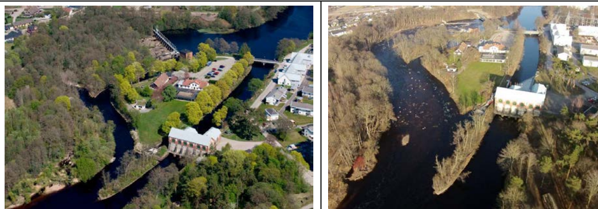
Obr. 13: Jez Herting, Švédsko, vlevo původní stav s technickým RP, napravo nový přírodě blízký bypass.
