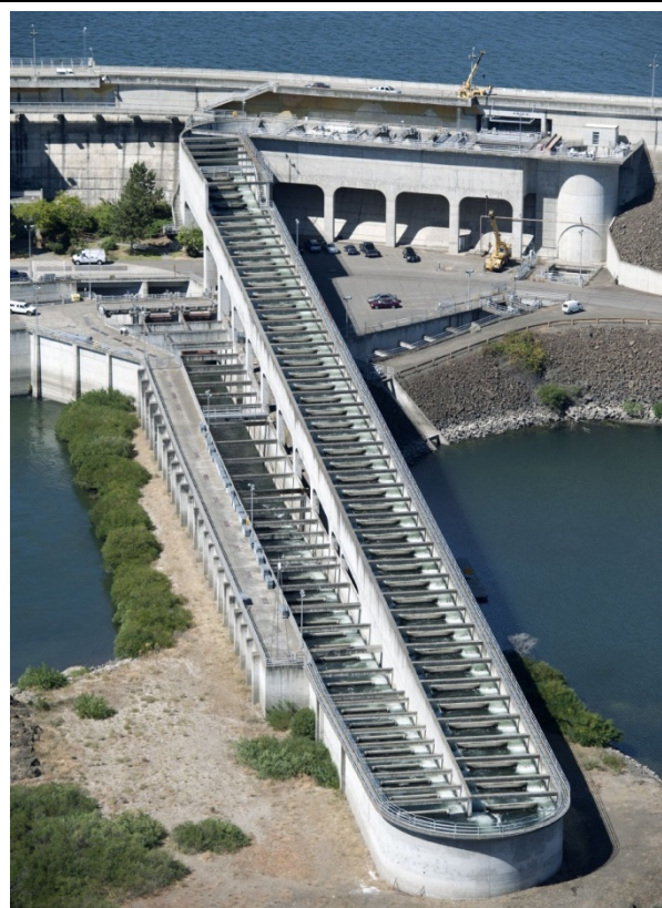
Obr. 19: Na přehradě Dalles, Portland, Oregon, USA, je migrace ryb řešena pomocí tří rybích přechodů, které mají vzhledem k výšce přehrady lomenou trasu. Voda k navedení ryb do přechodů je dodávána pomocí speciálních turbín, v případě poruchy turbín pak rezervním potrubím.
