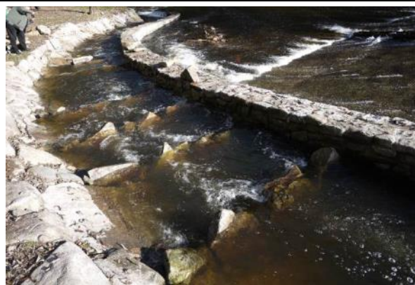
RP Pstruhařství Kaplice na řece Malši, realizace 2014 – vstup do přechodu doplněn o naváděcí práh
