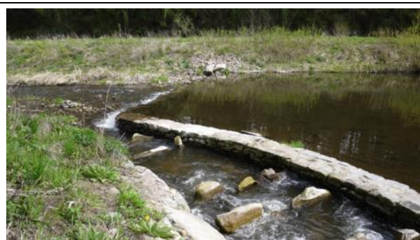
RP Pstruhařství Kaplice na řece Malši, realizace 2014 – vstup do přechodu doplněn o naváděcí práh
