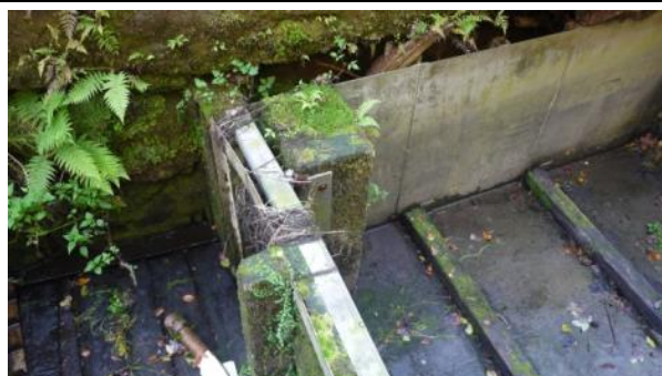
Obr. 24: Detail konstrukce přepážky RP
