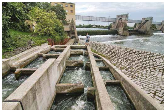
RP s lomenou trasou pro limitující prostorové podmínky
