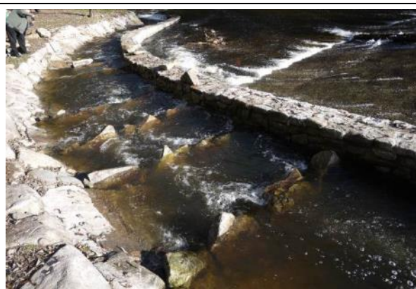
RP Pstruhařství Kaplice na řece Malši, realizace 2014 – vstup do přechodu doplněn o naváděcí práh
