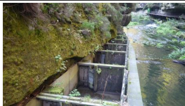
Obr. 25: Rybí přechod, detail konstrukce, úsek 2
