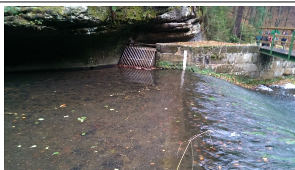
Obr. 18: Pohled z nadjezí – vtok do náhonu
