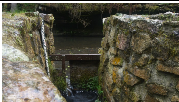
Obr. 15: Detail konstrukce RP - vtokové okno
