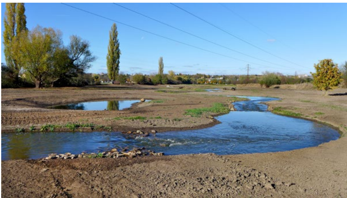
Obr. 6.20 Sled dnových pasů z kameniva ve funkci základních stabilizačních a členících prvků dokončované revitalizace Říčanky v Praze pod Litožnickými rybníky (stavba hl. města Prahy, 2019). Brodová místa, vytvořená pasy, zde udržují příznivě vysokou polohu hladiny vody v korytě. Celá plocha nivy je ve vlastnictví města a určena k plnění funkcí říčního pásu. Zamokření nivy a časné rozlivy povodňových průtoků budou vnímány jako významné pozitivum.
