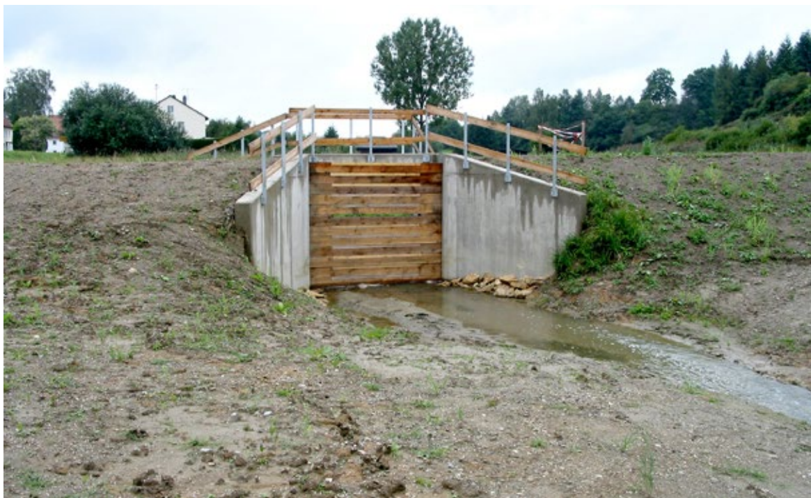
Obr. 5.28 Hráz a odtokový objekt nevelké „selské“ retenční nádrže na drobném potoce, kdesi v Bavorsku, kolem roku 2008. Odtok je hrazen hradidly – ležatými dřevěnými trámy, mezi nimiž jsou prořezány několikacentimetrové štěrby. Viditelně se počítá i s významným efektem zachycení splavenin.
