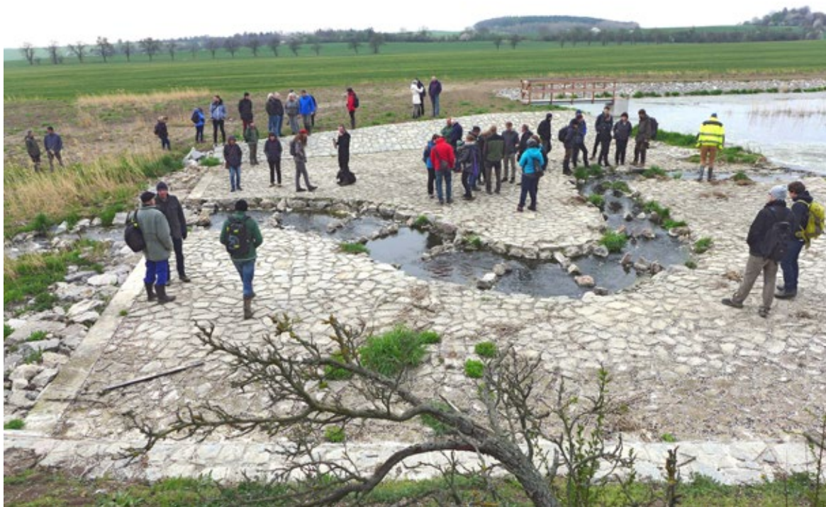
Obr. 7.26 Migračně prostupná kyneta pro běžné průtoky, vymodelovaná v přelivné ploše bezpečnostního přelivu průtočné malé vodní nádrže, která byla v roce 2017 postavena jako jeden z objektů revitalizace Radotínského potoka u Tachlovic (stavba Povodí Vltavy, s.p., dotováno v rámci OPŽP.) Takový objekt není obvyklý, ale pokud již je nutné zajistit prostupnost nádrže, toto provedení lze pokládat za funkční. Zde ovšem vybudování vcelku věrohodně vyhlížející kynety umožnilo netypicky mírný sklon přelivné plochy; velikost plochy pokryté dlažbou se promítá do nákladů stavby.
