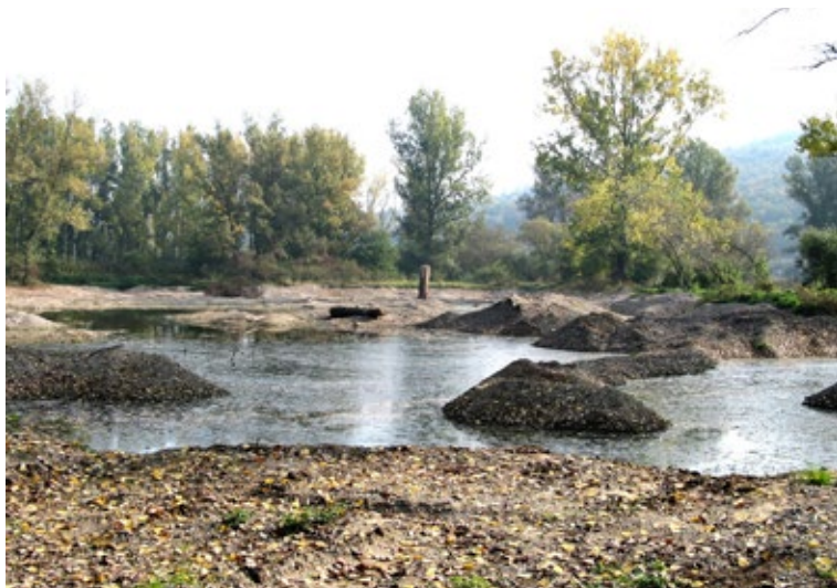
Obr. 7.3 Hloubení mokřadu v nivě Mohanu poblíž Ebingu; Bavorsko, cca 2008. Nejprve byla celá plocha vytěžena, štěrk z hlubších vrstev byl využit jinde jako cenný materiál, následně jsou ze skrývkových zemin modelovány šíje a ostrůvky.
