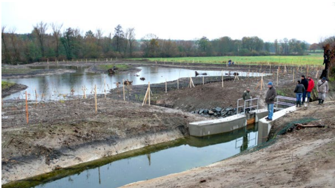
Obr. 7.6 Právě dokončený mokřad v nivě Košáteckého potoka. Na obnovovaném mlýnském náhonu - v popředí - byl zřízen technicky pojednaný odběrný objekt pro regulované napájení mokřadu vodou. Kolem mokřadu jsou postaveny oplocenky na ochranu výsadeb dřevin.
