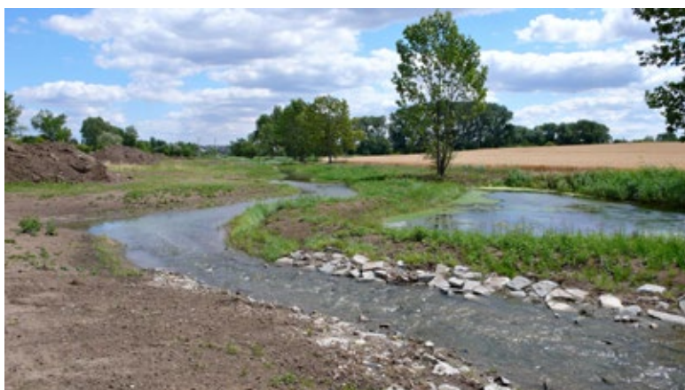
Obr. 4.13 Stabilizace dna revitalizačního koryta Litovického potoka pod Hostivicemi (2015) pasem z kameniva. Pas je dostatečně dlouhý, jeho dolní okraj sahá pod dolní uklidněnou hladinu a nevzniká přes něj přepad vody, který by mohl způsobovat vymílání. (Kamenivo není přírodně autentické, jde o hranitý materiál, získaný rozebráním dlažby dřívějšího technicky upraveného koryta. Území však není přírodně excelentní, takže lze tento odklon od přírodní autenticity dobře odůvodnit úsporou nákladů.)
