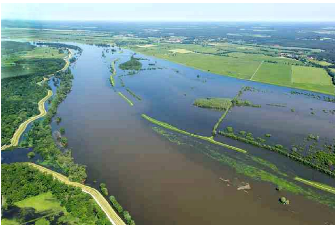
Obr. 5.6 Odsazení hráze u Lenzen ve funkci, za povodně, pohled po proudu Labe (Letecký snímek – zdroj internet.)
