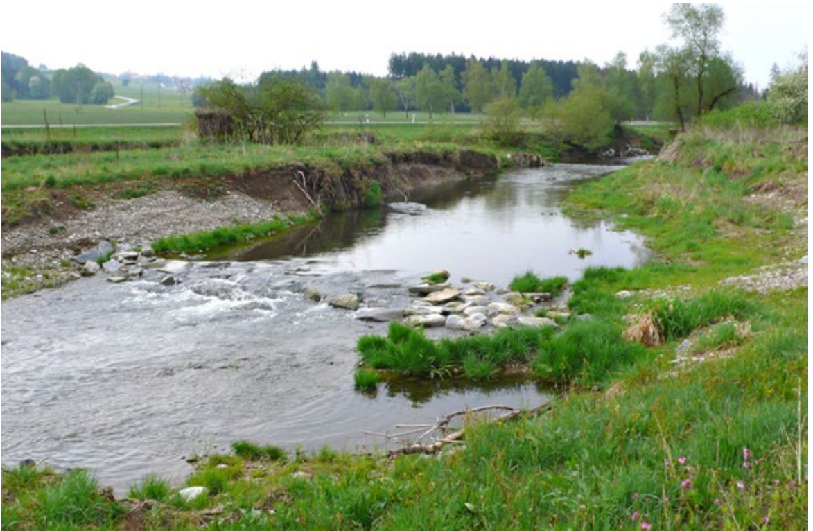
Obr. 6.22 Dnový pas z balvanů v korytě říčky Mindel v Bavorsku, 2009. Objekt zamezuje nežádoucímu zahlubování koryta a mírně je změlčuje, resp. zavzdouvá.
