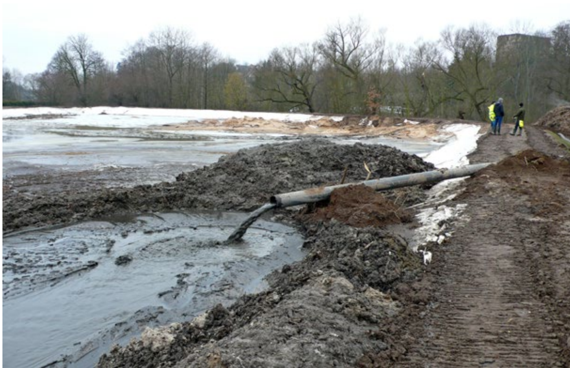
Obr. 7.25 Plnění odvodňovací laguny směsí vody a sedimentu, vytlačovanou od sacího bagru. Jde o celkově náročnou akci: Těženého materiálu je mnoho, často se odvodňuje hůř, než se čekalo, laguny se nesmějí prorhnout a vytéct, nesmí dojít ke kontaminaci vod.
