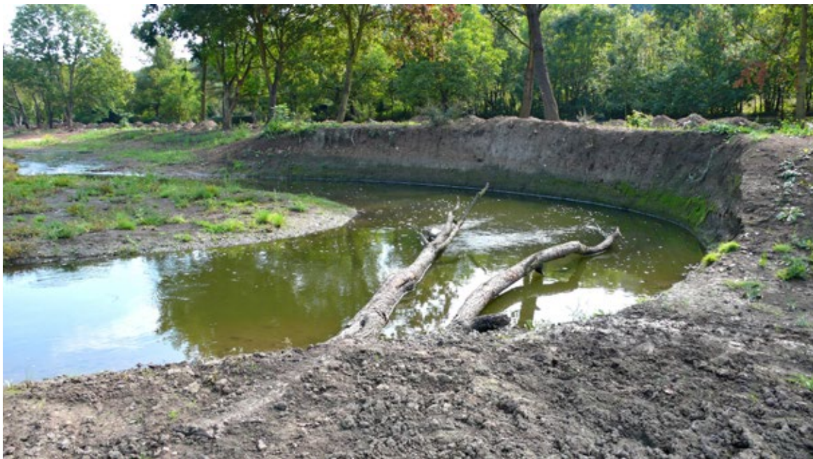
Obr. 6.44 Hnízdni svah, vymodelovaný v revitalizačním korytě Rokytky u pražských Hrdlořez. Akce Města Prahy, 2014. V popředí instalace říčního dřeva.
