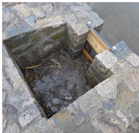
Obr. 7.17 Odtokový objekt v soustavě lagun Josefov II u Milovic umožňuje regulovat hladinu v rozsahu několika decimetrů výšky. Aktuálně je osazena dlužová sestava s průtokovou mřížkou, která chrání následující odtokovou trubku před ucpáním splávim.
