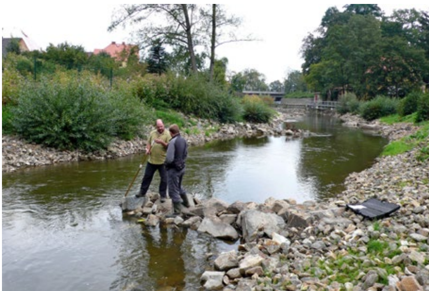
Obr. 6.32 Soustava balvanových výhonů, vyběhající do koryta střídavě z pravého a levého břehu, stabilizuje a zároveň rozčleňuje řečiště podhorské řeky Mangfall v Bavorsku; kolem r. 2010. Soustava vytváří vzdutí převážně hydrodynamického charakteru.
