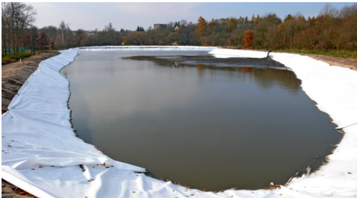
Obr. 7.23 Dvojice odvodňovacích lagun u Týnce nad Labem (druhá sekce laguny je v pozadí) v počátku napouštění. Do lagun, které mohou podle potřeby pracovat vedle sebe nebo za sebou, je potrubím od sacího bagru vytlačována směs vody a sedimentu. V lagunách se sediment odvodňuje, dekantát (odsazená tekutina) je potrubím vrácen zpět do pracovního prostoru sacího bagru.
