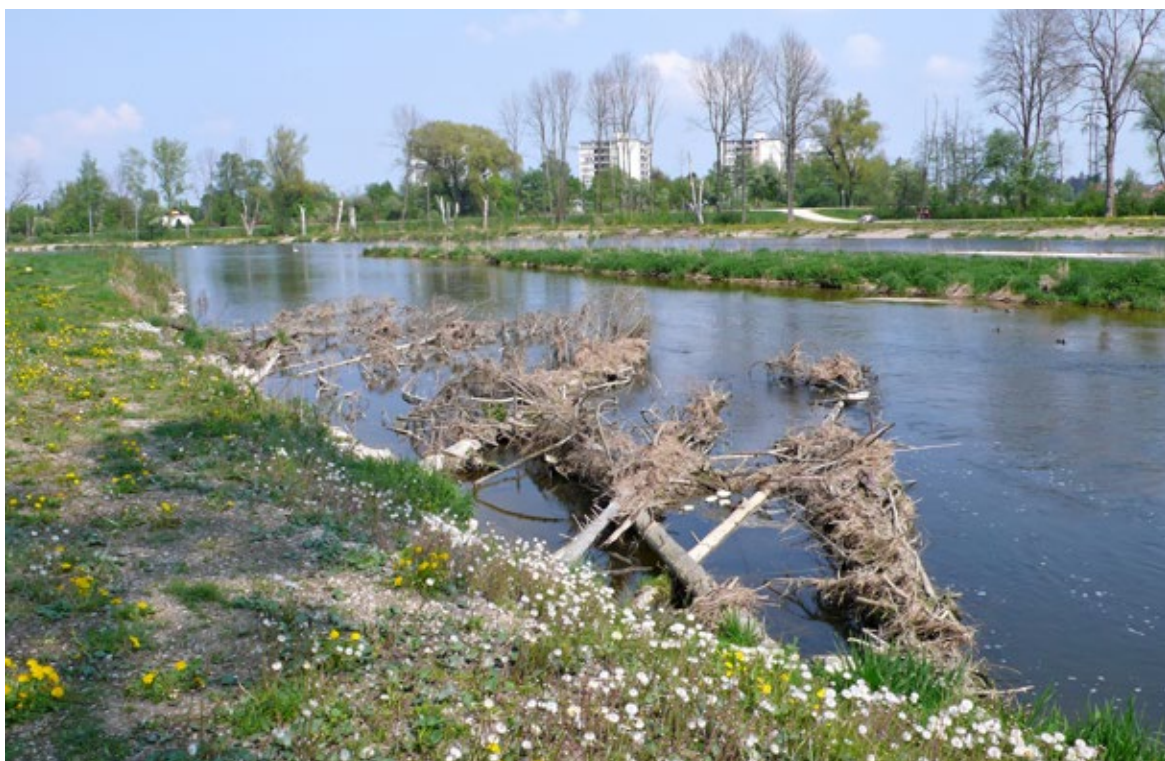
Obr. 4.26 Neodvřetené smrky, zapuštěné do břehu revitalizačního koryta řeky Wertach v Augsburgu; 2009.
