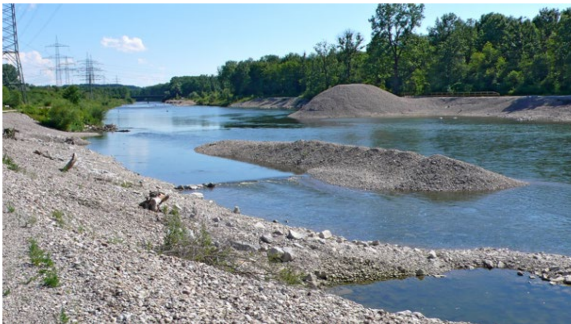
Obr. 3.18 Součástí revitalizace Iller bylo i navezení velké hromady štěrku za účelem „dokrmování“ řeky splaveninovým materiálem. (V České republice sice nemáme řeky alpského typu a není cílem revitalizací, nějaké takové „vyrábět“, zde uplatňovaný přístup ke splaveninovému režimu však je obecně inspirativní.)
