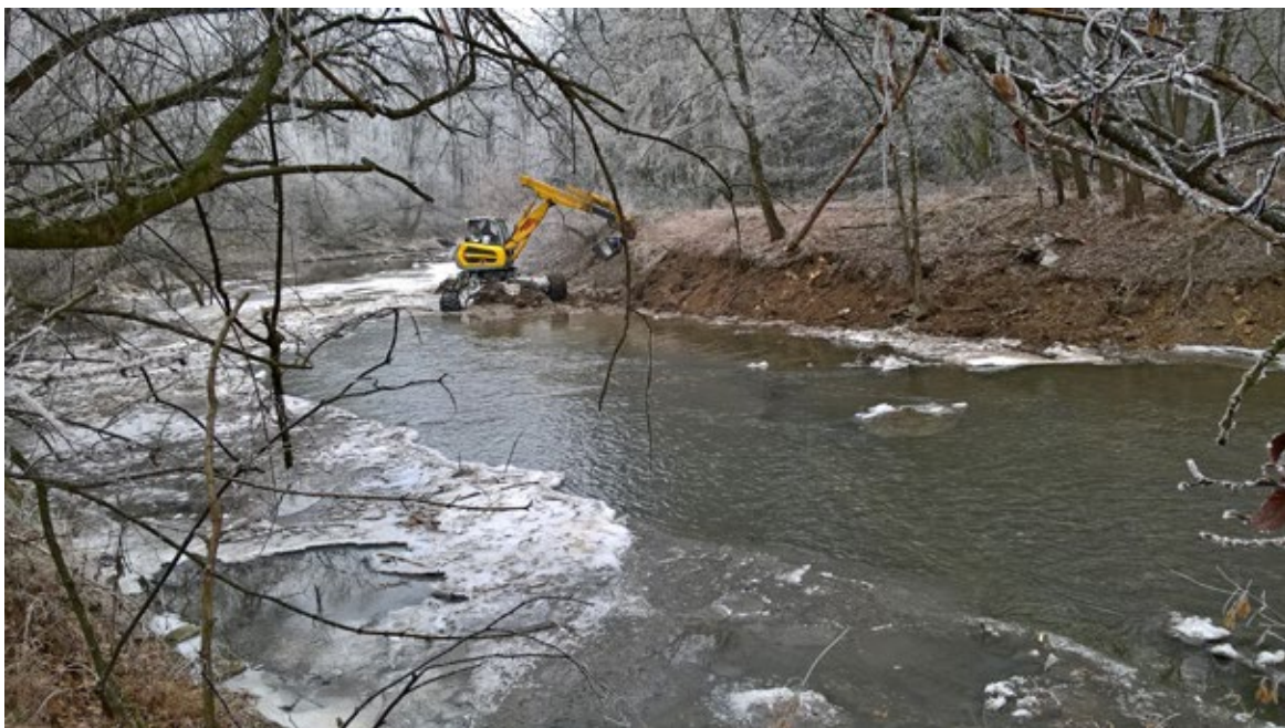
Obr. 6.15 Narušování opevnění břehu, které bylo v minulosti provedeno příliš pravidelným kamenným záhozem. Podpora samostatné renaturace Moravy u Štěpánova, akce Povodí Moravy, s.p., 2018 – 2019; dotováno v rámci OPŽP.
