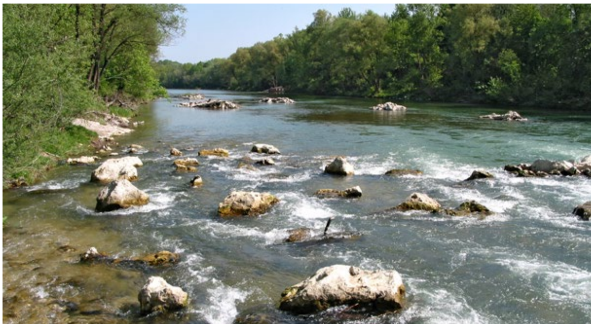
Obr. 6.27 Dílčí hydromorfologická opatření v korytě řeky Isar pod bavorským Mnichovem, kolem roku 2012. V popředí koryto poskládané balvanů, jejichž struktura se blíží dnové rampě. V pozadí členící kopice kamenů a balvanů, určené k postupnému rozebrání vodním proudem.
