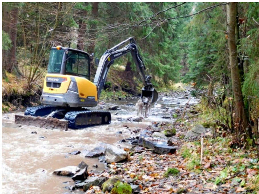
Obr. 6.8 Eko-reprofilací dochází k načechrání ztuhnutého materiálu, vytvoří se pestřejší dno a obnoví se kontakt živočichů s hyporeálem (podkorytím). Pokud se v rámci kompenzačních opatření přidají do toku další prvky jako tůně, pařezy, trdliště, plůtky apod., může být zasažený úsek dokonce ještě rozmanitější než před zásahem. (Foto M. Kubín)
