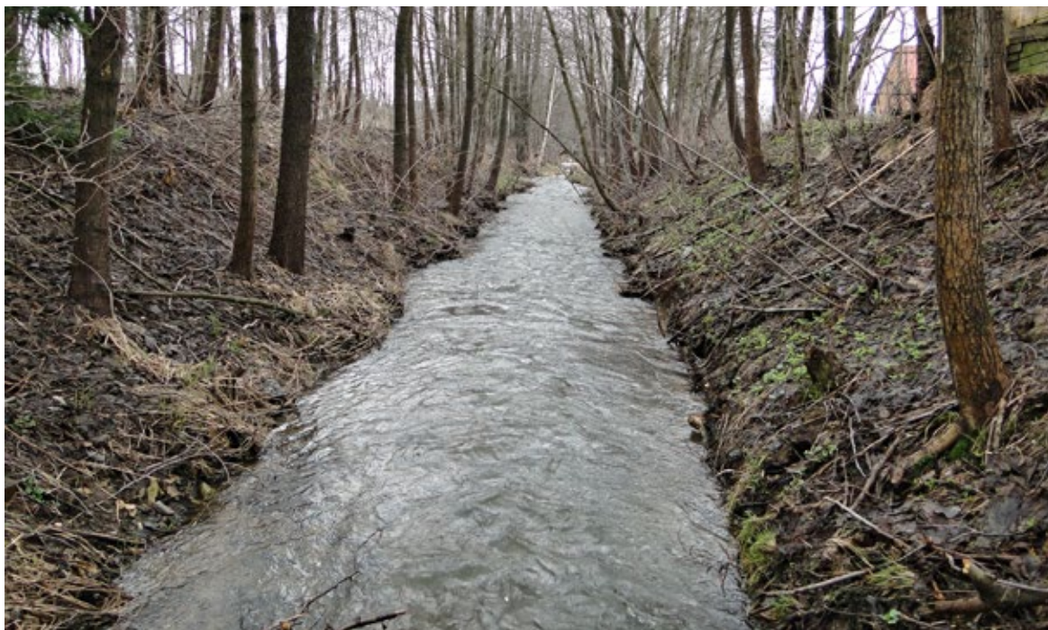
Obr. 1.15 15 Naddimenzované technicky upravené koryto potoka Slubice nad obcí Chlum za průtoku jarních vod. Pokud by se jednalo o přírodě blízké koryto, obdobný průtok by vyběžil a rozlil by se do nivy. Plocha průtočného profilu 7,42 m 2 . (Foto K. Kujanová)
