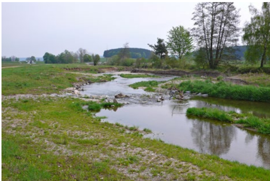
Obr. 5.24 Revitalizace koryta říčky Mindel v zátopové ploše suché nádrže nad bavorskou obcí Dirlwang. Není důvodu, aby říčka nemohla v tomto prostoru „dělat cokoliv“. Pohled v roce 2009. Investor a provozovatel Vodohospodářský úřad v Kemptenu.
