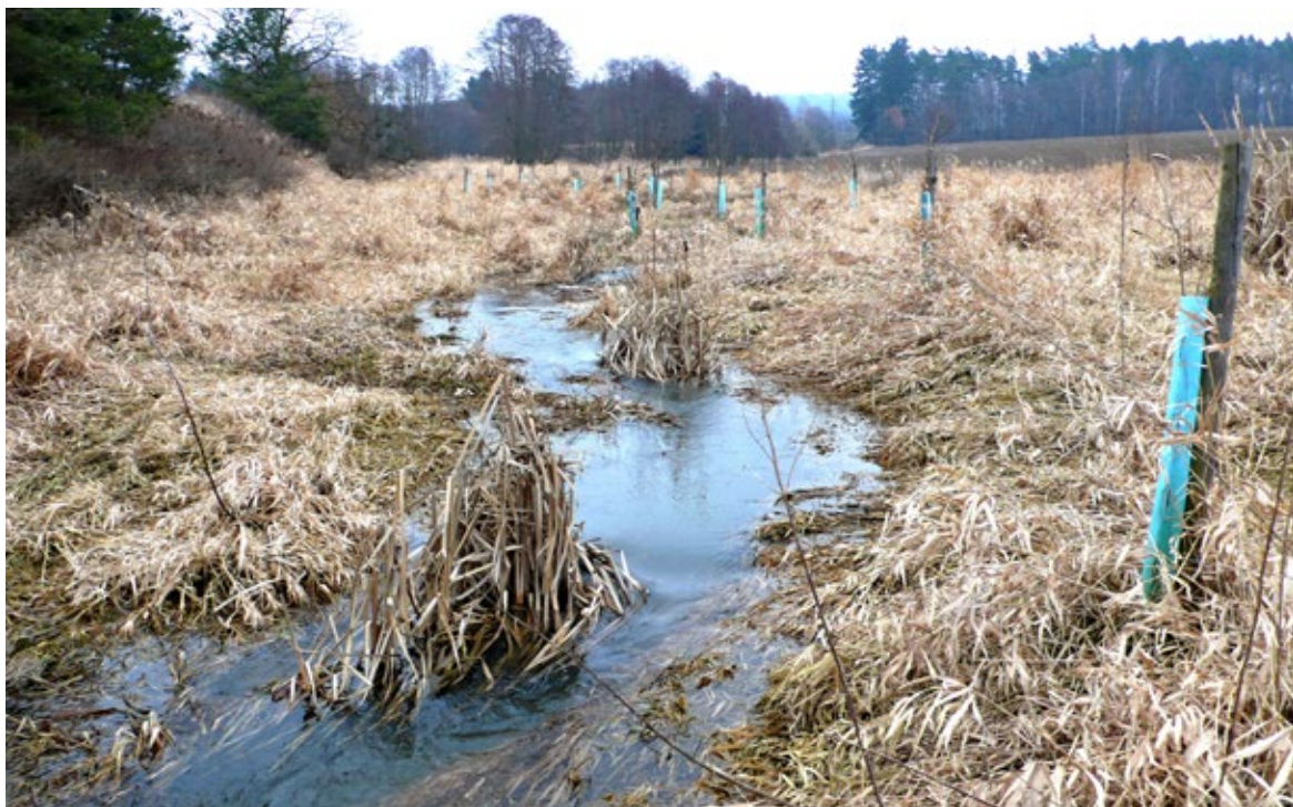
Obr. 4.10 Revitalizační koryto Boreckého potoka kolem roku 2010. Zanášením a zarůstáním se koryto dál příhodně změlčuje, což přispívá k ekologicky přínosnému zamokření okolní nivní plochy. Tento proces ničemu nevedá, neboť se odehrává v pásu území, vyhrazeném pro revitalizaci.
