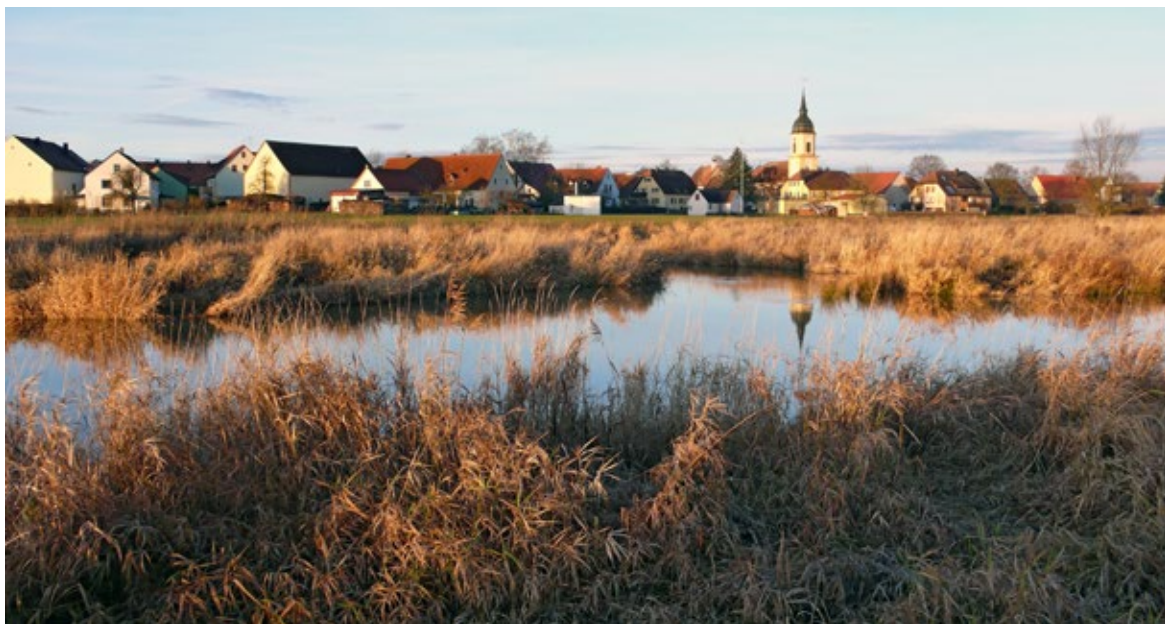
Obr. 5.10 Altmühl u Aha v prosinci 2009. Nálada připomíná jihočeské rybníky, jde však o vodohospodářskou stavbu přírodě blízkého říčního koryta, která sledovala cíle zlepšení ekologického stavu řeky a zároveň protipovodňové ochrany.
