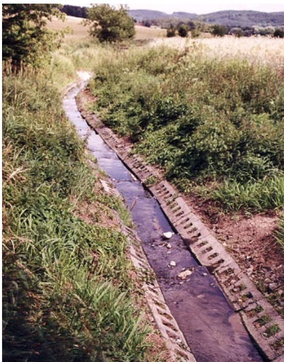
Obr. 4.50 Lhotecký potok na Příbramsku v roce 2000, před pokusnou revitalizací. Typický „meliorační licho- běžník“ s opevněním betonovými prvky.
