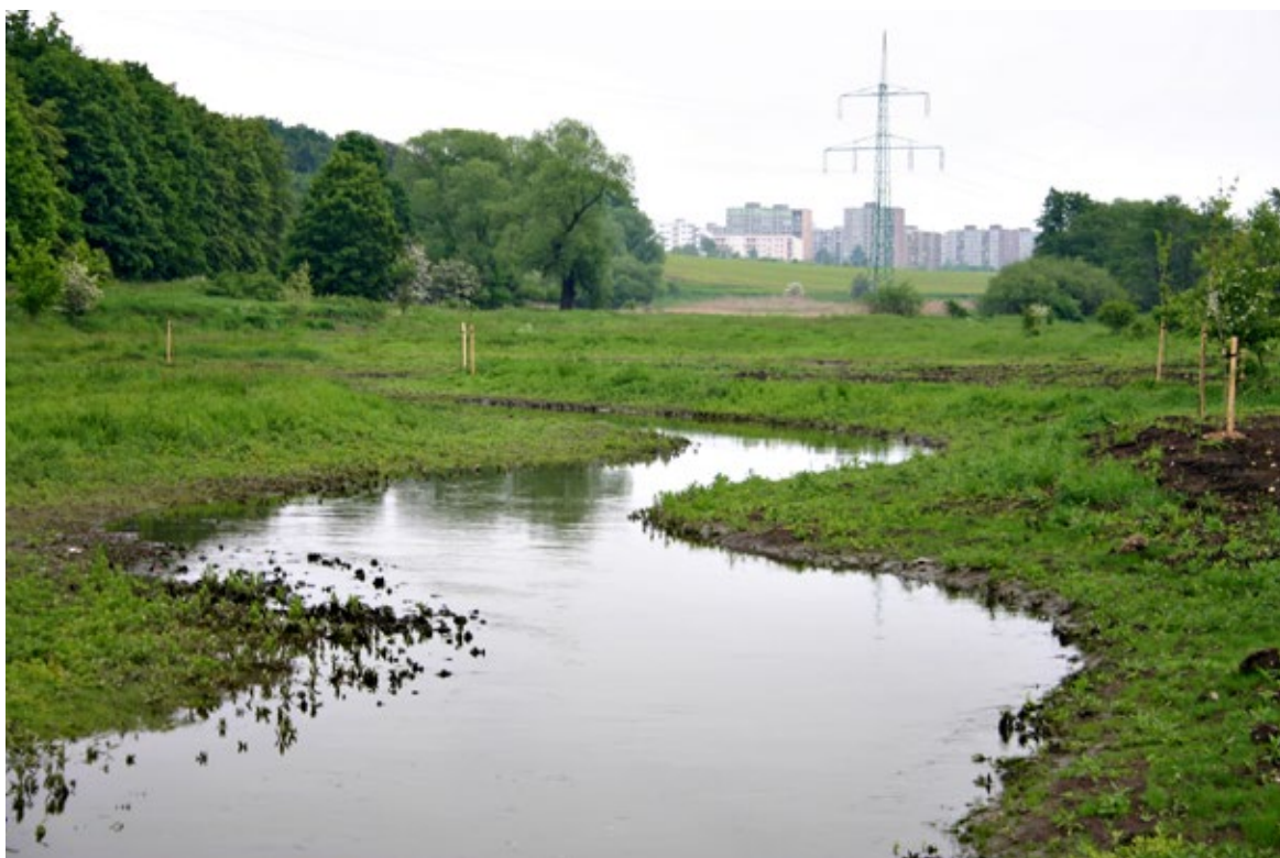
Obr. 5.31 Nové koryto Rokytky v ploše poldru Čihadla, jaro 2009. Základ úspěšného řešení: malá průtočná kapacita, velký poměr šířky k hloubce koryta, velká tvarová členitost. V pozadí sídliště Černý Most.
