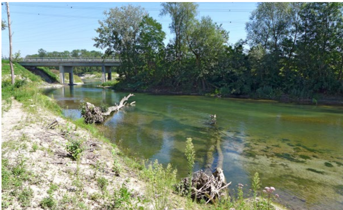
Obr. 6.41 Revitalizace řeky Traisen v Rakousku, provedena 2016, pohled v roce 2017: Hydrotechnicky opovážlivá instalace stromových výhonů do revitalizačního koryta řeky nad silničním mostem. Stromy jsou kotveny ocelovými lany ke kolíkům, zaraženým v břehu. Výhony v této pozici odklánění proud od břehu nad mostem, který má být chráněn, vytvářejí stanoviště pro vodní faunu a podporují vznik úplavových tůní.
