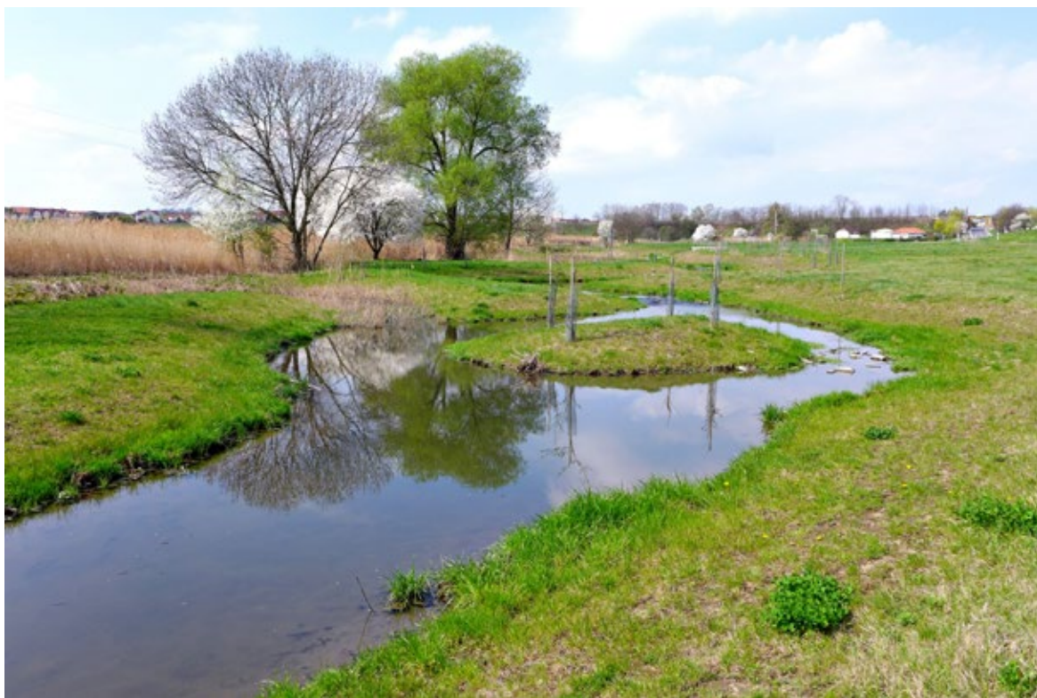
Obr. 4.34 Rozdvojení koryta s ostrůvkem (revitalizace Litovického potoka, Hostivice, 2016) sympaticky posiluje členitost revitalizačního koryta. Jde však o prvek v podstatě nepřírozený a vodní tok má následně tendenci jedno z ramen preferovat a druhé nechat zaniknout. Rozdvojení se tedy uplatní zejména v přírodně neautentických intravilánových revitalizacích. Pokud má být dělení průtoků trvanlivé, musí být vhodně stabilizováno a musí o ně být pečováno v rámci následné údržby.
