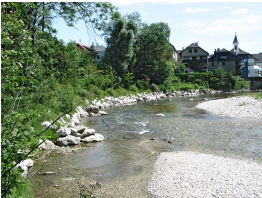
Obr. 6.34 Intravilánová přírodě blízká úprava Vöckly ve Vöcklabrucku v Rakousku, 2007: V tomto místě bylo technické opevnění nárazového břehu nahrazeno přírodě bližší rovnalinou z velkých kamenů s několika odřazecími výhony.
