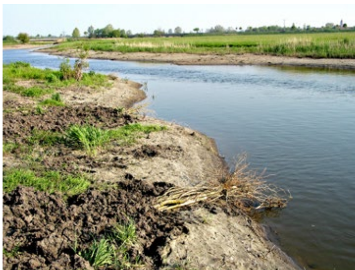
Obr. 4.24 Stabilizace, členění a zároveň ozelenění revitalizačního koryta bavorské řeky Altmühl (2006) svazky živých vrbových větví, zakládaných do šikmých zářezů v břehu. Zhruba polovina délky svazků je zasypána zeminou.
