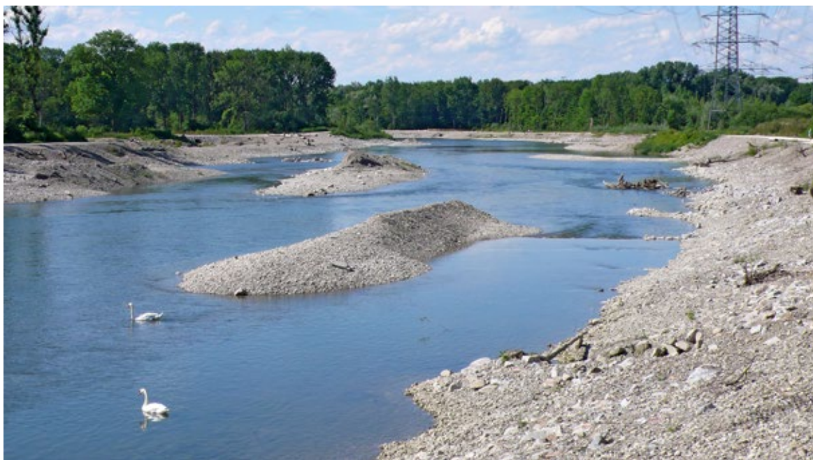
Obr. 3.17 Etapa revitalizace řeky Iller, tekoucí z Alp, u Vöhringen na hranici Bavorska a Bádenska-Württemberska z roku 2014. Revitalizace reaguje mimo jiné na úbytek splavenin v řece, který je důsledkem zejména technických úprav a výstavby jezů a nádrží. Při rozvolňování koryta byl štěrkový materiál ze stran hrnut do řečiště a zčásti ponechán v hromadách, ze kterých jev bude říční proud postupně odebírat.
