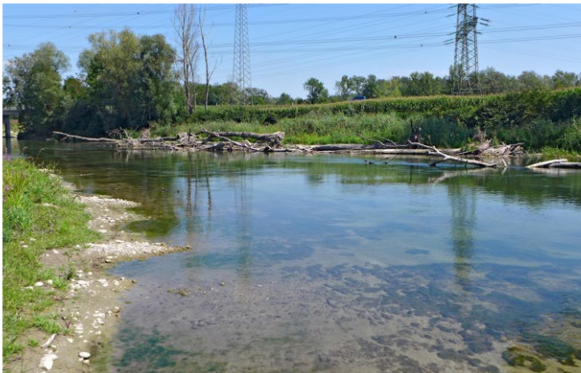
Obr. 6.42 Sestava kmenů, umístěná do nárazového břehu revitalizačního koryta Traisen, který má být chráněn. Současně dobré stanoviště vodní živěny.
