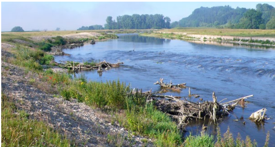
Obr. 4.25 Struktury mrtvého dřeva, použité ke stabilizaci a rozčlenění břehu revitalizačního koryta Dunaje u Hundersingen. Zatím zřejmě největší revitalizace v Bádensku - Württembersku byla provedena v roce 2012. Již v roce 2014, kdy byl pořízen tento snímek, bylo dřevo dost slehlé a olámané a pohled na něj vyvolával otázku, proč nebylo rovnou použito podstatně více materiálu. I v německých zemích se musí používání říčního dřeva jen postupně prosazovat proti někdy více, někdy méně opodstatněným výhradám.
