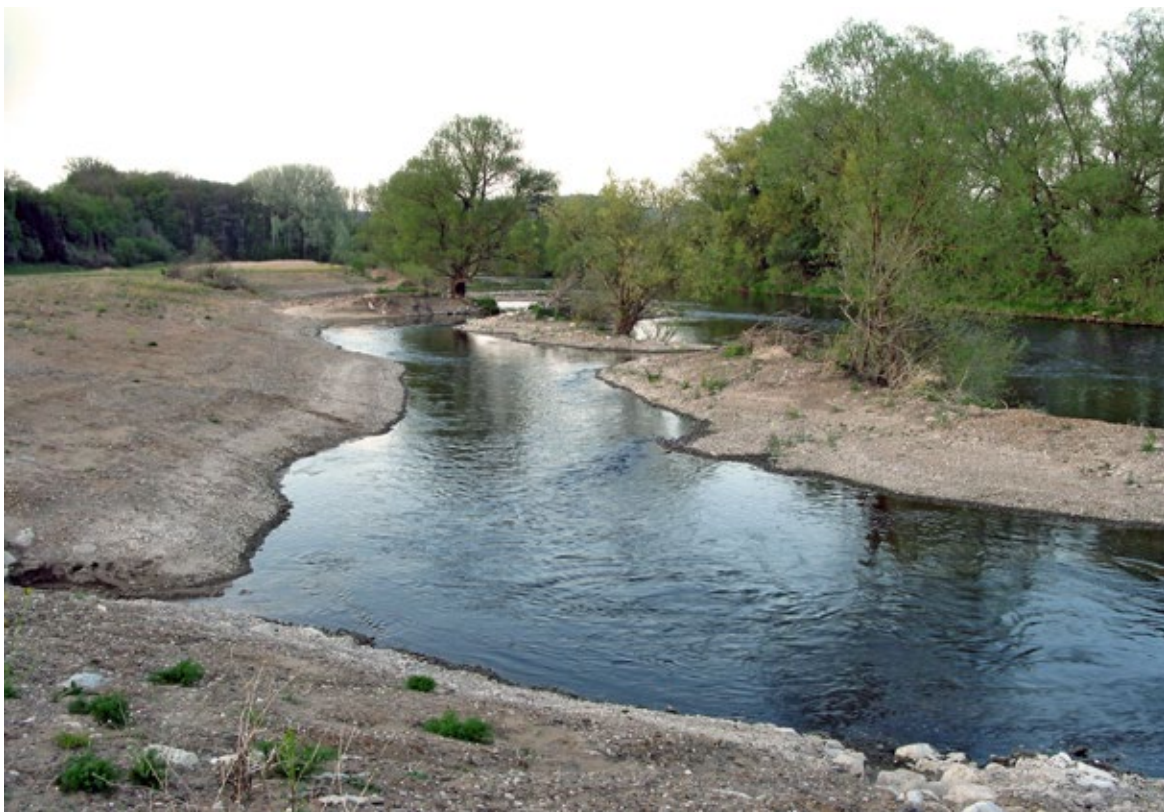
Obr. 6.10 Přírodě blízké rozvolnění koryta nesplavného Mohanu u Wiesenu v Bavorsku jako ze zákona plynoucí ekologická kompenzace za výstavbu nové železnice napříč údolím. Hodnotnější stromy a keře z břehového porostu jsou zachovány na ostrůvcích v někdejší břehové linii. Pohled po realizaci v roce 2012.
