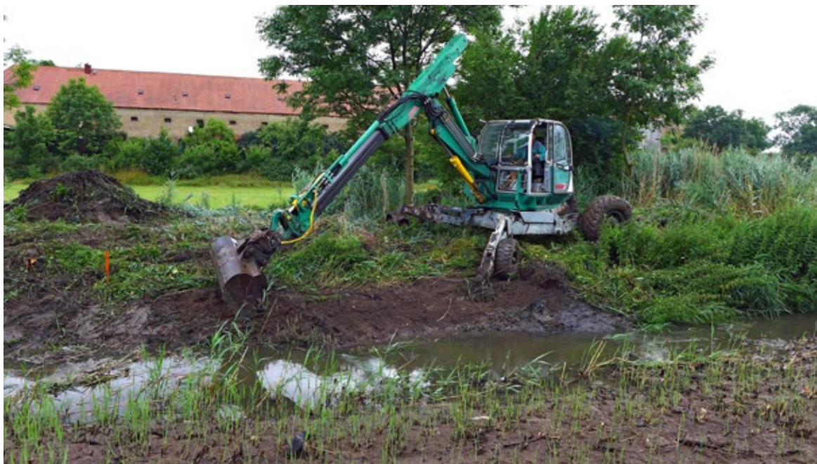
Obr. 6.12 Nejskromnější formát přírodě blízkého rozvolnění koryta – nepravidelné tvary vytvářející odtěžení úživných zemín s ruderalní vegetací ze břehů technicky upraveného koryta (nejspíše kombinované s odstraněním technického opevnění ze dna). Takto může vypadat minimalistní revitalizace v úseku, kde není možné zasahovat mimo pozemky současného koryta. Zde dílčí úsek revitalizace Radotínského potoka pod Tachlovicemi; 2017; akce Povodí Vltavy, s.p., dotovaná v rámci OPŽP.
