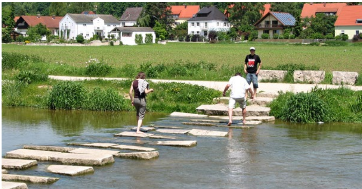
Obr. 4.60 Intravilánová úprava říčky Sulzach v bavorském Beilngries, cca 2009. Stupákové přechody jsou rámcově pokládány za přínosné prvky hlavně intravilánových revitalizačních staveb. Ovšem pravděpodobnost, že aspoň jeden stupák bude vlhký a kluzký nebo se bude viklat, není malá. Pád a zranění návštěvníka může pro zřizovatele přechodu znamenat velmi nepříjemnou právní záležitost.
