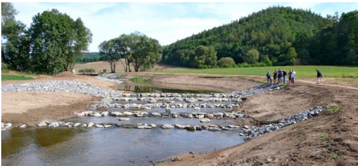
Obr. 4.20 Stabilizace místa soustředěnějšího spádu v revitalizačním korytě Loděnického potoka u Nenačovic (2015) dnovou rampou, která je pojednána jako těsný sled pěti příčných dnových balvanových pasů, proložený drobnějším kamenivem. Úhrnný podélný sklon nepřesahující 1 : 40 by měl být bezproblémový z hlediska migrační prostupnosti pro vodní živočichy.
