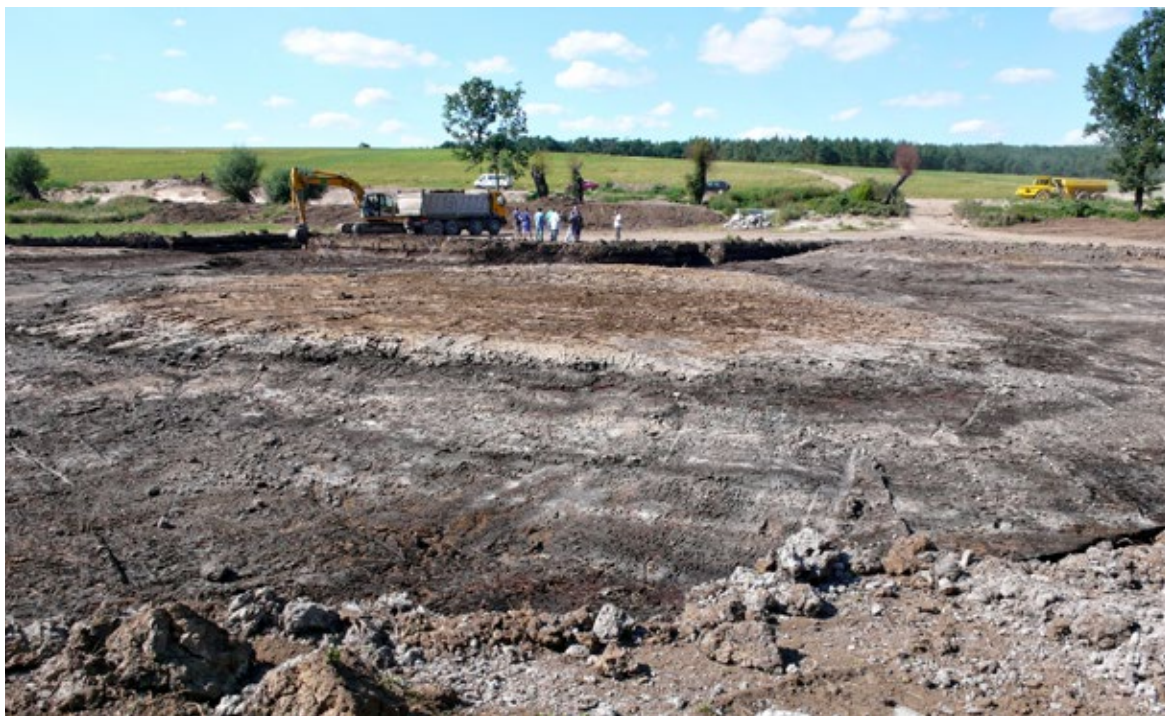
Obr. 7.5 Hloubení mokřadu v nivě Košáteckého potoka. Méně odtěžená plocha v popředí se stane ostrovem, vyhledávaným vodním ptactvem.
