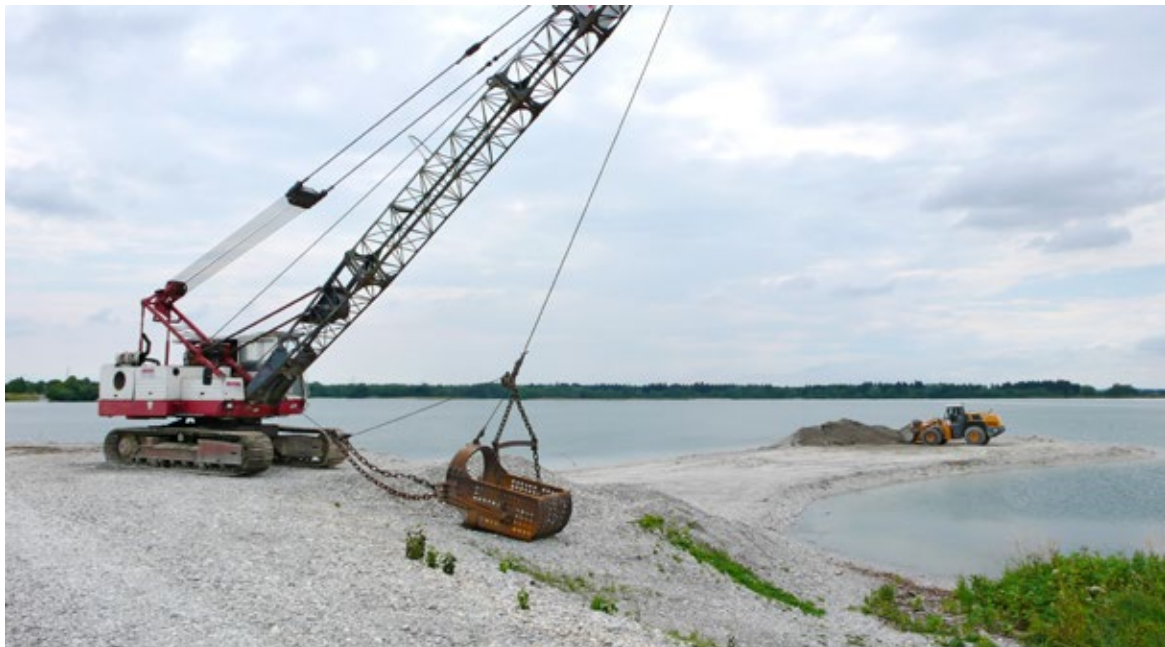
Obr. 6.2 Bavorsko, 2014; nádrž Mandichosee na řece Lech nad Augsburgem: Těžba štěrkových splavenin z nádrže.
