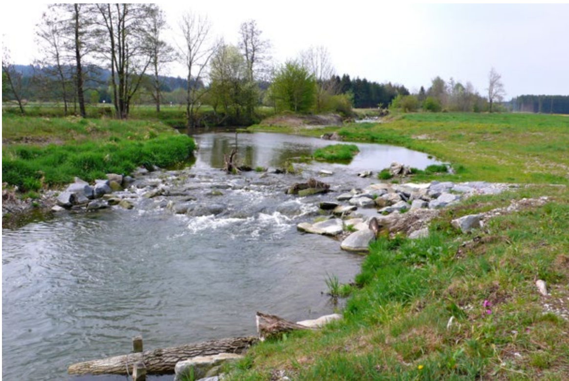
Obr. 4.17 Balvanový dnový pas - anebo již skluz? - v revitalizačním korytě říčky Mindel v zátopové ploše suché povodňové nádrže Dirlewang, pohled 2009. V popředí výhon ze stromového kmene. V zájmu stability by zřejmě neškodilo dolní okraj pasu přisypat drobnějším kamenivem.
