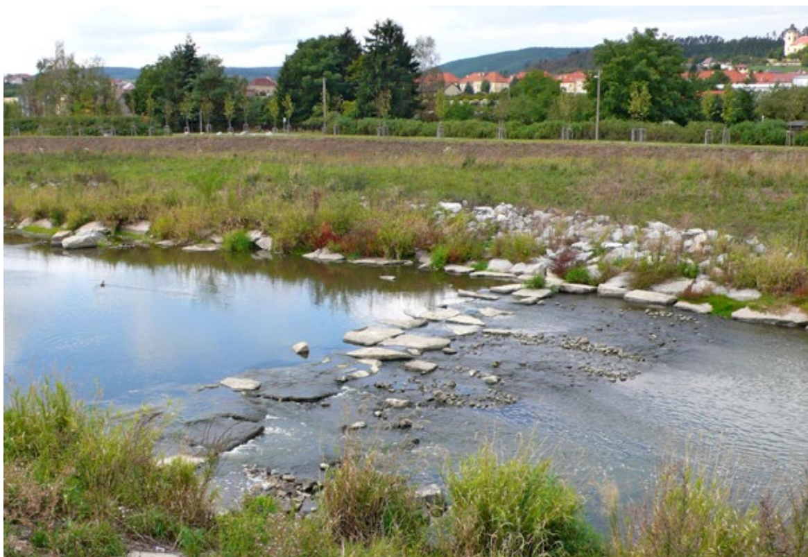
Obr. 4.16 Příčný pas z plochých balvanů ve dně intravilánového vodního toku (protipovodňová úprava Litavky v Králově Dvoře). Podobnost se stupákovým přechodem je spíše jen náhodná, povrchy balvanů jsou kluzké.
