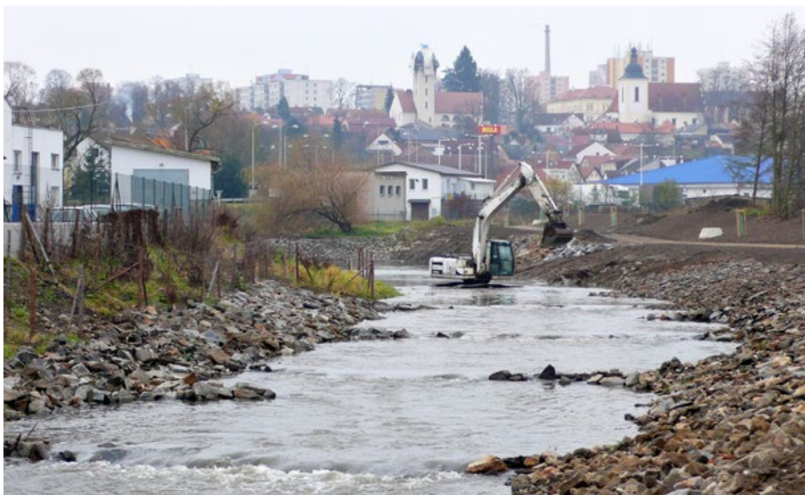
Obr. 2.10 Intravilánová revitalizace vodního toku - přírodě blízká protipovodňová úprava. Blanice ve Vlašimi, 2013.
