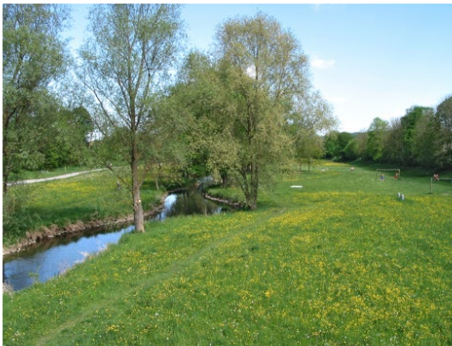
Obr. 5.16 Ochranné koryto pro povodňové přebytky řeky Isar bylo podél severního obvodu starobylého bavorského města Landshutu vyhloubeno v letech 1948 až 1955. Běžné průtoky dodává říčka Pfettrach, přítok Isary, kterou průleh zachytil. Ponejprv byla kyneta této říčky dle dobových zvyklostí provedena technicky, s přímou trasou a neměnným lichoběžníkovým průřezem. V roce 2001 byla dokončena revitalizace kynety, zde pohled v roce 2012. Celá plocha povodňového koryta běžně slouží jako městský park.
