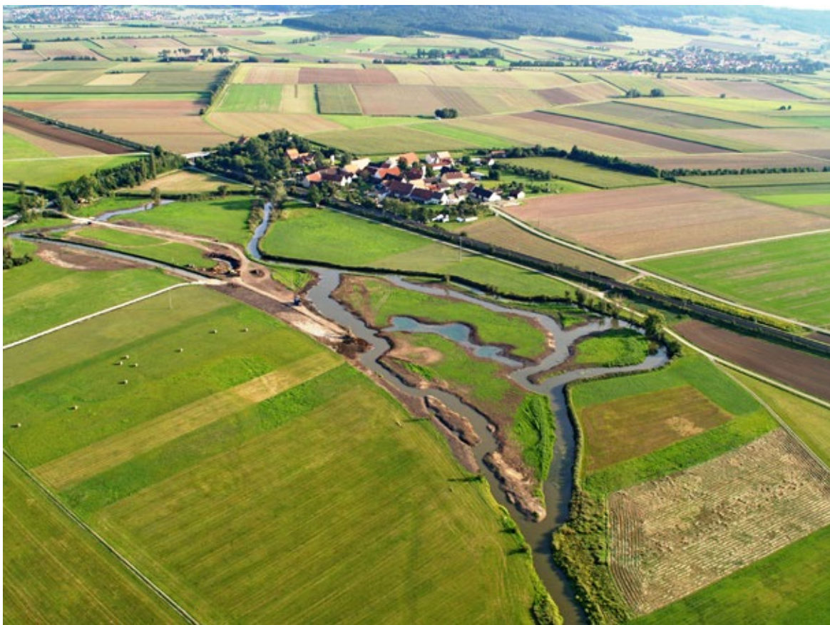
Obr. 3.15 Revitalizace horního toku středobavorské říčky Altmühl, kterou do roku 2016 po etapách prováděl Vodohospodářský úřad Ansbach, není přírodně autentická. Ovšem členitě tvarované a větvené přírodě blízké koryto, které nahradilo dřívější geometrizovaný kanál, významně zpomaluje povodňové i běžné odtoky. V tom lze spatřovat příspěvek revitalizace ke zlepšení průtokového režimu. Jestliže byly během dvacetileté kampaně takto zrevitalizovány téměř 23 kilometry toku, nejde již o příspěvek zanedbatelný. (Snímek Vodohospodářský úřad Ansbach)
