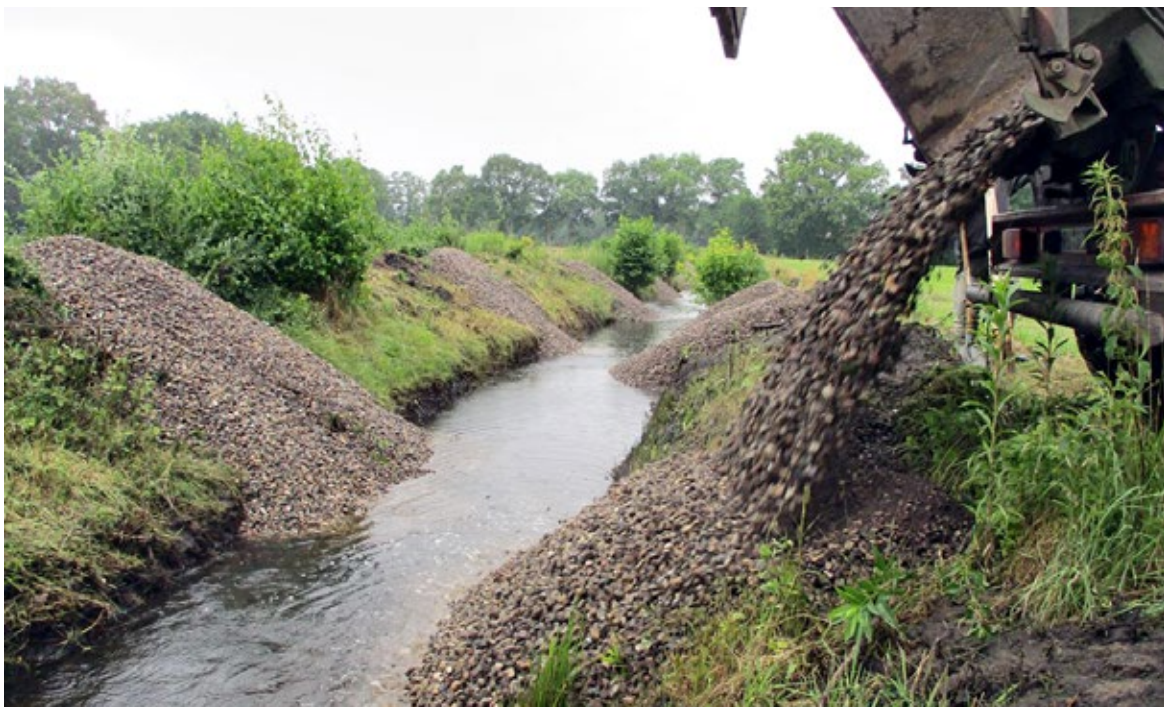
Obr. 6.18 Zlepšování stavu kanalizovaného koryta menšího vodního toku v severozápadním Německu střídavým vsypáváním hromad štěrku. (Foto L. Tent, Wedel)
