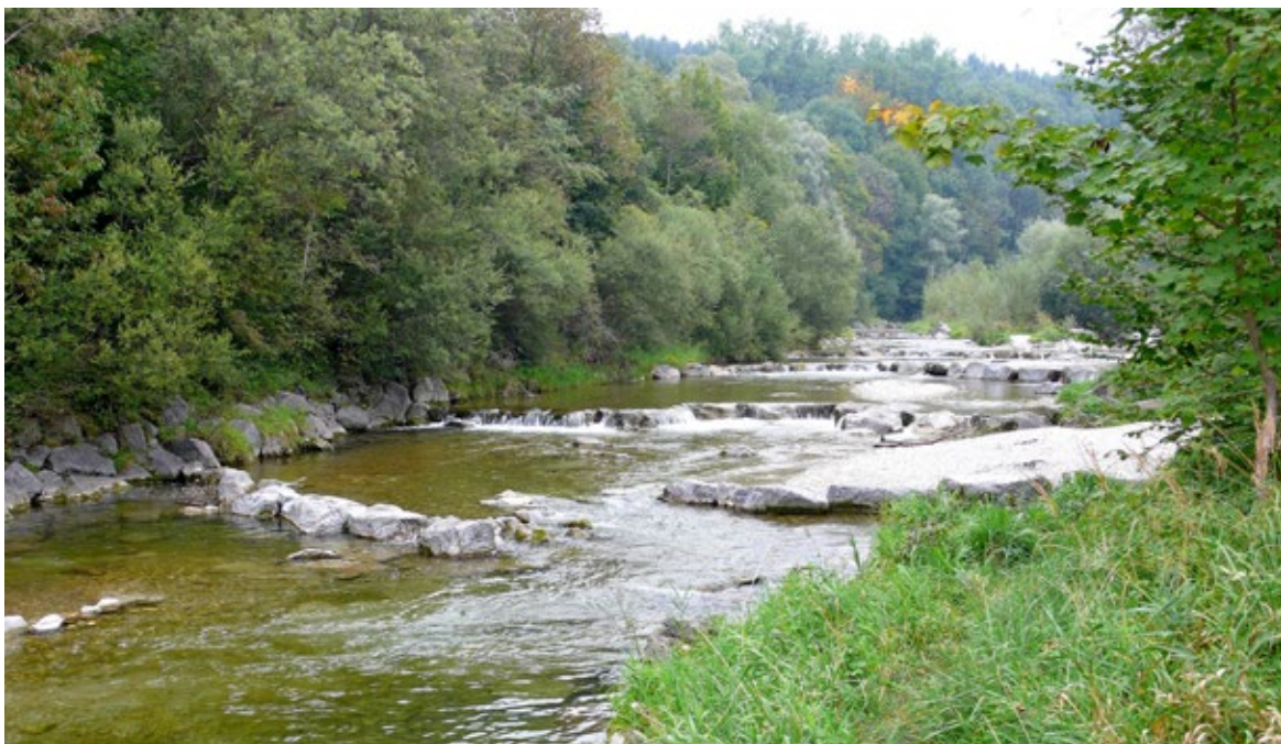
Obr. 6.32 Soustava balvanových výhonů, vyběhající do koryta střídavě z pravého a levého břehu, stabilizuje a zároveň rozčleňuje řečiště podhorské řeky Mangfall v Bavorsku; kolem r. 2010. Soustava vytváří vzdutí převážně hydrodynamického charakteru.
