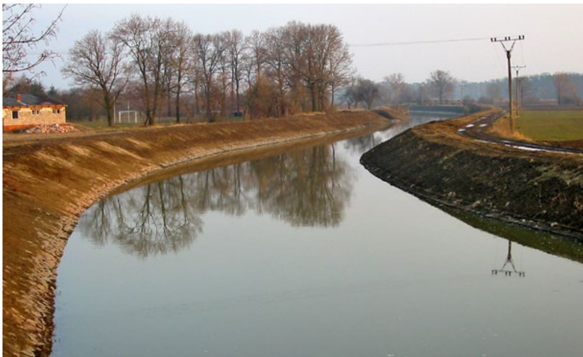
Obr. 2.5 Technicky upravená řeka. Dolní tok Doubravy u Záboří nad Labem byl upraven ve 30. letech 20. století, zde pohled po opravě úpravy v roce 2004.
