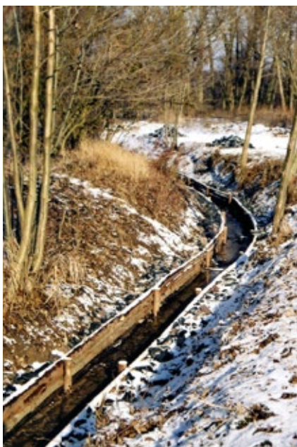
Obr. 4.46 Opevnění koryta laťovými plůtky není přírodě blízké, jakkoliv je provedeno z přírodního materiálu. Obdélníkový průřez takto upraveného koryta bez mělčín a přirozené návaznosti na břehy v podstatě nemá dnes v přírodě blízkém vodním stavitelství co pohledávat.
