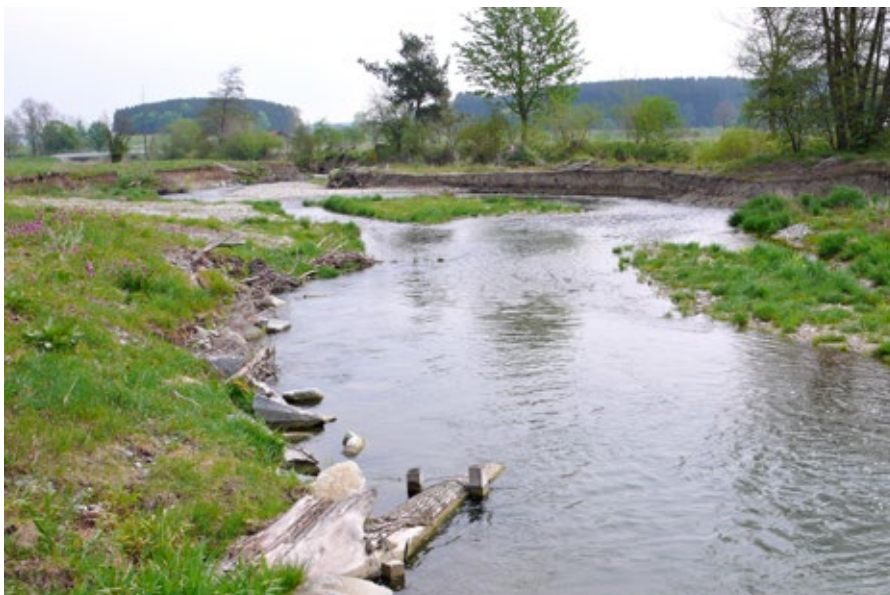
Obr. 4.29 Revitalizace říčky Mindel v zátopové ploše suché povodňové nádrže nad obcí Dirlewang v Bavorsku, 2009. V popředí poměrně nenápadná instalace stromového kmene, zapuštěného zčásti do břehu a fixovaného kolíky a lanem. Tento objekt měl podle všeho podíl na modelaci protějšího břehu většími průtoky, kde se brzy po dokončení stavby vytvořil strmý nárazový svah, příhodně nabízející hnízdiště břehovým ptákům.
