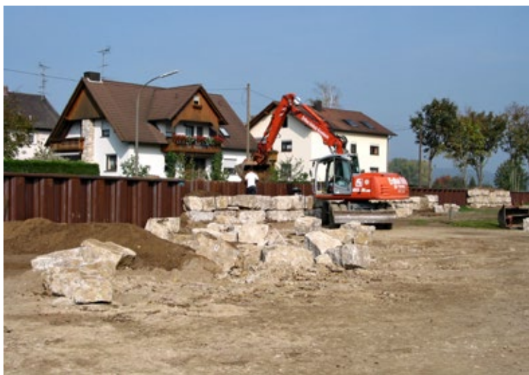
Obr. 5.39 Bavorská obec Ebing, ležící v nivě horního Mohanu, byla k roku 2007 obehnána protipovodňovou stěnou.
