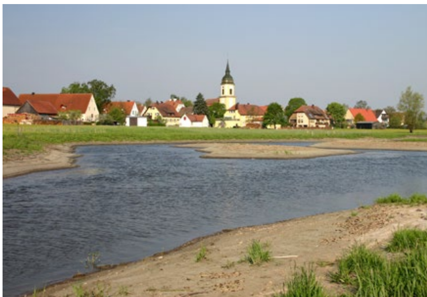
Obr. 5.8 Protipovodňové ochrany bavorské obce Aha bylo dosaženo obnovením širokého povodňového perimetru výrazným přírodě blízkým rozvolněním dříve technicky upraveného koryta řeky Altmühl. Pohled po realizaci v roce 2006.
