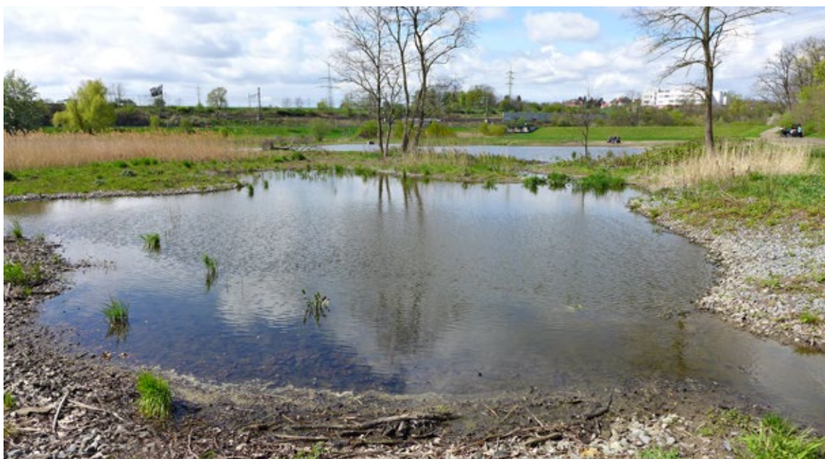
Obr. 5.33 Město Praha zátopovou plochu povodňové nádrže Čihadla po stránce krajinářsko-ekologické postupně dále vylepšuje. V roce 2017 se například podařilo vymístit reliktní cvičiště psů, odbagrovat nepatřičný násep, na němž se cvičiště nalézalo, a v uvolněné ploše vyhloubit lagunu mokřadního charakteru.
