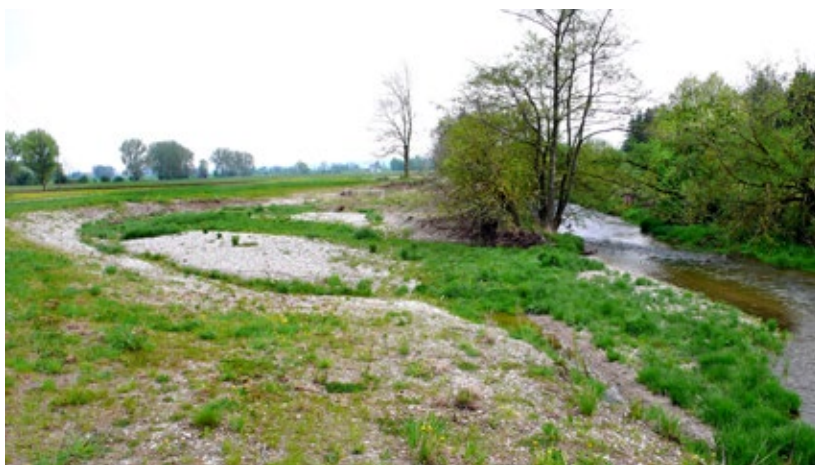
Obr. 4.30 Abychom revitalizaci bavorské Mindel nad Dirlewangem nepřechválili: V jednom dílčím úseku bylo v souběhu s meandrem nového revitalizačního koryta ponecháno staré přímé koryto, kdysi technicky upravené, ale během času již výrazně renaturované. Vodní proud záhy neodolal silám fyziky a vrátil se do starého přímého koryta, zatímco to nové zůstalo na suchu. (Pohled pouhý rok po revitalizaci, v roce 2009.) To asi nebylo záměrem revitalizátorů. Za povodní bude i nové koryto zaplavováno a do jisté míry reaktivováno, ale běžné průtoky se pravděpodobně budou držet přímé trati, která je po zanesení meandru také zřetelně nižší. Ovšem štěrkovisko opuštěného revitalizačního meandru může také nabízet zajímavá stanoviště, třeba některým z více než stovky druhů včel, obývajících ve Střední Evropě právě taková místa.
