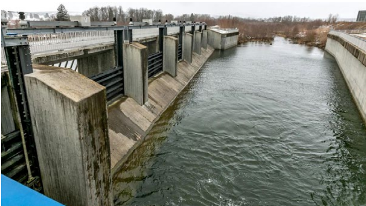
Obr. 5.26 Napouštěcí objekt přírodě blízkého poldru, vybudovaného po straně bavorské řeky Iller u Seifenu. Vzhledem ke korytu řeky (vlevo) jde o postranní přelivný objekt, přes který přepadají povodňové vody až od určité velikosti průtoku. Regulace se provádí nastavením hradidel v polích objektu. Vpravo pohled do vstupu přívodního kanálu poldru. Objekt Vodohospodářského úřadu v Kemptenu, postaven zhruba k roku 2008. (Zdroj snímku: Vodohospodářský úřad Kempten)
