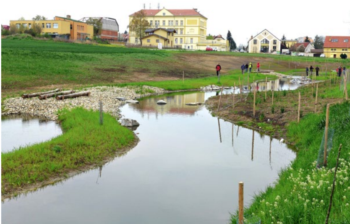
Obr. 4.64 Revitalizace Litovického potoka v zastavěném území Hostovic, realizace v roce 2015. Intravilánová stavba z vydlážděné strouhy v kopřivách udělala zelenou osu města a dosáhla nečekaných revitalizačních efektů. Sídlní tlak a požadavky spojené s rekreačním využíváním území, provedení v řadě aspektů spíše pragmatické, než morfologicky autentické, přítomnost výsadeb parkového charakteru a různých kulturních prvků – to jsou faktory, zakládající zvýšené nároky na údržbu. V takových situacích se osvědčuje dohoda mezi správcem vodního toku a příslušnou obcí v tom smyslu, že obec bude zajišťovat intravilánový nadstandard údržby.
