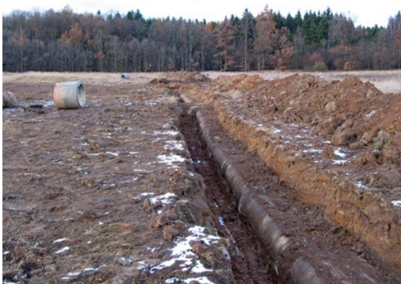
Obr. 4.38 Eliminace melioračního hlavníku podélným vykopáním. Revitalizace plochého, kdysi zamokřeného území v návaznosti na výstavbu malé vodní nádrže. Akce obce Lazska, okr. Příbram, dotovaná v rámci PRŘS, 2004.
