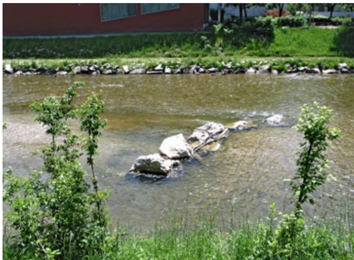
Obr. 6.25 Řádek balvanů, vložený do dna říčky. Regulované koryto v zastavěném území má přírodě blízké dno, ale celkově je tvarově ochuzené. Řada balvanů, položená šikmo napříč korytem, vytváří úkryty pro vodní živočichy a rozčleňuje proudění. V úplavu za balvany se vytvářejí malé tůně. Jednoduchá, laciná a účinná instalace. Jen by jich mohlo být víc a hustěji.
