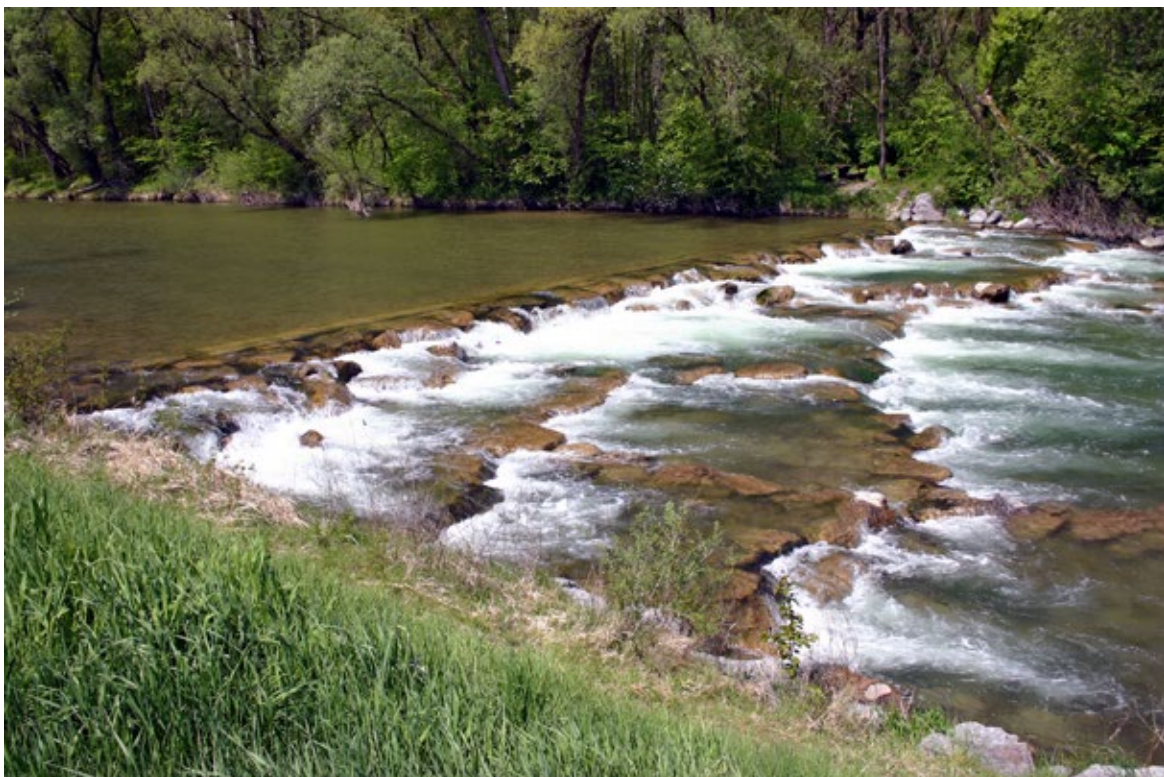
Obr. 6.23 Stabilizační rampa v korytě bavorské řeky Mangfall, 2008. V rámci částečné revitalizace byl někdejší spádový stupeň přestavěn v dnovou rampu, jejíž základ tvoří mřížovina balvanových pasů. Horní pas je přisazen k zachované přelivné hraně starého stupně. To je sice úsporné řešení, ale nese riziko, že po případném sklesnutí balvanitých pasů se obnoví nežádoucí přepad vody přes tuhou konstrukci někdejšího stupně. (Místní spády, resp. rychlosti proudění, patrné na obrázku, by mohly být problémem pro méně zdatné ryby, ale zde se jedná o pstruhovou vodu.)
