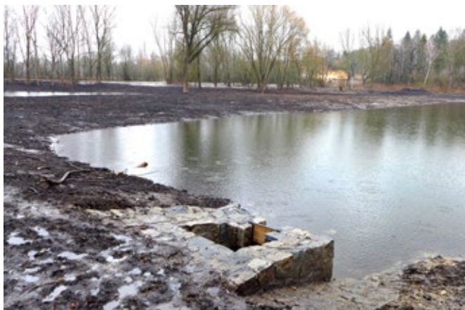
Obr. 7.16 Jedna z lagun soustavy Josefov II u Milovic, v popředí nízký požerák, umožňující regulování odtoku z laguny do potoka Mlynařice, ne však úplné vypuštění.
