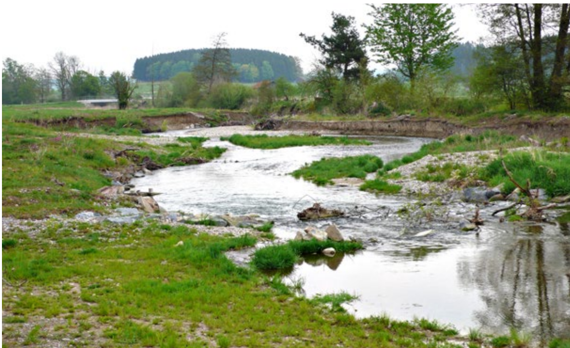
Obr. 3.12 Revitalizace říčky Mindel v zátopové ploše suché povodňové nádrže nad obcí Dirlawang v jihozápadním Bavorsku (pohled v roce 2008) byla svým provedením nespoutaná. Dala vodnímu toku velkou tvarovou a hydraulickou členitost i možnost dalšího vývoje.
