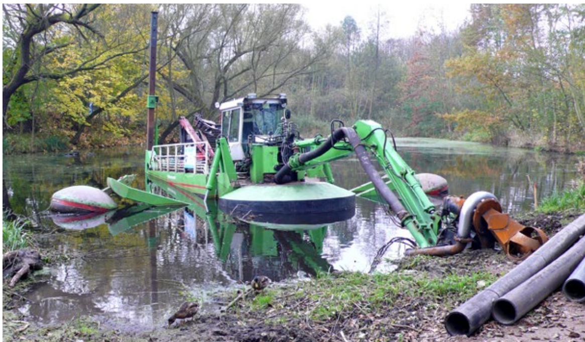
Obr. 7.21 Odbahňování soustavy vodních ploch ve starém labském rameni u Týnce nad Labem, 2015, akce města Týnce n.L., dotovaná v rámci OPŽP. Plovoucí sací bagr ve vyčkávací poloze, v popředí na pohyblivém rameni pracovní hlava s těžební frérou a čerpadlem směsi vody a sedimentu.
