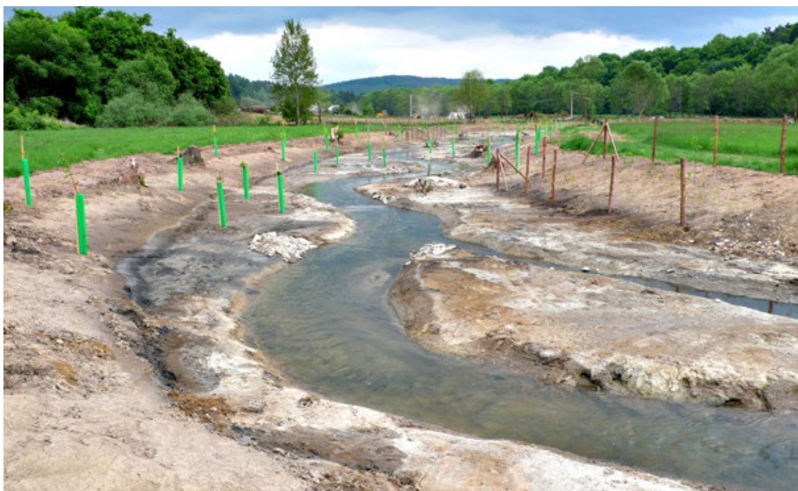
Obr. 2.9 Revitalizovaný potok - vodohospodářsky významný vodní tok. Loďnický potok u Nenačovic, 2015. Investor revitalizace Povodí Vltavy, s.p., dotováno v rámci operačního programu Životní prostředí (OPŽP). Orientační podélný sklon revitalizovaného koryta 1 : 300.
