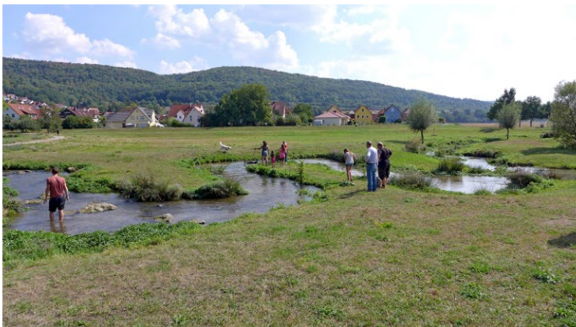
Obr. 5.20 Ochranné odlehčovací koryto (objekt I) v Ebermannstadtu. Zvlněná kyneta, vedoucí běžné průtoky, se uplatňuje jako potok v příměstském rekreačním parku, ve který se ochranné koryto vyvíjí.
