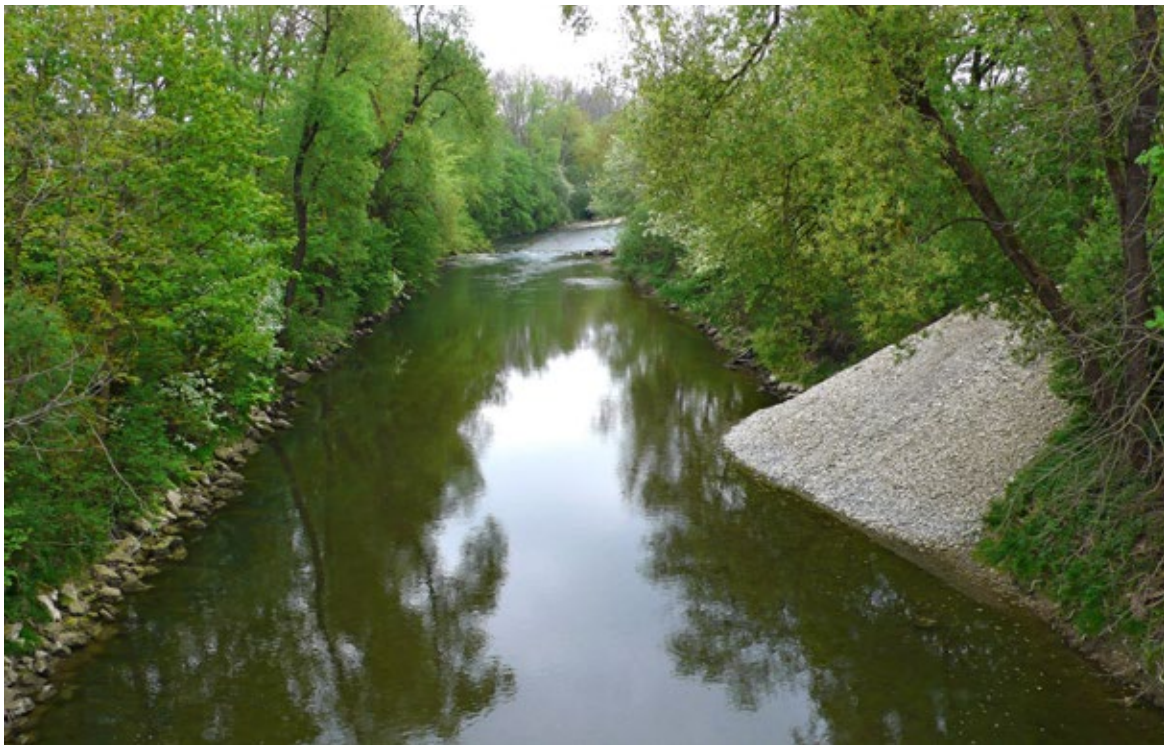
Obr. 6.4 Kaufbeuren v Bavorsku, 2009: Nejjednodušší způsob příkrmování technicky upravené řeky Wertach štěrky. Čeká se na větší průtok, který materiál roznese.
