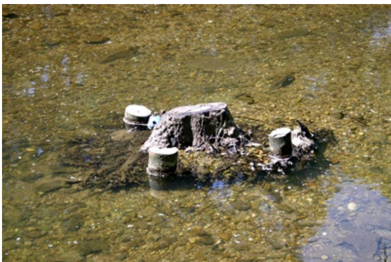
Obr. 6.29 Pařez s plochým kořenovým systémem, fixovaný ke dnu třemi kůly. Úkrytový prostor pod kořeny je pro ryby zajímavý, pařez může působit lokální dynamické vzdutí. Tento prvek se může osvědčovat tam, kde je snadné zarážet do dna kůly, jinak by nejspíš byl nepřiměřeně pracný.
