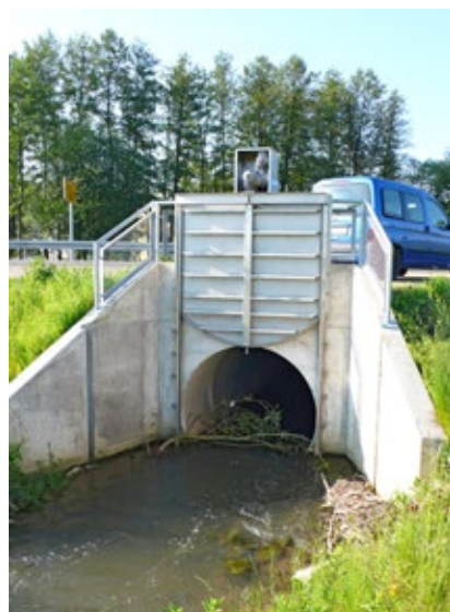
Obr. 5.18 Ochranný objekt na vstupu do starého koryta, procházejícího zástavbou obce Memmelsdorfu. Do obce by měl propouštět jenom neškodné průtoky. Uzávěr je vybaven motorem a dálkově ovládán.
