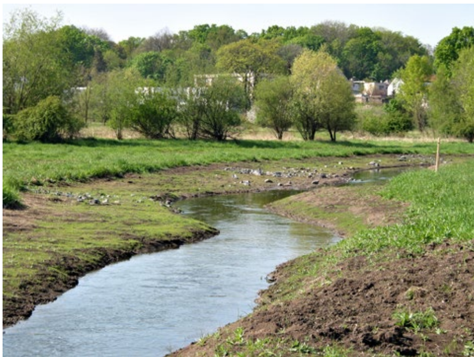
Obr. 5.30 Revitalizace dříve nesmyslně technicky upraveného koryta Rokytky v povodňové suché nádrži Čihadla v Praze. Nádrž byla postavena v 70. letech 20. století v technickém pojetí, první etapu revitalizace zátopové plochy provedl Magistrát hl. města Prahy v roce 2008, financováno z prostředků města.
