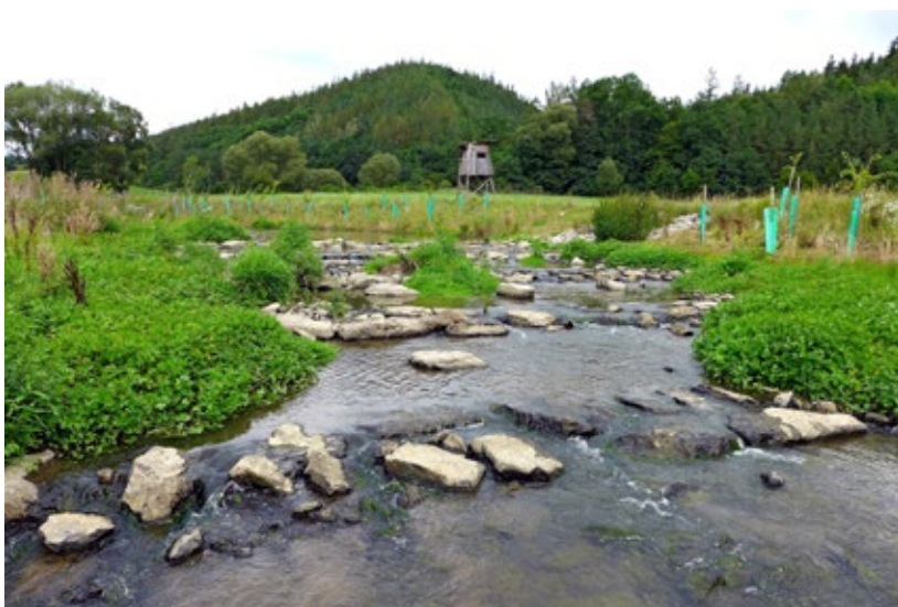
Obr. 4.20 Stabilizace místa soustředěnějšího spádu v revitalizačním korytě Loděnického potoka u Nenačovic (2015) dnovou rampou, která je pojednána jako těsný sled pěti příčných dnových balvanových pasů, proložený drobnějším kamenivem. Úhrnný podélný sklon nepřesahující 1 : 40 by měl být bezproblémový z hlediska migrační prostupnosti pro vodní živočichy.
