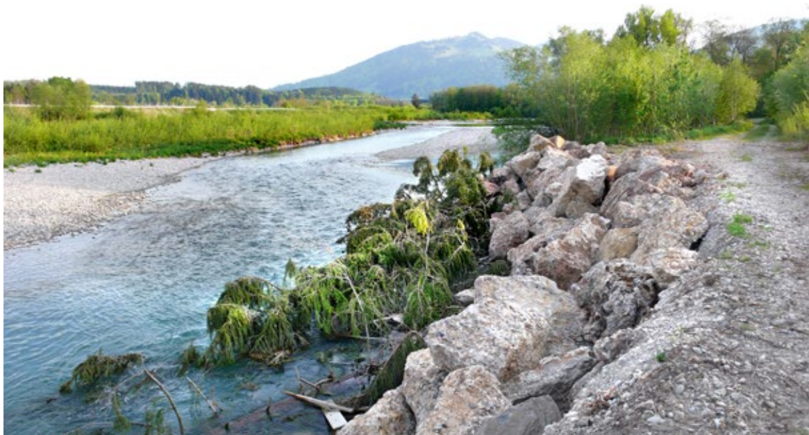
Obr. 6.40 Z postupného vylepšování revitalizace řeky Iller v JZ Bavorsku, kolem roku 2010: Ke břehu byly naskládány celé neodvětvené smrky a zatíženy balvany. Přírodě blízká stabilizace břehu, která zároveň rozšiřuje nabídku stanovišť pro vodní faunu.
