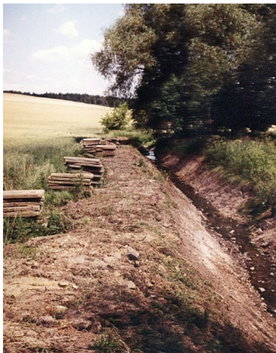
Obr. 4.51 Po roce 2000 provedla tehdejší Státní meliorační správa pokusnou částečnou revitalizaci Lhoteckého potoka. (Akce hrazená z provozních prostředků SMS.) Nejprve bylo odstraněno opevnění betonovými prvky.
