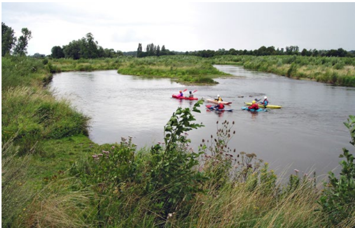
Obr. 5.11 „Povodňový zpomalovač“ – přírodě blízké rozšíření, zde dokonce s rozdělením, koryta řeky Inde, severozápadní Německo, 2005.
