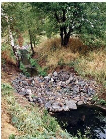
Obr. 4.52 Nebyla měněna trasa koryta Lhoteckého potoka, odstraněné opevnění bylo nahrazeno sledem poměrně vysokých sedel (dnových pasů) z netříděného lomového kameniva.
