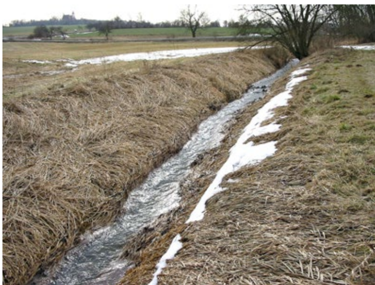
Obr. 4.40 Hluboké a přímé technicky upravené koryto potoka Brodce u Načeradce před revitalizací.
