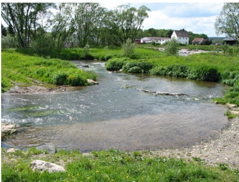
Obr. 3.34 Přírodě blízká rybí cesta na Mohanu v Oberwellenstadtu, Bavorsko, 2006. Obtokové koryto po pravé straně jezu má dostatek prostoru a tak mírný podélný sklon, že mohlo být řešeno jako přírodě blízké meandrující koryto. Zde nehrozí problémy s příliš velkými rychlostmi proudění ve štěrbinách mezi balvany ani ztráta funkčnosti ucpáváním štěrbin splávním, jako u tradičních konstrukcí rybích přechodů. Pokud je také hlavně dolní vstup do této cesty vhodně situován vůči řece a jezovému tělesu, půjde o velmi spolehlivý typ objektu, zajišťujícího migrační prostupnost vodního toku i při výrazně kolísajících průtocích.
