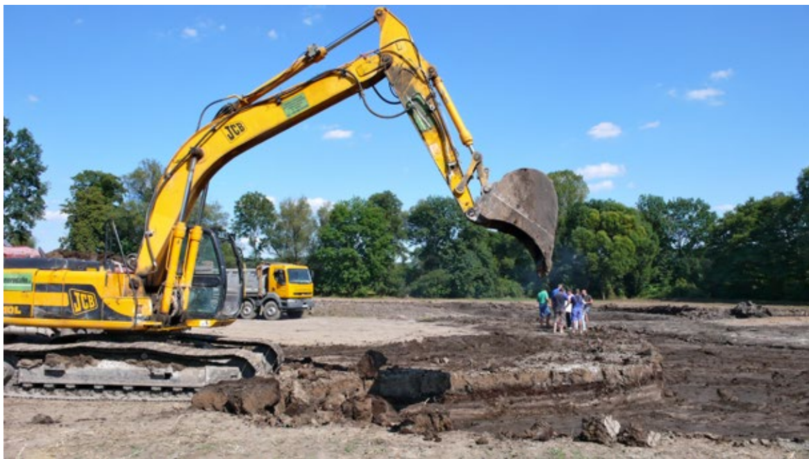
Obr. 7.4 Hloubení mokřadu v nivě Košáteckého potoka na Mělnicku, akce soukromého investora, 2012, dotováno v rámci OPŽP. Investor budoval o několik kilometrů níže dva rybníky a pro jejich napájení vodou obnovoval někdejší mlýnský náhon. V nivním prostoru mezi náhonem a korytem potoka nechal vyhloubit rozsáhlý a členitý biotopní mokřad.
