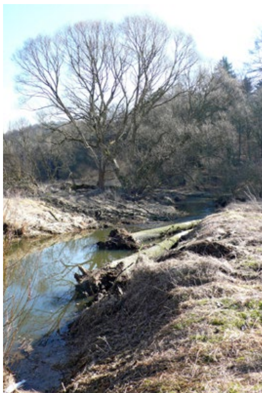
Obr. 6.6 Nekořená tížná instalace kmenů k rozčlenění koryta a vytvoření úkrytů.
