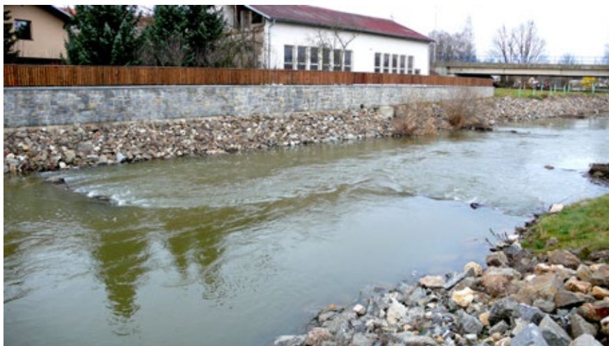
Obr. 6.36 Bližší pohled na úsek Blanice ve Vlašimi z předcházejícího snímku, za svěžího jarního průtoku, běžně vzdutého níže ležícím jezem. Patrný je vliv výhonů na diverzifikaci proudění.
