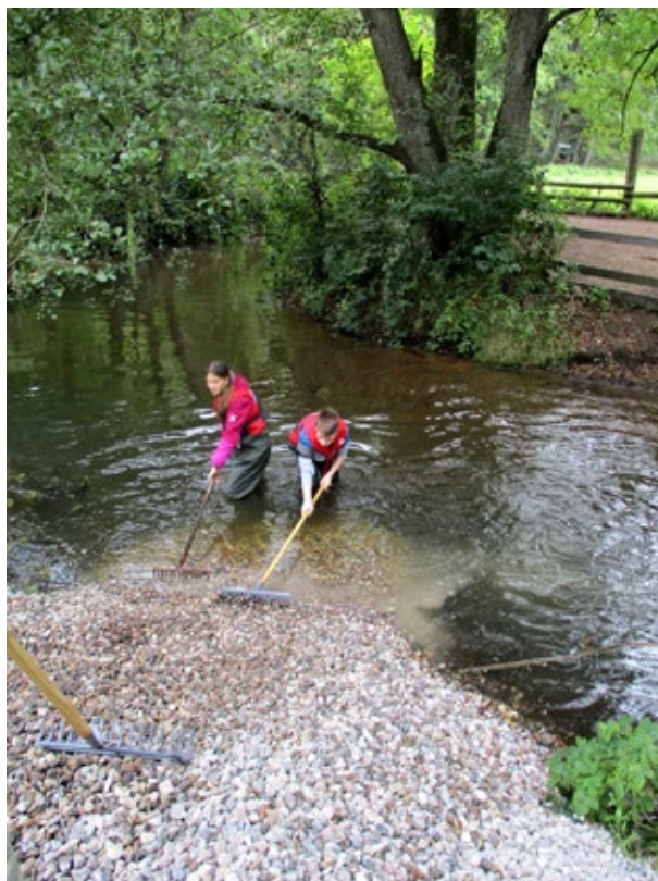
Obr. 6.17 Nadšenci v rámci občanského patronátu nad říčkou rozhrabují štěrky, vsypávané do koryta za účelem podpory strukturální členitosti a rybích trdlišť. (Foto L. Tent, Wedel, severozápadní Německo.)
