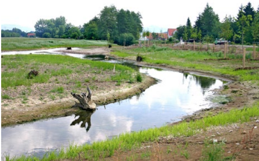
Obr. 5.21 Povodňové ochranné koryto na okraji Memmelsdorfu po dokončení v roce 2008. Vlastní koryto je velmi mělké a členité, za povodní se předpokládá zatopení většiny plochy mezi okrajem obce a dálnicí.
