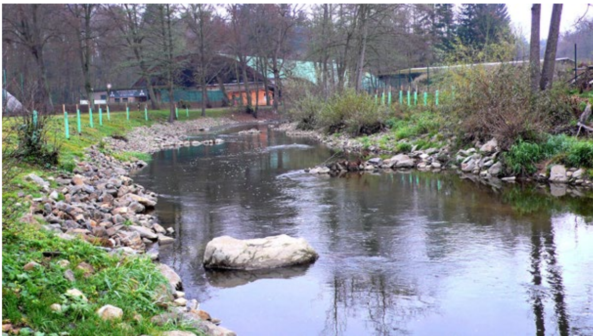
Obr. 3.13 Pragmatickou formu členitosti intravilánového koryta představují balvano-kamenité výhony, umísťované střídavě k pravému a k levému břehu. Zvláště za větších průtoků zvlňují proud, čímž vznikají místa s různými směry a rychlostmi proudění vody. Blanice ve Vlašimi, 2015; akce Povodí Vltavy, s.p.; dotovaná v rámci OPŽP.
