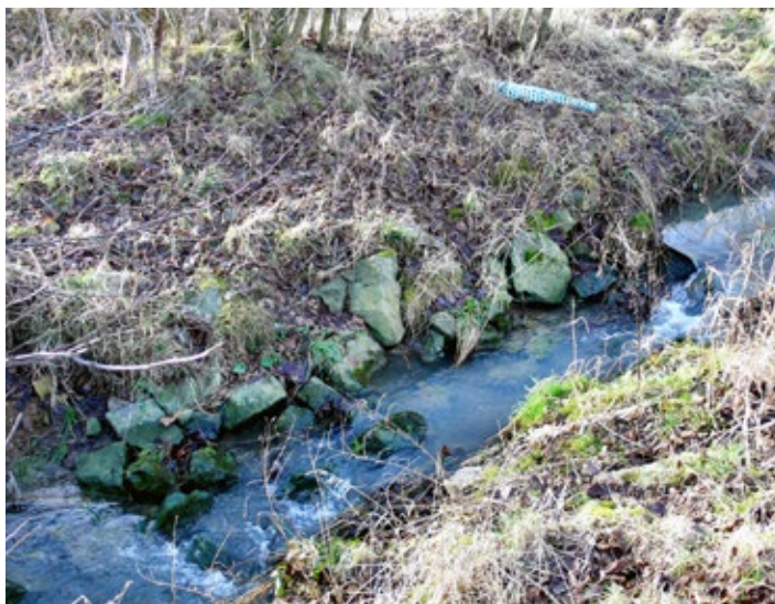
Obr. 4.53 Po zhruba 15 letech od pokusné revitalizace se tvary koryta Lhoteckého potoka výrazně nezměnily. Vložené pasy poněkud sesedly, ale jsou funkční. Šlo o částečnou revitalizaci bez nároků na cizí pozemky. Měla jenom dílčí efekty, z hlediska morfologického a ekologického stavu drobného vodního toku však byla určitým přínosem.
