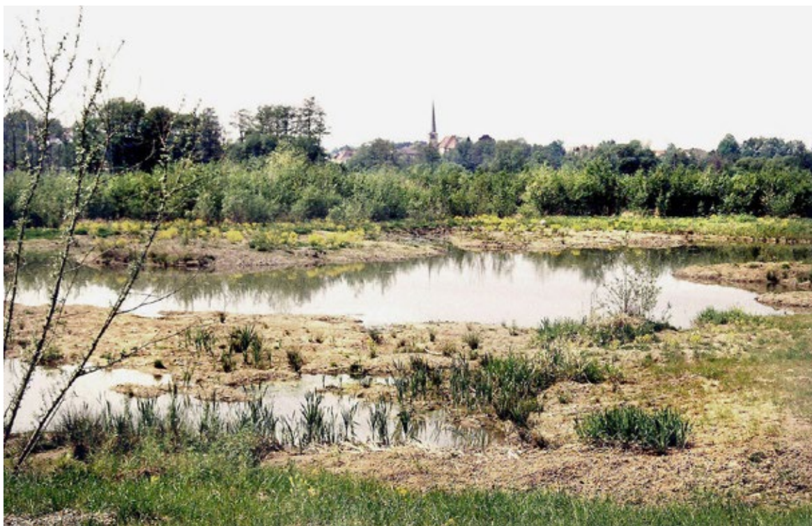
Obr. 7.11 Hloubená soustava tůní a mokřadů v nivě řeky Rodach u Redwitz, Bavorsko, 2003. Soustava je dotována z horní vody jezu na řece Rodach.
