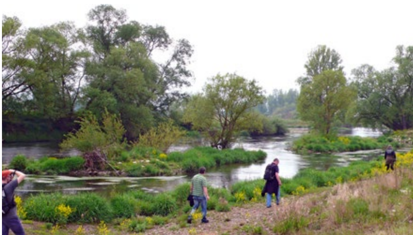
Obr. 4.33 Nesplavný Mohan ve středním Bavorsku byl již v 19. století kanalizován mimo jiné pro účely plavení dřeva, jeho koryto bylo částečně napřímáno a opevněno dlažbou. V naší době se Vodohospodářský úřad v Kronachu již několik desetiletí snaží využívat různých příležitostí k etapové revitalizaci řeky. Poblíž obce Wiesen tak bylo v roce 2012 provedeno přírodě blízké rozvolnění řečiště jako ekologická kompenzace za výstavbu nové železniční trati napříč údolím. V pohledu vlevo, rok po dokončení stavby, hlavní koryto Mohanu, uprostřed ostrůvky, ponechané v místě kvalitních břehových dřevin, vpravo rozvolnění do břehu. Podélné rozvolnění koryta není natolik hydraulicky znevýhodněno, aby se rychle zaneslo.
