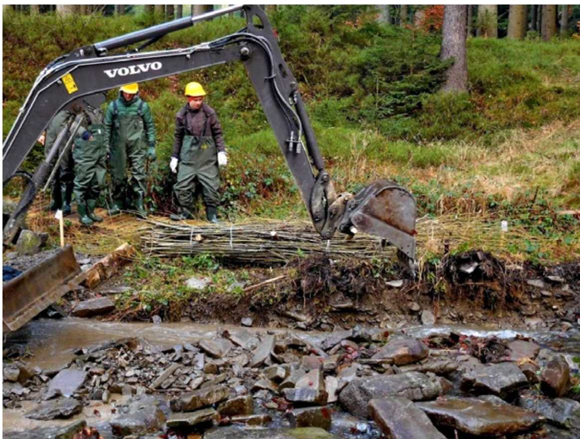
Obr. 6.49 Hloubení rýhy pro uložení haťového válce podél břehu koryta. Válec vytvoří přírodě blízkou stabilizaci břehu a zároveň stanoviště a úkryty pro vodní živěnu (foto M. Kubín).
