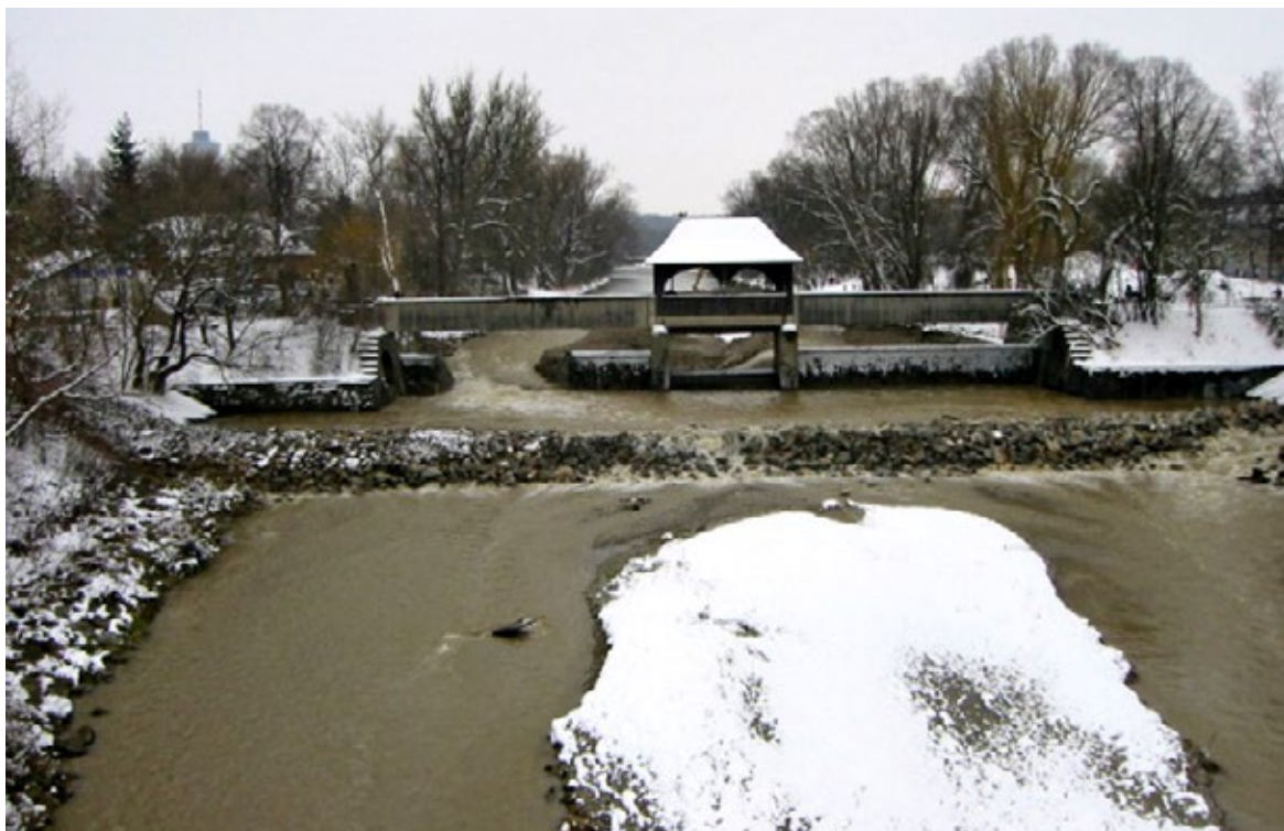
Obr. 5.37 Starý jez Goggeles na řece Wertach v Augsburgu byl v rámci široce pojaté revitalizace řeky odstraněn v roce 2006. Povodeň v roce předcházejícím potvrdila neúnosně špatný technický stav jezu, vysokého téměř 5 metrů. (Foto: Vodohospodářský úřad Donauwörth.)
