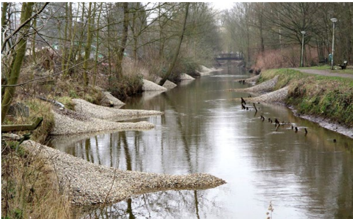
Obr. 6.19 Posilování členitosti a změlčování koryta druhdy technicky upraveného vodního toku střídavým vsypáváním hromad štěrku. Bude na vodním proudu, aby štěrkové kopce postupně rozvlekl po korytě. (Foto L. Tent, Wedel)
