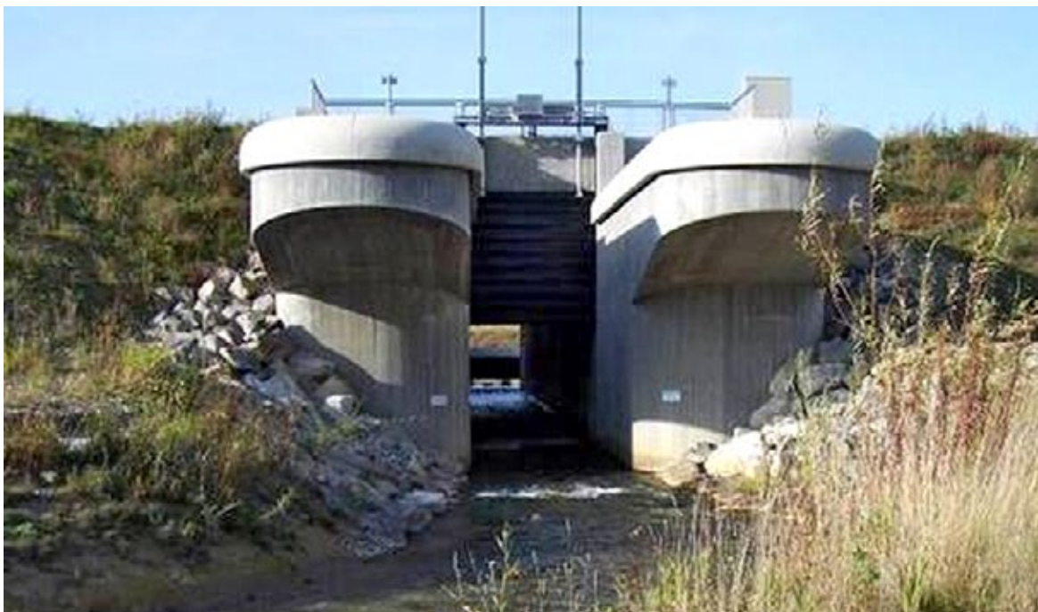
Obr. 5.27 Odtokový objekt poldru u Seifenu s regulovatelným výpustním otvorem a dvěma kašnovými bezpečnostními přelivy, s různými polohami přelivných hran. (Zdroj snímku: Vodohospodářský úřad Kempten)
