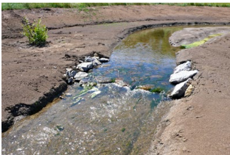
Obr. 4.14 Špatně provedený, ošizený dnový pas v revitalizačním korytě, který musel být následně předěláván. Pas je krátký, nedosahuje dolní uklidněné hladiny a přes jeho dolní okraj voda přepadá. Takový „stabilizační prvek“ by mohl v korytě paradoxně působit lokální hloubkovou destabilizaci. (Ostatně je vidět, že na i na korytu jako takovém se nevhodně šetřilo kamenivem. Bohatší nepravidelné pohozy dna hrubým štěrkem by nepochybně přispěly jak ke stabilitě, tak k ekologické hodnotě nového koryta. Ne všude je odolné jílové dno jako v tomto případě a šetření na kamenivu se může vymstít.)
