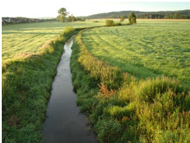
Obř. 1.28 Smyslem revitalizačních opatření není obnova nedotčených nebo historických podmínek, ale přiblížení se přirozenému říčnímu systému. Kanalizovaná Doubrava v široké zatravněné nivě u Žďírce nad Doubravou, silný adept revitalizace. (Foto K. Kujanová)
