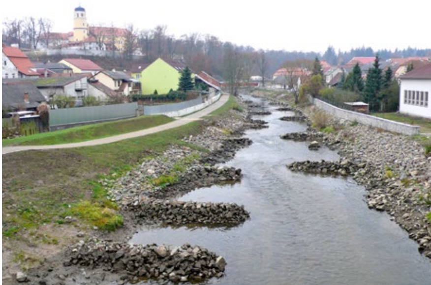
Obr. 6.35 Protipovodňová úprava Blanice ve Vlašimi, 2014: Posílení tvarové a hydraulické členitosti a stanovištní nabídky pro říční biotu přímého intravilánového úseku koryta, běžně zavzdučeného jezem, bylo dosaženo pragmatickou, ne právě přírodě blízkou sestavou střídavých výhonů. Zde neobvyklý pohled v době, kdy byla hladina vody snížena otevřením proplachovací propusti níže ležícího jezu – vypadá to nepřirozeně, ale po zaplavení vodou to funguje.
