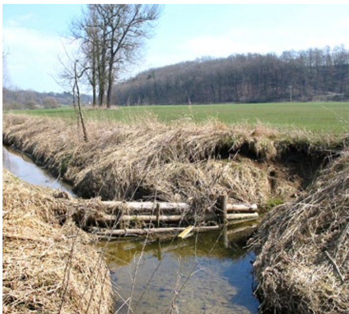
Obr. 4.47 Stupně, omezující přirozenou proudnost koryta a vytvářející migrační překážky, jsou ve vodních tocích obecně nežádoucí. Navíc postavit stupeň z technického hlediska kvalitní, který nedopadne jako tento na obrázku, je dost pracné a nákladné. Pro revitalizace a přírodě blízké vodní stavitelství - zákaz stupňů.
