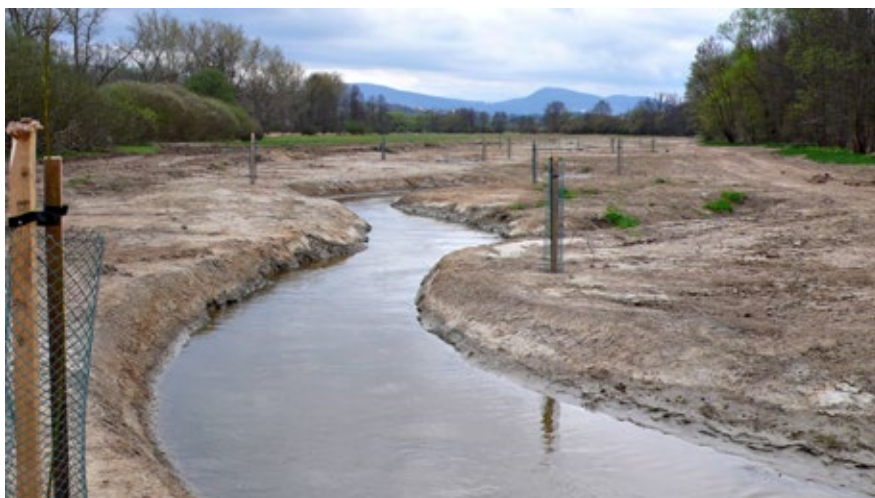
Obr. 3.19 První etapa revitalizace Stropnice u Nových Hradů, druhdy technicky upravené v rámci náhradních rekultivací za výstavbu JE Temelín. Revitalizaci provedlo Povodí Vltavy, s.p., dotováno v rámci OPŽP. Obnovení širokého říčního pásu umožnilo vhodné navázání akce na komplexní pozemkové úpravy. Na tomto snímku stav revitalizace v době dokončování výstavby v roce 2014. Nové koryto je zvlněné, ale postrádá podrobnou členitost.
