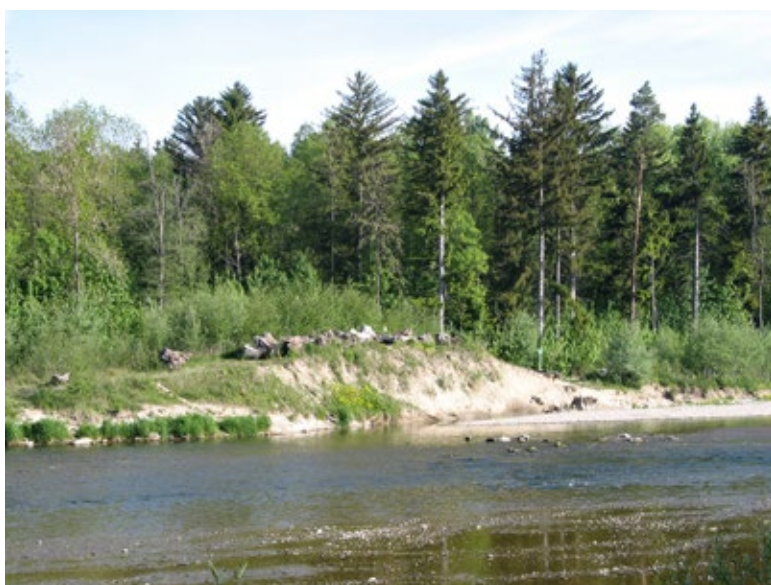
Obr. 6.30 Neplánovaný „dávkač pařezů“ na břehu revitalizované řeky Wertach na kraji bavorského Augsburgu, kolem roku 2008. Navážka pařezů měla původně bránit vstupu vřetečných lidí na nestabilní vyvýšený břeh, původně vymodelovaný jako hnízdní svah pro ledňáčky. Lidi tam stejně chodí, ale postupně „přikrmování“ řečiště pařezy, jak se svah vymílá, je přínosné.
