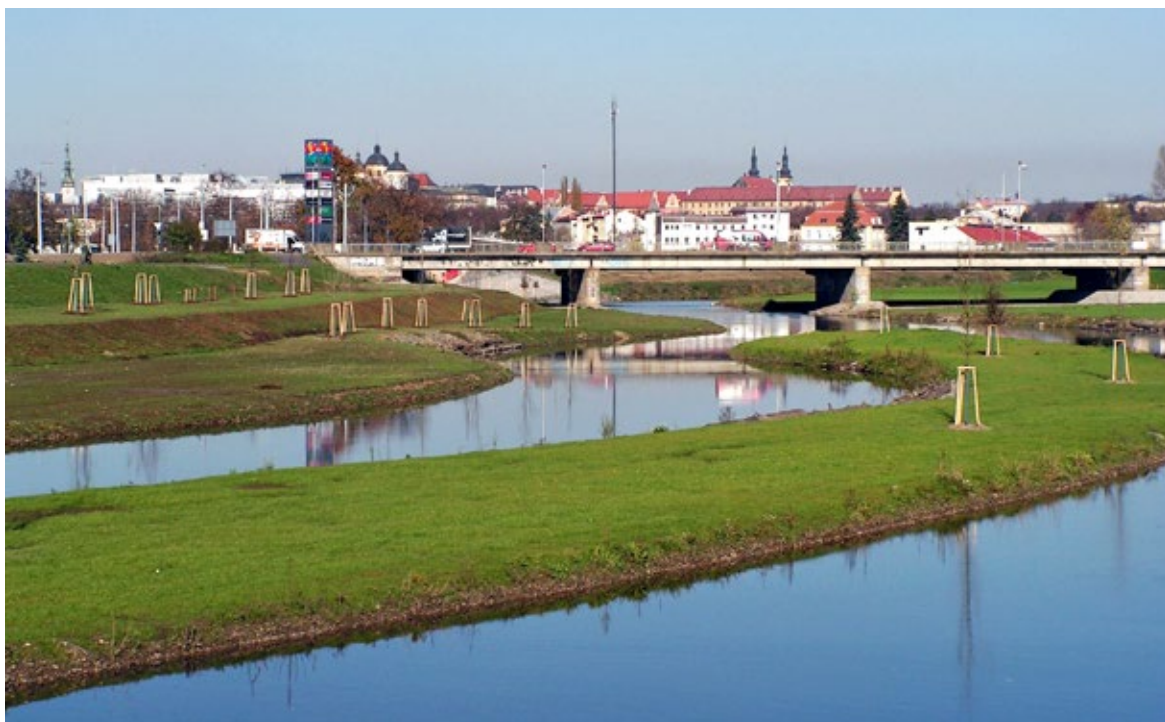
Obr. 2.11 Přírodě blízká protipovodňová úprava Moravy v Olomouci. Přírodě blízké rozvolnění řečiště v zájmu zvětšení povodňové průtočnosti a zmírnění zpětných povodňových vzduť. Akce Povodí Moravy, s.p., pohled v roce 2014. (Foto J.Koutný)
