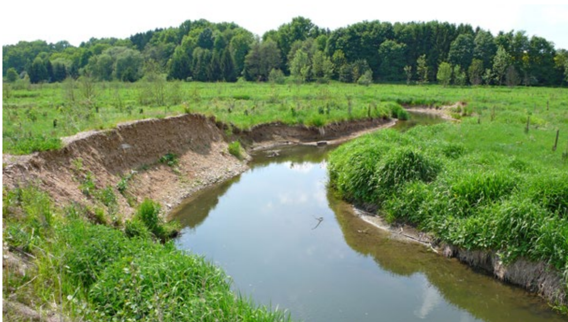
Obr. 6.1 „Přikrmování“ koryta vodního toku štěrkiem z odplavitelných hromad za účelem obohacení splaveninového režimu a podpory vzniku štěrkových pasáží dna. Revitalizace Moravské Sázavy v zátopové ploše suché povodňové nádrže Žichlínek; akce Povodí Moravy, s.p.; financováno z prostředků resortu zemědělství; pohled kolem roku 2010.
