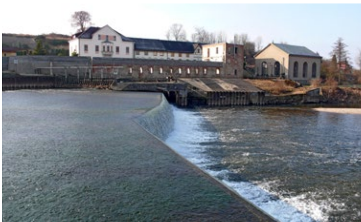
Obr. 3.33 Příčné stavby v korytech vodních toků vytvářejí překážky v migraci vodních živočichů a připravují vodní tok o přirozenou spádnost, proudnost, hydraulickou členitost a rozmanitost nabídky stanovišť pro vodní biotu. Energetické vytěžení vodního toku elektrárnou nutně znamená, že vodnímu toku je odebrána část energie, která je „pohonom“ dynamických aspektů hydraulické členitosti a přirozeného hydromorfologického vývoje. Některé problematicky umístěné jezy mohou působit vzhledem k zastavěným územím jako nevhodné překážky povodňové. (Ilustrační snímek: jez Kačov na dolní Jizeře.)
