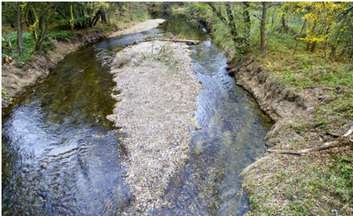
Obr. 2.8 Vodní tok, jehož renaturace byla iniciována dílčími vodohospodářskými opatřeními, zde částečným odstraněním opevnění břehů technicky pojednanými záhozy. Morava u Štěpánova, renaturační projekt podpořený v rámci operačního programu Životní prostředí. (Foto P. Zifčák)
