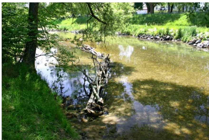
Obr. 6.39 Intravilánová revitalizace řeky Vöckla ve Vöcklabrucku, Rakousko, 2007: Ke břehu ocelovým lanem kotvený „ohon“ ze svázané tyčoviny a větví. Vytváří úkryty pro ryby, podporuje vznik úplavových tůní, rozčleňuje proud (aspoň když řekou něco teče). Trvanlivost nejspíš do první větší vody.
