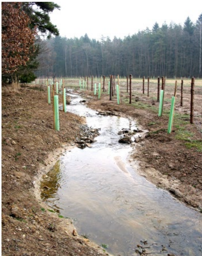
Obr. 3.23 Revitalizaci Pekelského potoka u Zdislavic na Vlašimsku provedl k roku 2006 městyš Zdislavice s podporou tehdejšího Programu revitalizace říčních systémů resortu životního prostředí (PRŘS). Zvlněné koryto, vyhloubené zcela mimo koryto dřívější, následně zasypané, je mělké a málo kapacitní. Stabilizováno a členěno je sledem pasů z kameniva, ukládaných do dna obvykle v přechodech mezi oblouky trasy.
