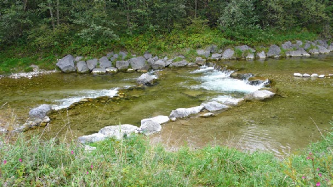
Obr. 6.21 Řeka Mangfall v Bavorsku – balvanový pas lomený proti proudu („spojka“ – soustřeďuje proudění do středu koryta a tam podporuje vznik tůně), doplněný podélnou stabilizací břehu.
