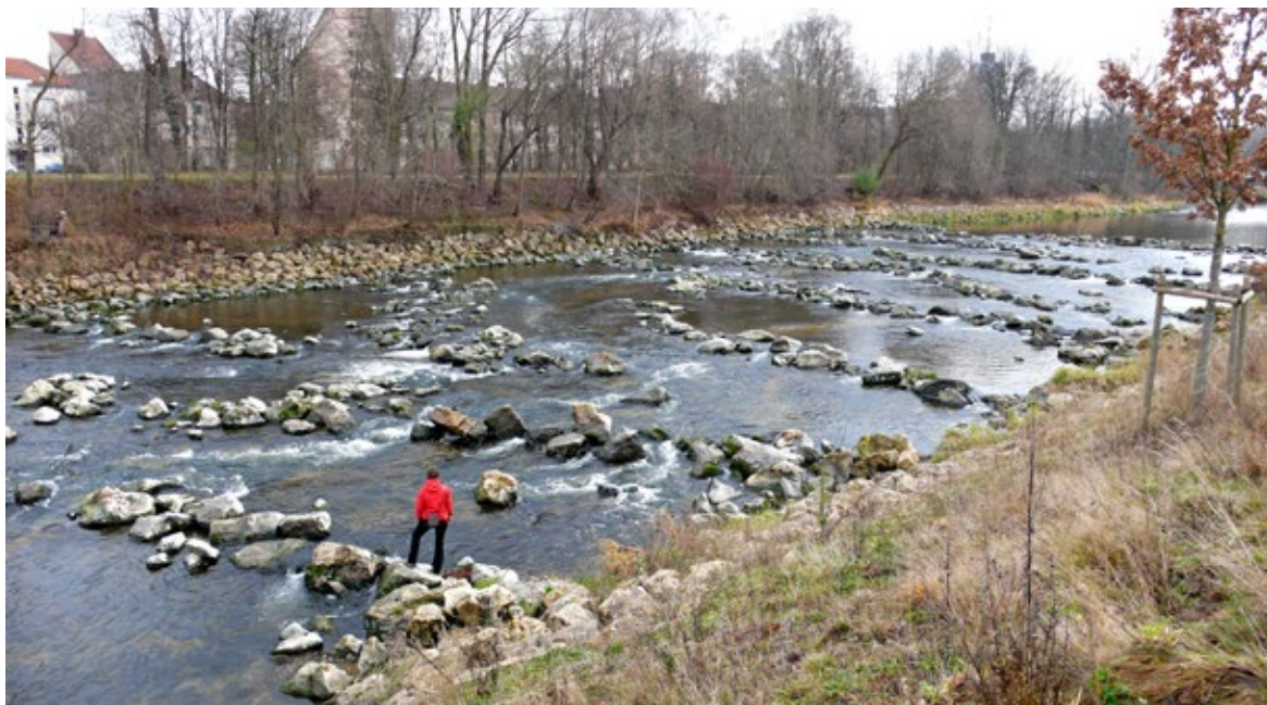
Obr. 5.38 Jez Goggeles v Augsburgu byl nahrazen několik set metrů dlouhou balvanitou rampou. Je provedena v mírném sklonu, neomezujícím migrace vodních živočichů. Pohled v roce 2009.
