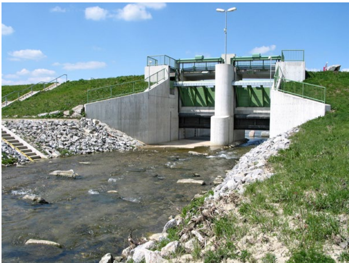
Obr. 5.25 Regulační a vypouštěcí objekt hráze suché nádrže Dirlwang. Pohyblivé uzávěry jsou dálkově ovládané. Pravým polem objektu prochází kyneta pro běžné průtoky, prostupná pro migrace vodních živočichů.
