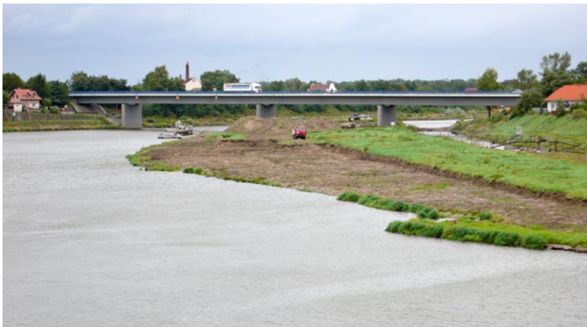
Obr. 10.47 Odtěžování jalové bermy na Vltavě pod jezem v Miřejovicích provádělo Povodí Vltavy v roce 2011, financováno z prostředků Povodí. Cílem bylo zvětšení povodňové průtočnosti řeky pod zdymadlem a vytvoření ekologicky cenných mělkovodních partií.
