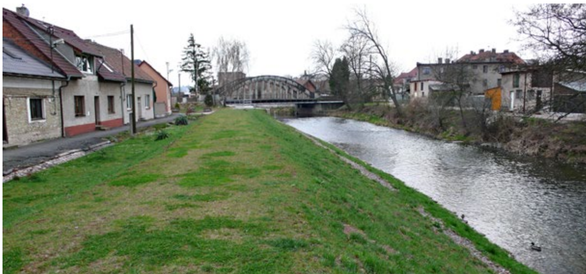
Obr. 10.50 Vrdy na Doubravě, stavba protipovodňové prevence, realizovaná kolem roku 2011. Snad projektant prověřil i jiné varianty řešení, než zasypání prostoru mezi cestou podél linie domků a řekou masivním zemním valem (všechno to zelené), který vedle protipovodňové funkce sídelní území příliš neobohacuje. Lidé, pokud se tam rovnou neskutálí, mohou po valu sejít k technicky upravenému korytu řeky – ale mnoho tam nenajdou. Pokud by podél ulice před domky byla vedena i stejně vysoká zeď, koryto řeky mohlo mít, byť možná s poněkud většími náklady, dvojnásobnou šířku, tomu odpovídající větší povodňovou průtočnou kapacitu a prostor pro celkově přírodě bližší pojetí.
