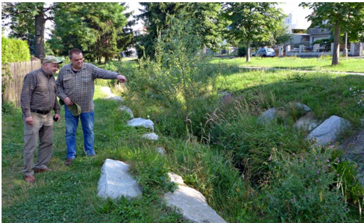
Obr. 10.20 Částečná revitalizace Rakovského potoka vznikla jako součást povodňového parku v Rokycanech, 2019. Opevnění betonovými deskami nahradily rované balvany. Akce města Rokycan, dotováno v rámci OPŽP.
