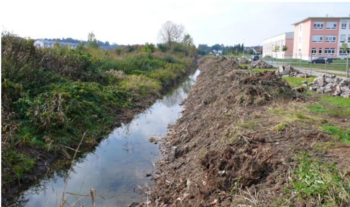
Obr. 10.42 Podzim 2014: Začínají práce na revitalizaci Litovického potoka v Hostivicích, akce města Hostovic, dotovaná v rámci OPŽP. Úsek upraveného potoka u školy byl zatím očištěn od vegetace a zbaven kamenné dlažby. Dosavadní koryto charakterizovala mimo jiné malá běžně zadržovaná množství vody a malé hladinové plochy na jednotku délky.
