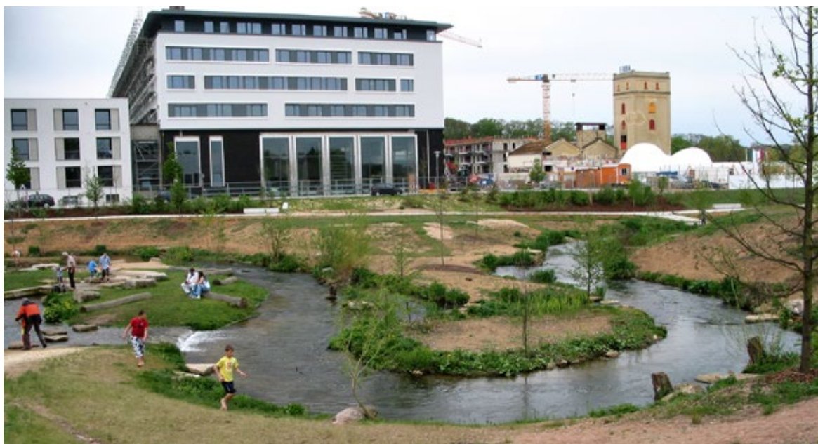
Obr. 10.57 Bavorsko, Bamberg, 2012: Pro konání zemské zahradní výstavy bylo krajinářsky rehabilitováno území někdejší textilní továrny na kraji města. Po skončení výstavy toto území funguje jako park. Jako vodní osa výstavního areálu byla postavena přes 1200 metrů dlouhá rybí cesta, obcházející zachovávaný starý tovární jez na řece Regnitz. Vzhledem k velké délce a mírnému podélnému sklonu je objekt řešen jako přírodě blízké koryto.
