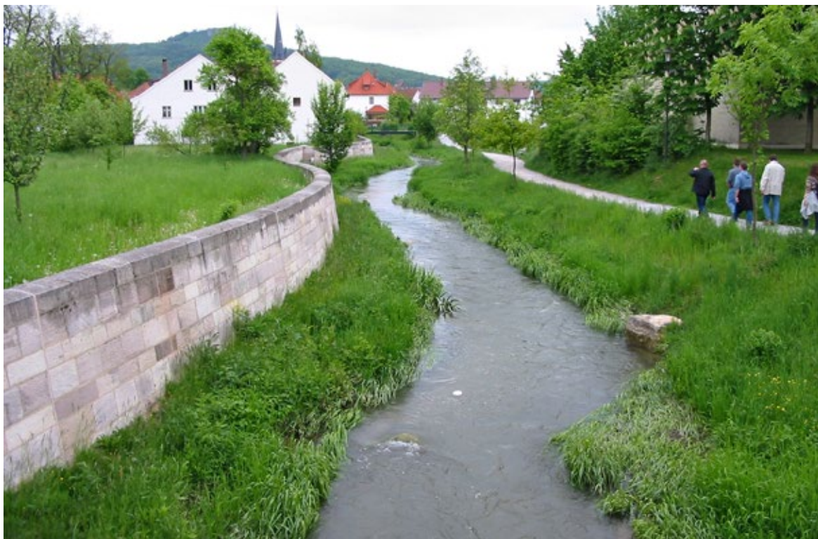
Obr. 10.3 Bad Staffelstein v Bavorsku - klasická lokalita intravilánových revitalizací. První etapa protipovodňové a revitalizační úpravy potoka Lauterbach proběhla v roce 1998 v dolní části městečka. Byl vytvořen povodňový koridor o kapacitě na úrovni Q_{20} , který proti okolní zástavbě vymezují architektonicky řešené zdi, místy zemní valy. Vjeďte se do něj přírodě blízká kyneta potoka, parková úprava se stromy a vycházková cesta.
