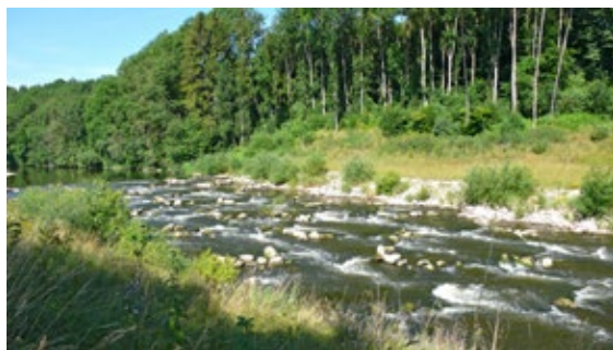
Obr. 58 Migračně prostupná stabilizační dnová rampa v dolním okraji revitalizace, nad obcí Binzwangen.
