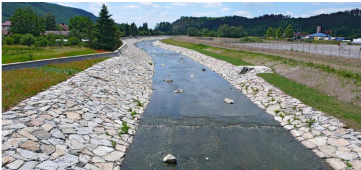
Obr. 10.11 První etapa protipovodňové úpravy Litavky v Popovicích u Králova Dvora, provedená v roce 2009 (akce v působnosti resortu zemědělství). Technicky pojatá, přírodě vzdálená úprava zastaralé koncepce ignorovala zvláštnosti dílčích úseků vodního toku v okrajové části intravilánu a celé území „propálila“ korytem velmi málo proměnlivých tvarů. Mnoho místa v korytě zabírají mohutně technicky stabilizované břehy a suchá berma, které mají jenom stabilizační a výplňové funkce, zatímco jejich ekologická hodnota je skromná. Málo prostoru zbývá na kynetu pro běžné průtoky, která má sice přírodě blízké dno, ale celkově je nedostatečně členitá.
