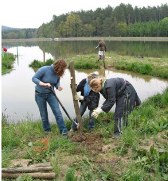
Obr. 9.27 Zjara se živé, čistě seříznuté vrbové kůly s nepoškozenou kůrou zapouštějí do země na slunných březích. Záměrně uvádíme zapouštění, a ne zatloukání, protože tím se kůly obvykle silně poškodí.
