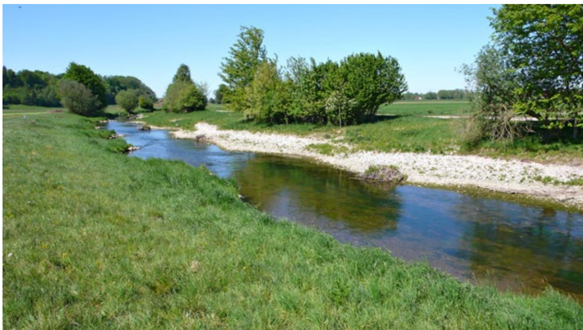
Obr. 38 Koryto Mindel po revitalizaci přírodě blízkým rozvolněním ve stávající trase. Stav v roce 2011, rok po provedení stavby.
