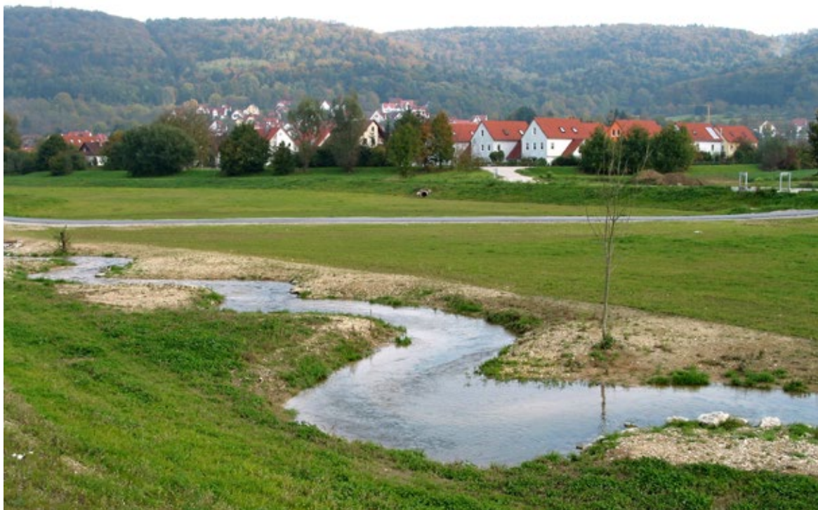
Obr. 74 Ochranný průleh v Ebermannstadtu v roce 2008.
