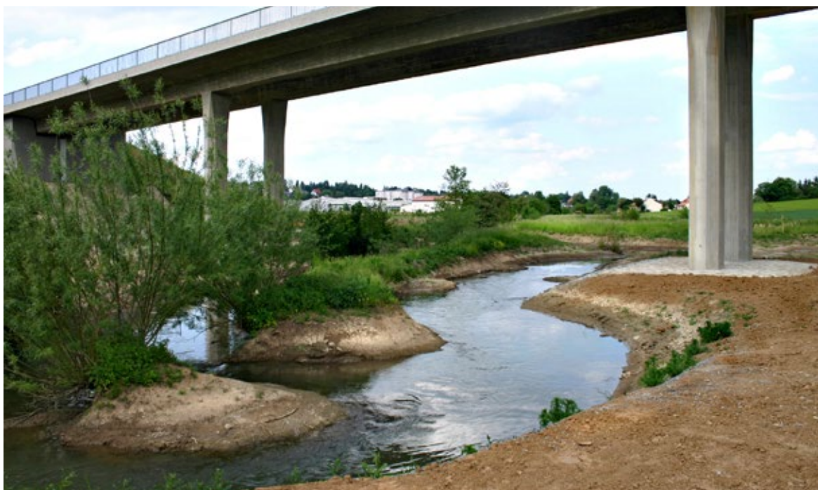
Obr. 10.52 Setkání vodního toku s komunikací nemusí znamenat tvrdou technickou úpravu koryta: Revitalizace říčky Wern pod Werneckem, Bavorsko, 2008. Koryto potoka je přírodě blízké. Pokud je v místě křížení zvlášť stabilizováno, tak skrytě, nejspíš hlouběji uloženým záhozem. Pilíře mostu jsou založeny tak, že případný vývoj koryta by na ně neměl mít vliv.
