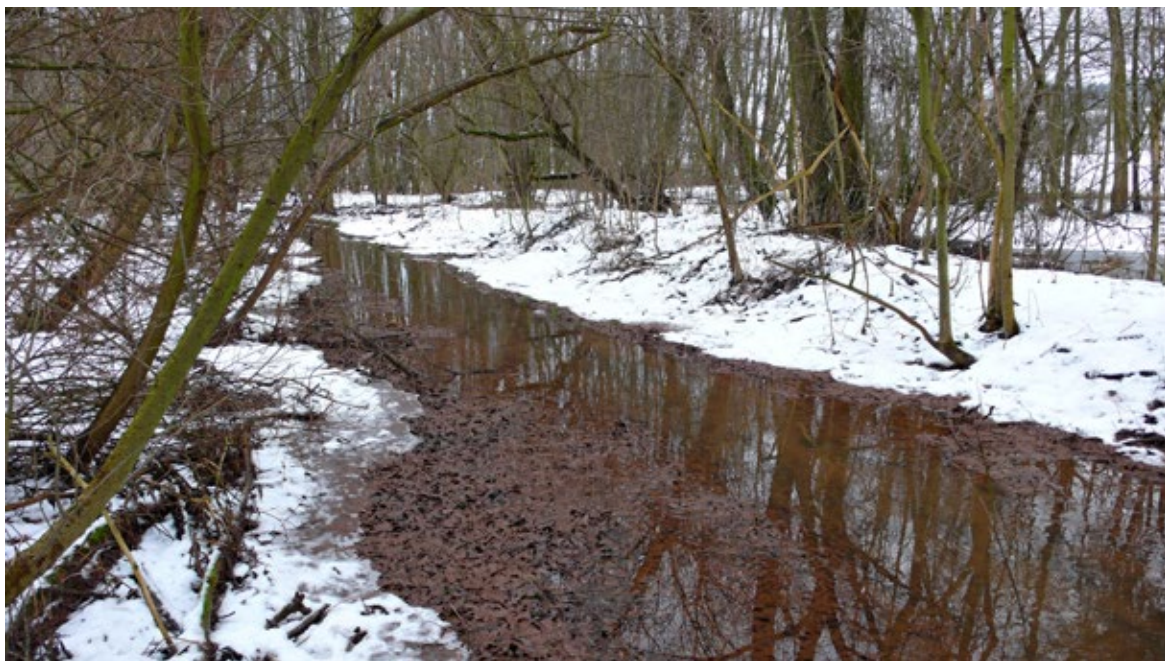
Obr. 8.7 Renaturace mírně sklonitého upraveného koryta zanášením jemnými splaveninami, které překryly opevnění betonovými deskami. Proces pokračuje, k dosažení uspokojivého přírodě blízkého stavu ještě dost zbývá.
