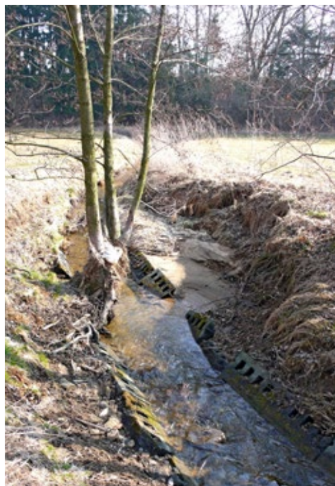
Obr. 8.11 Skromný olšový polykormon (soukmení) versus opevnění koryta potoka polovegetačními tvárniciemi. Proč „meliorátoři“ neměli rádi stromy v korytech.
