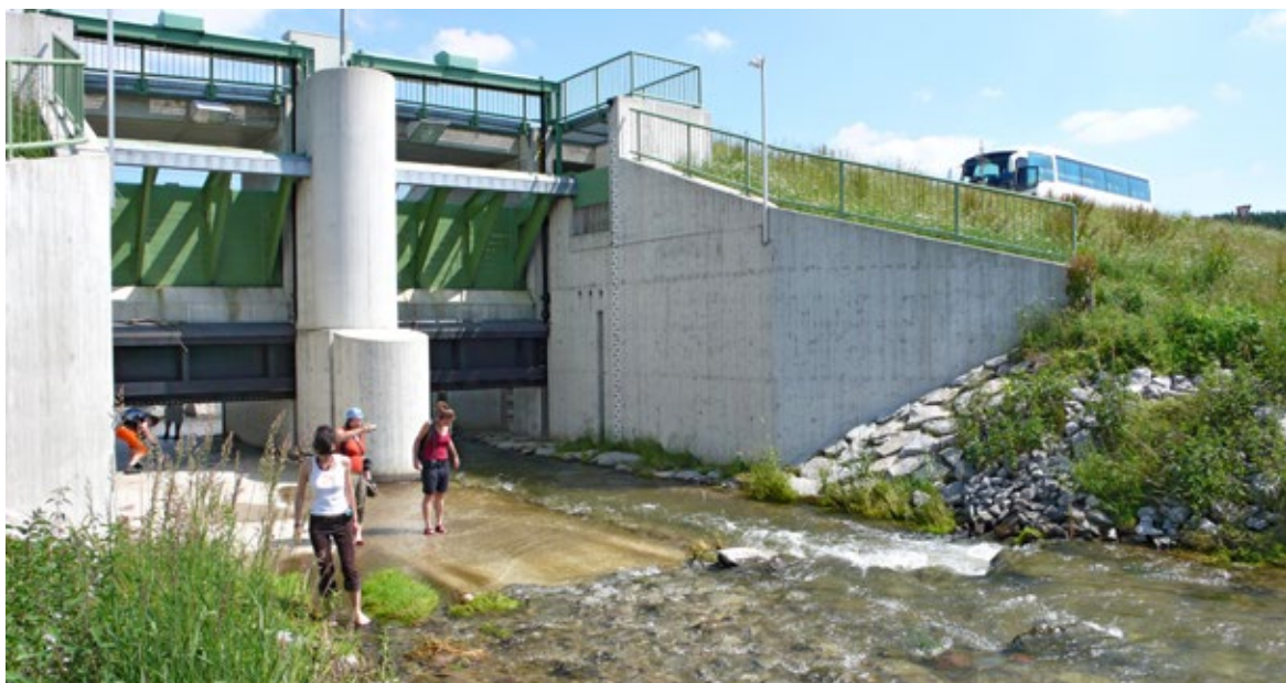
Obr. 72 Bezpečnostní, regulační a výpustní objekt suché povodňové nádrže Dirlewang s migračně prostupnou kynetou pro běžné průtoky.
