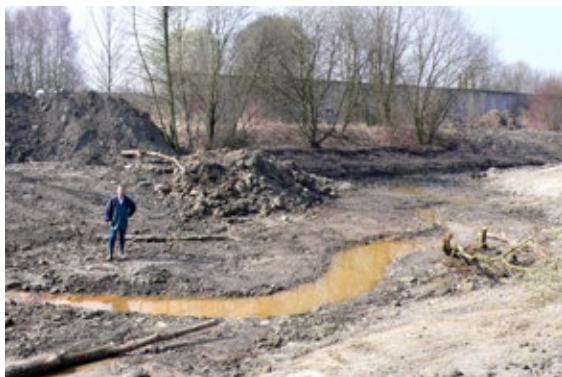
Obr. 2 Vytváření rozvolněného koryta s přírodě blízkou kynetou v dílčím úseku, kde bylo možné opustit půdorys starého, technicky upraveného koryta.
