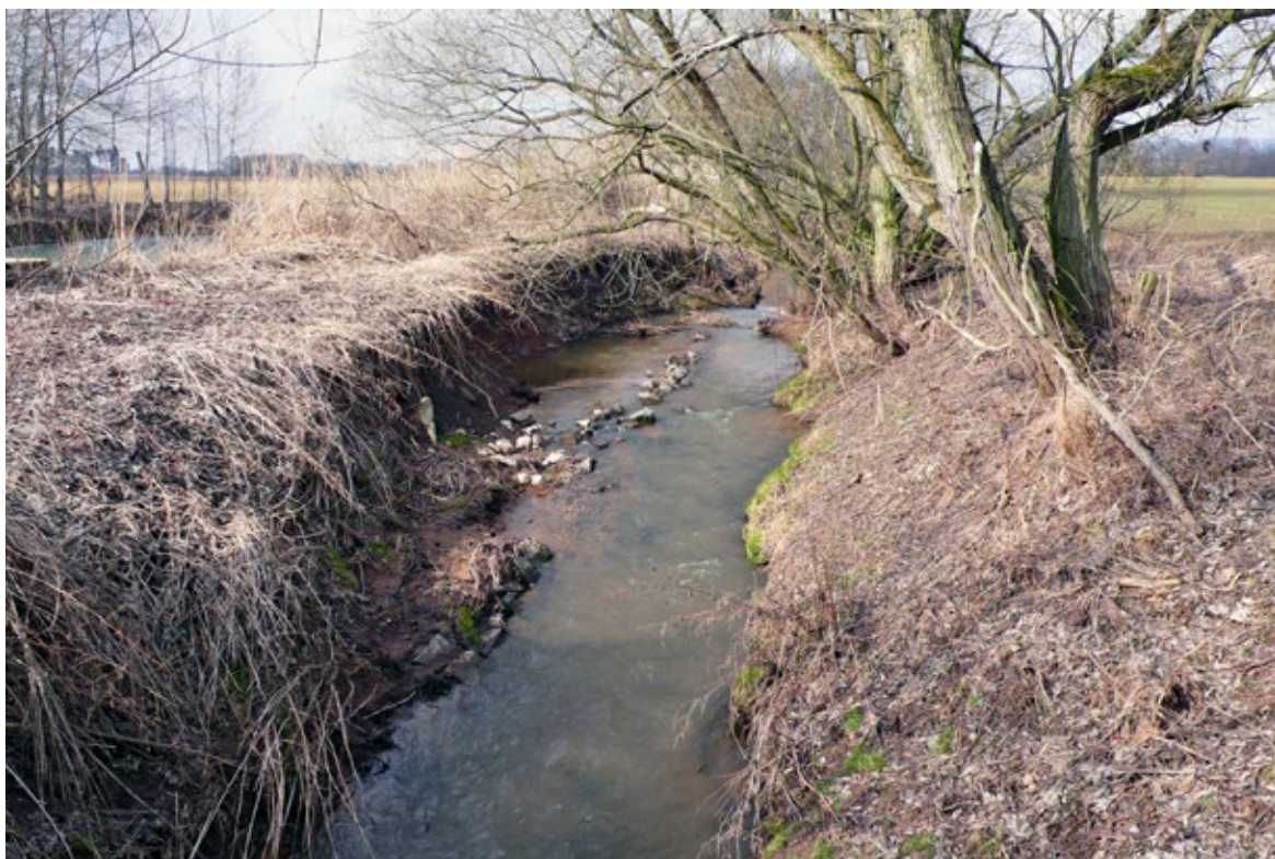
Obr. 8.6 Renaturace upraveného koryta vymíláním do stran. Koryto je hluboké, bude vhodná korekce renaturačních procesů v podobě přírodě blízkého změlčení, nejspíše sledem dnových pasů z kameniva.
