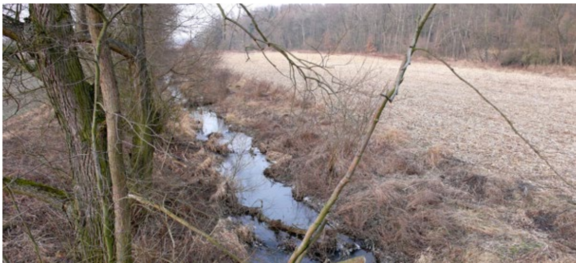
Obr. 8.24 Starší technická úprava potoka o mírném podélném sklonu se již léta zanáší a zarůstá. Koryto není výrazně zahloubené, opevnění není patrné. Další renaturaci by bylo vhodné napomoci dílčími opatřeními na podporu členitosti. Úsek je vhodný pro výraznější aplikaci struktur říčního dřeva – zdrojem může být i dožívající výsadba kultivárních topolů na břehu potoka.
