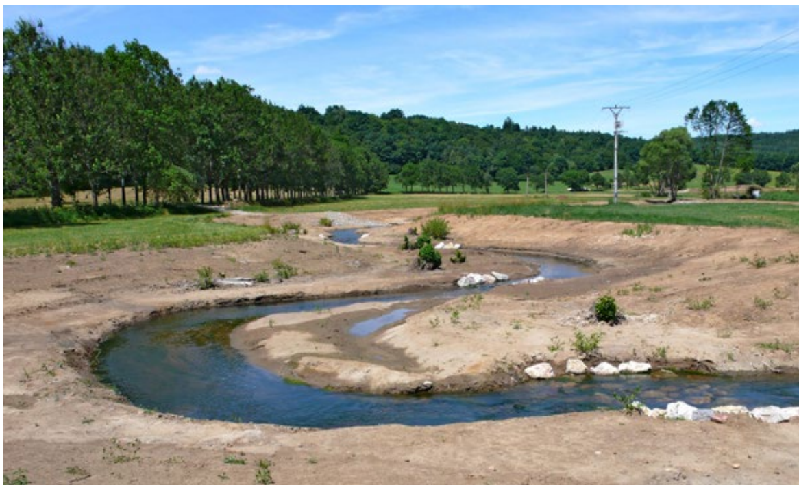
Obr. 41 Jeden z nových úseků revitalizačního koryta v suchém létě roku 2015. Přechody mezi oblouky kynety stabilizují dnové pasy z kamenů (před dokončením výstavby bylo do většiny z těchto pasů ještě kamenivo doplněno), po stranách kynety začínají obrůstat pařezové implantáty.
