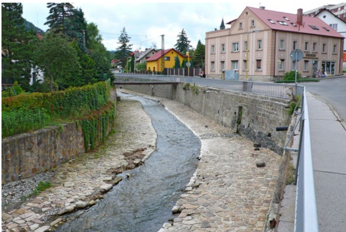
Obr. 10.1 Kanalizované intravilánové koryto: Ekologické funkce vodního toku jsou zásadním způsobem potlačeny. Vzhledem k hydraulickým poměrům v dlážděné kynetě je tento úsek sám o sobě překážkou v protiproudé migraci vodních živočichů. Dlážděné bermy představují v korytě jalové plochy, plnící pouze výplňové funkce. Na tom, že je zde koryto lemováno postranními zdmi, se vzhledem k prostorovým podmínkám nejspíš nic nezmění, nicméně počínající rozpad dlažby by mohl být námětem k úvahám o možnostech zpřírodnit alespoň dno koryta včetně postranních berem.
