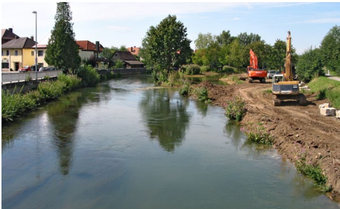
Obr. 10.22 Rozvolňování povodňového koridoru řeky Wiesent v Ebermannstadtu v roce 2008. Rozšiřování kynety, snižování úrovně terénu pravostranné bermy.
