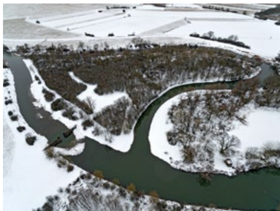
Obr. 104 Zimní pohled na napojené rameno D18, 9.1.2019. V hlavním řečišti (vlevo) je patrn regulační objekt, kombinující štětovnicovou clonu a balvanitý skluz. (Foto Povodí Moravy, s.p.)
