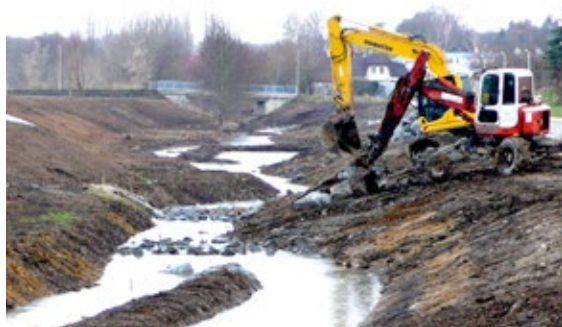
Obr. 81 Tvarování přírodě blízké kynety v rozšířeném potočním pásu. Tvarová členitost kynety pak pragmaticky využívá místních podmínek, pro morfologicky autentičtější řešení nebyl v zastavěném území prostor.
