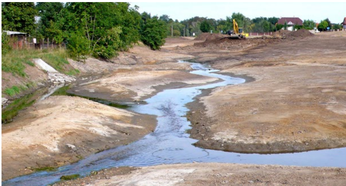
Obr. 82 Výrazné rozšíření potočního perimetru ve středním úseku revitalizace umožnilo vytvořit nečekaně členitou kynetu s postranními tůňovými klky. Pohled v rozpracovanosti.
