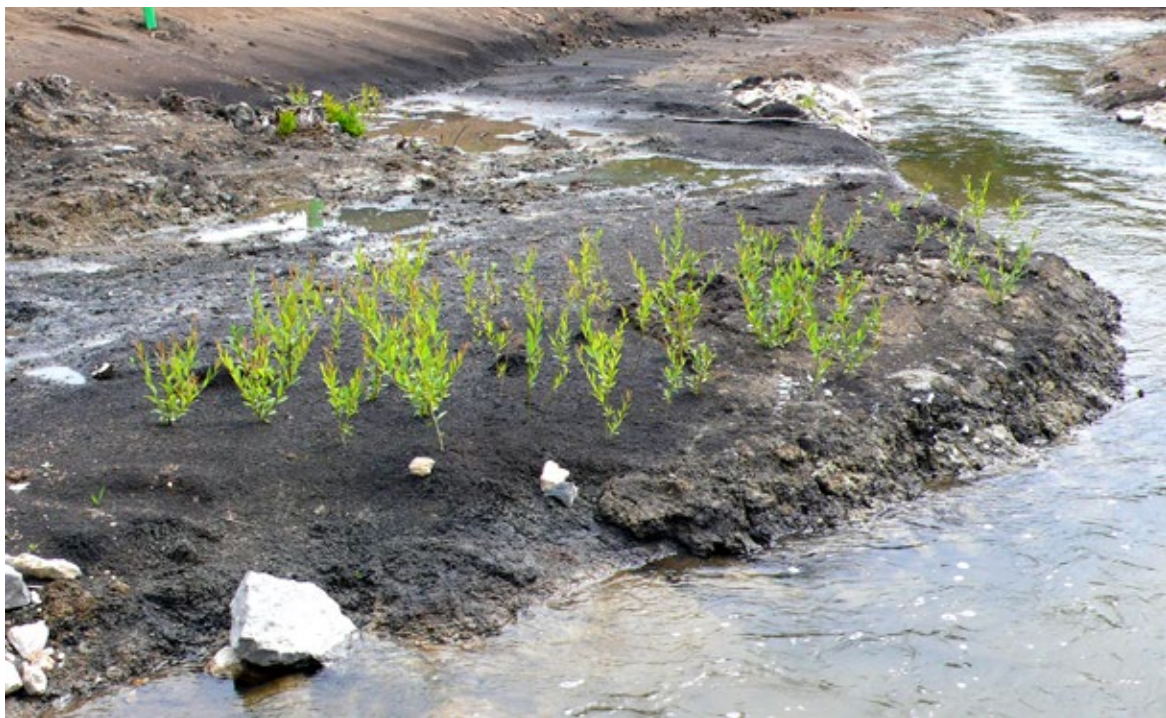
Obr. 9.24 Účinný způsob zakládání porostů na vlhkých osluněných místech - jarní husté zapichování vrbových řízků. Řízky i větve zapíchané jednotlivě mohou být snadno zničeny zvěří.
