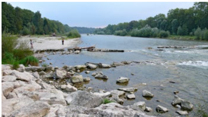
Obr. 85 Rozvolněná kyneta řeky Isar v nejstarší etapě revitalizace, budované po roce 2000; pohled v roce 2004. V popředí je patrna jedna ze stabilizačních dnových ramp z velkých balvanů. Stromoví po stranách skrývá hráze, vymezující povodňový perimetr řeky, za hrázemi leží městská zástavba.
