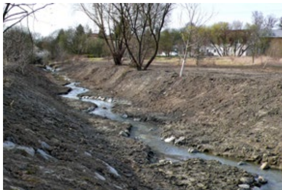
Obr. 3 Modelace přírodě blízké kynety, základní formát technicky upraveného koryta musel být v tomto dílčím úseku z prostorových důvodů zachován.
