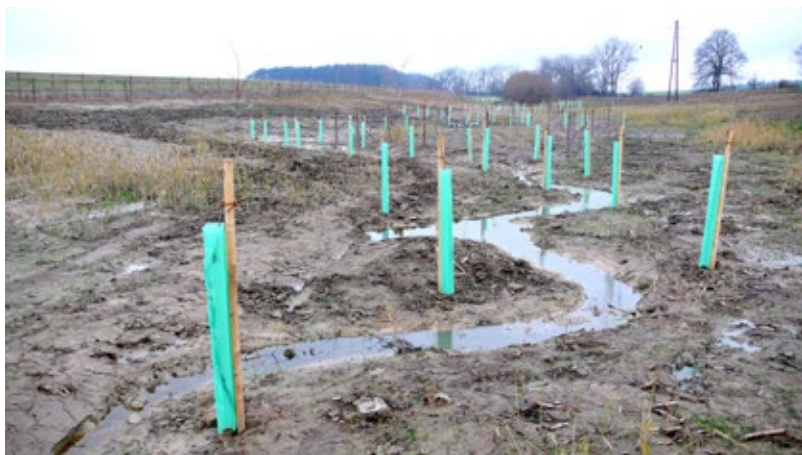
Obr. 9.14 Revitalizace odvodňovacího hlavníku u Domašína, akce města Vlašimi, 2010. Pás údolí podél nově vytvořeného korytka osvobozeného potoka byl ozeleněn kombinovanými výsadbami. Hlavně podél koryta byly vysazeny před zvěří individuálně chráněné odrostkové sazenice zejména olše lepkavé. V ochranných oplocenkách, vykrývajících zejména obvod revitalizovaného území, byla provedena lesnický pojatá výsadba stromů a keřů - malé prostokorné sazenice na husto.
