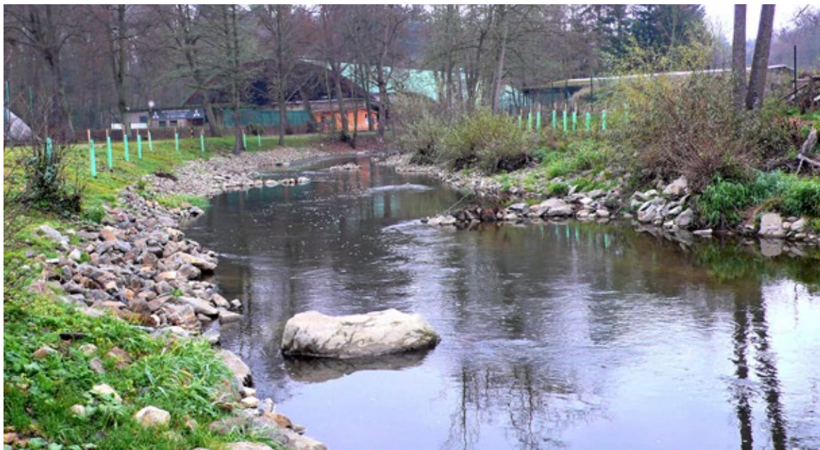
Obr. 83 Úsek Blanice mezi zámeckým parkem a historickým středem města, rozvolněný do přírodě blízkého stavu, s kamennými pohozy břehů a nepravidelnými výhony z balvanů. Pohled po dokončení výstavby, 2015.
