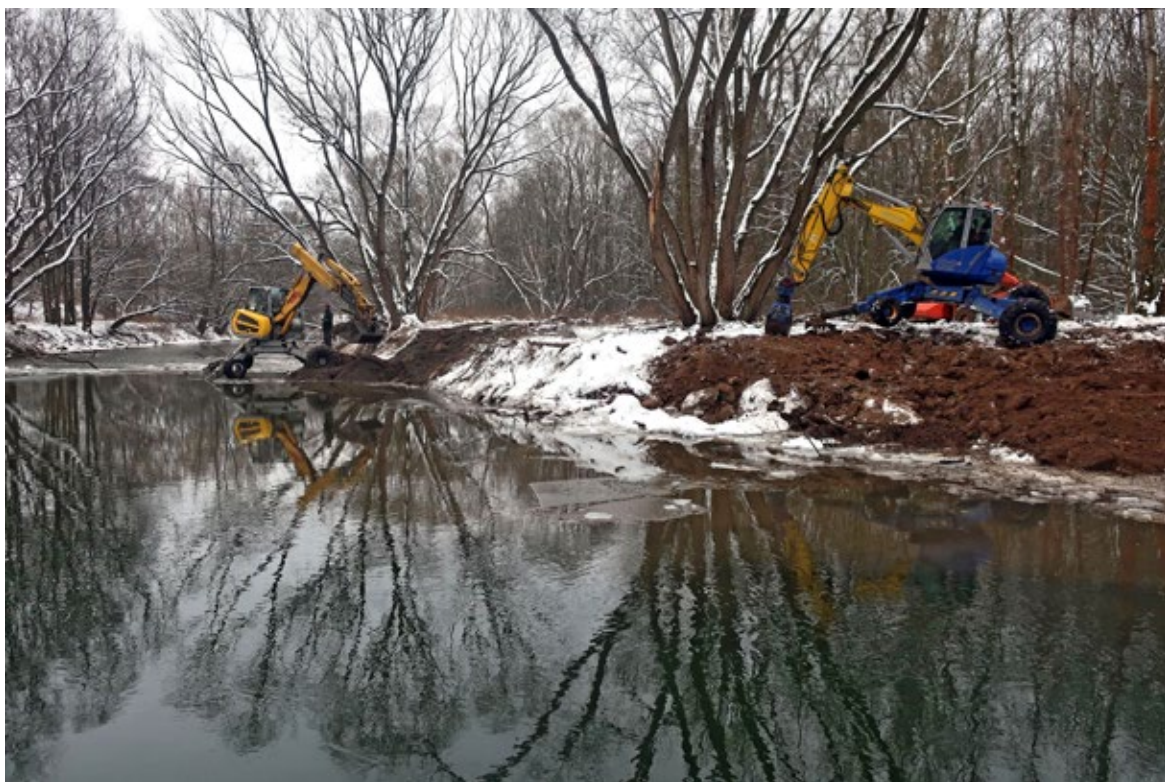
Obr. 8.28 Inicie renaturace a redynamizace vodního toku částečným narušením opevnění koryta dlažbou. Morava u Štěpánova, akce Povodí Moravy, s.p., realizace 2018 – 2019; dotováno v rámci OPŽP. (Foto J.Koutný)
