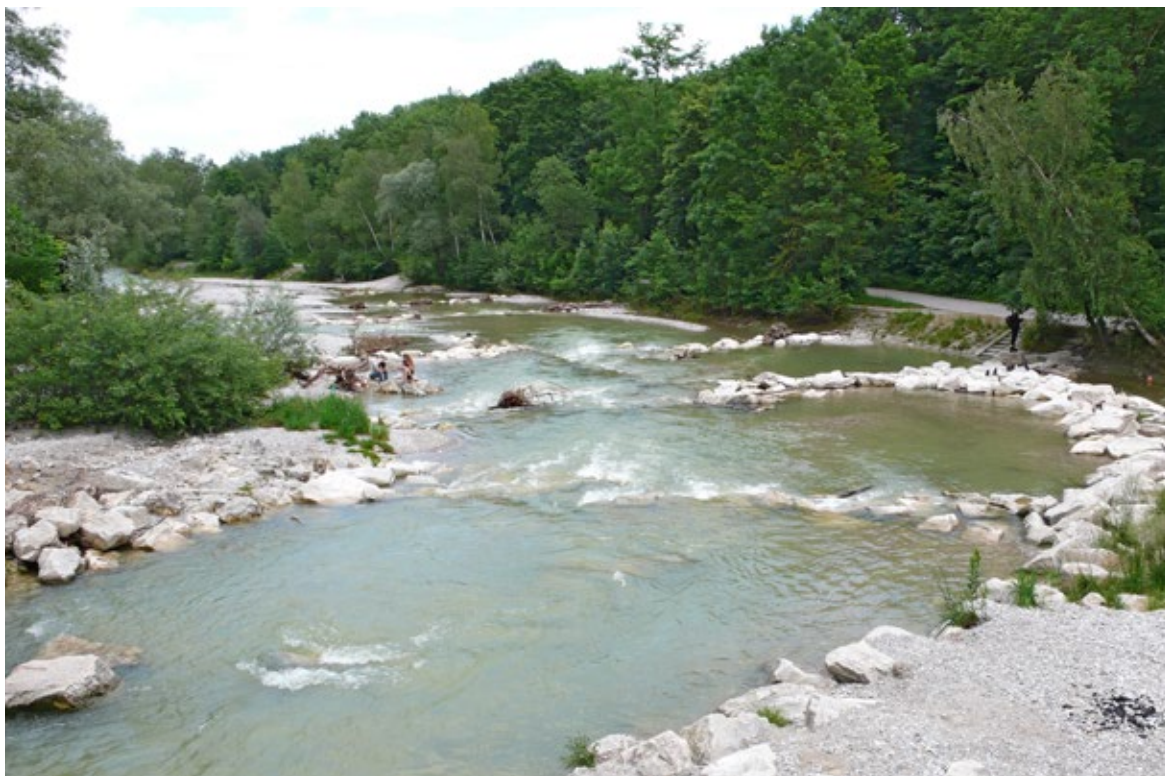
Obr. 87 Rybí přechod u jezu Flaucher představuje velkoryse pojaté přírodě blízké obtokové koryto, stabilizované a členěné příčnými pasy, rovnanými z balvanů; pohled v roce 2010 za poněkud zvětšeného průtoku. (Předcházející tuhou konstrukci s balvany loženými do betonu rozebrala povodeň v roce 2005.)
