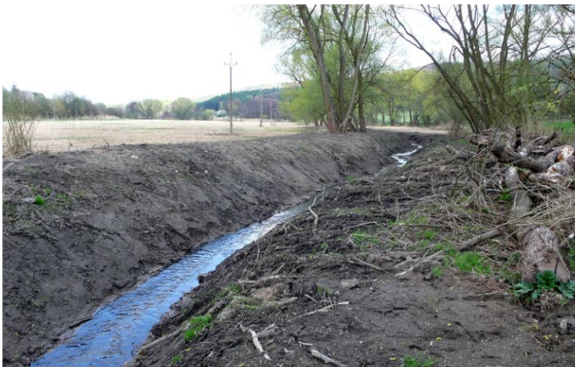
Obr. 11.3 Takzvaná „údržba drobných vodních toků“, spočívající v prohrabování již částečně zanesených a zarostlých technicky upravených koryt, představuje často, hlavně v nezastavěné krajině, samoúčelné ničení samovolné renaturace a další poškození jak ekologického, tak vodohospodářského stavu vodních toků. Konkrétně v tomto případě byla obnovena geometrizace a nepřírozeně velká hloubka koryta a zničena část břehových porostů. Levý břeh byl degradován valem z vytěženého materiálu. Bezprostředně po zásahu započala eroze narušeného koryta, do pohybu se dostávají jemné úživné splaveniny. Ani uživatelé okolních pozemků nemají v suchých obdobích důvody pokládat zesílený odvodňovací účinek hlubokého koryta za přínos.
