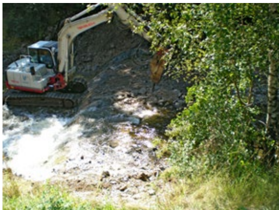
Obr. 92 Postupné odbourávání železobetonového jezového tělesa. (Foto M. Holub)
