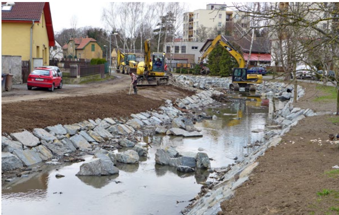
Obr. 10.40 Říčanka v Dubči prodělává v roce 2018 přírodě blízkou protipovodňovou úpravu. Akce Magistrátu a Lesů hl. města Prahy, financováno z prostředků města. Betonové panely ze břehů byly odstraněny, kyneta o něco rozšířena. Opevnění břehů kamennou rovnatinou je přiměřené poloze v zastavěném území, dno bude přírodě blízké, členěné skupinami kamenů a několika do břehu kotvenými kmeny stromů.
