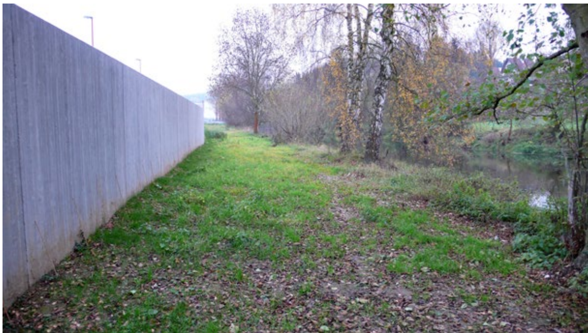
Obr. 10.27 Výrazně jednostranné technické pojetí stavby protipovodňové prevence; Zruč nad Sázavou, 2013. Sídlo se vůči vodnímu toku vymezilo stěnou, pro morfologicko-ekologický stav částečně technicky upraveného koryta řeky se neudělalo nic. Průběh povodňové vlny dál po toku se může podél tohoto opevnění jen zrychlovat.
