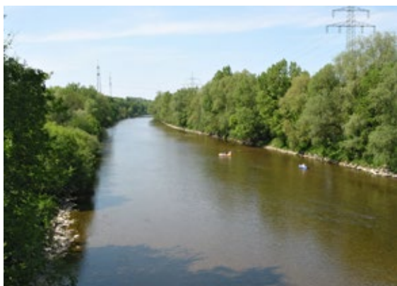
Obr. 50 Dosud nerozvolněný úsek Iller u Vöhringen. Koryto je v důsledku starších technických úprav napřímé, poměrně úzké, hluboké a místy má nežádoucí tendenci dále se zahlubovat.
