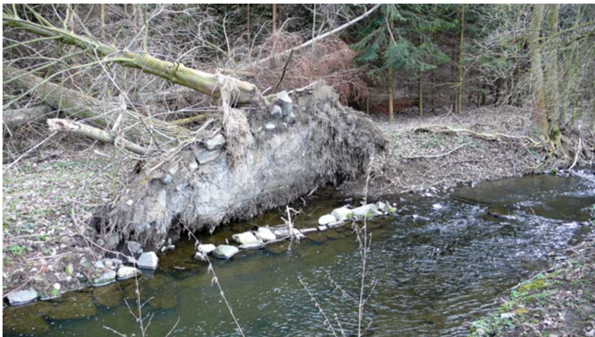
Obr. 8.23 Stará technická úprava potoka v lesním úseku již je dost zpřírodněná. Opevnění dlažbou obnažil stromový vývrát. Koryto není příliš hluboké a má přírodě blízké dno. Tento úsek může být ponechán další samovolné renaturaci.
