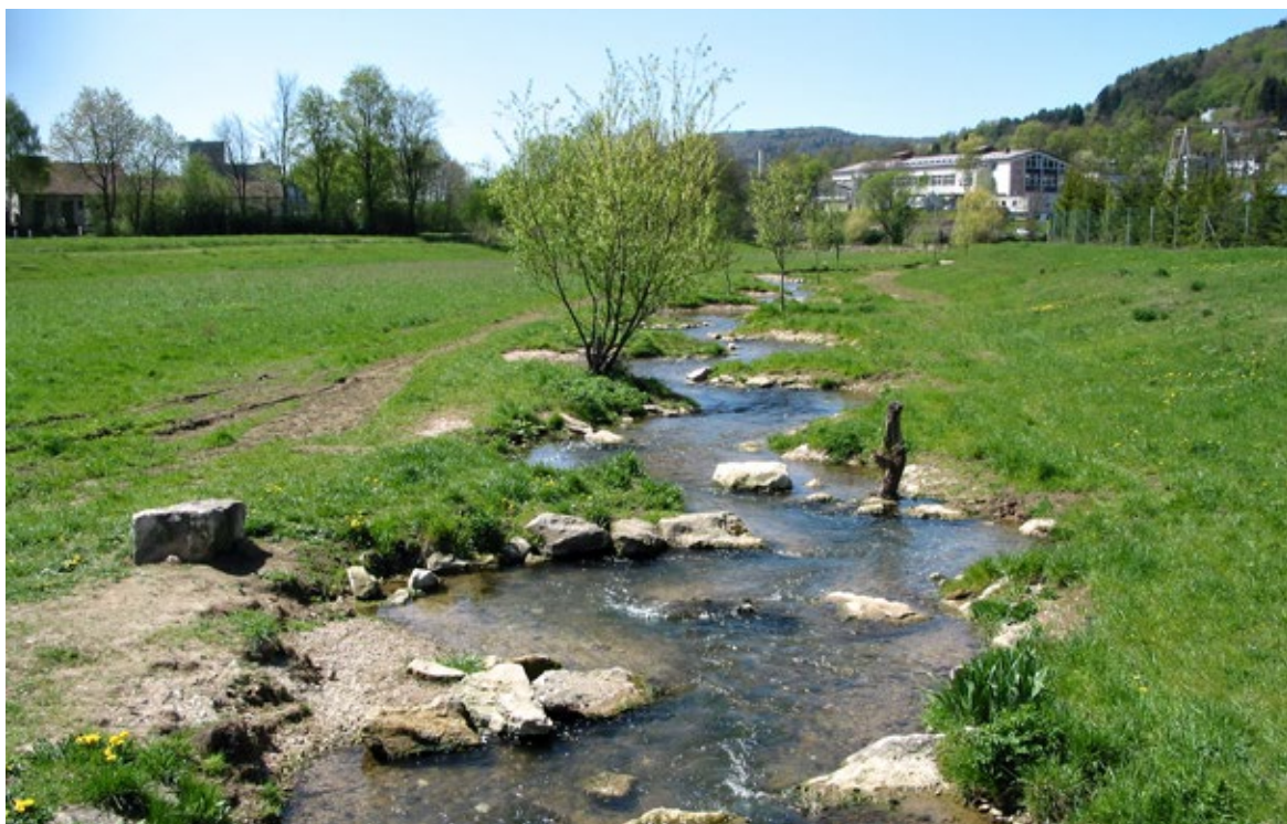
Obr. 75 Kyneta v povodňovém průlehu v roce 2012.
