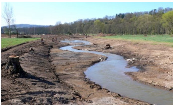
Obr. 40 První úsek nového koryta po zprůtočnění. V přechodech mezi oblouky jsou v kynetě položeny stabilizační a členicí dnové pasy z kameniva, po stranách koryta byly zapuštěny „pařezové implantáty“, získané při rušení starého koryta.
