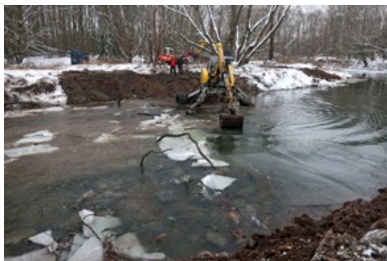
Obr. 98 Výstavba říčního prahu; 2019. (Foto J. Koutný)
