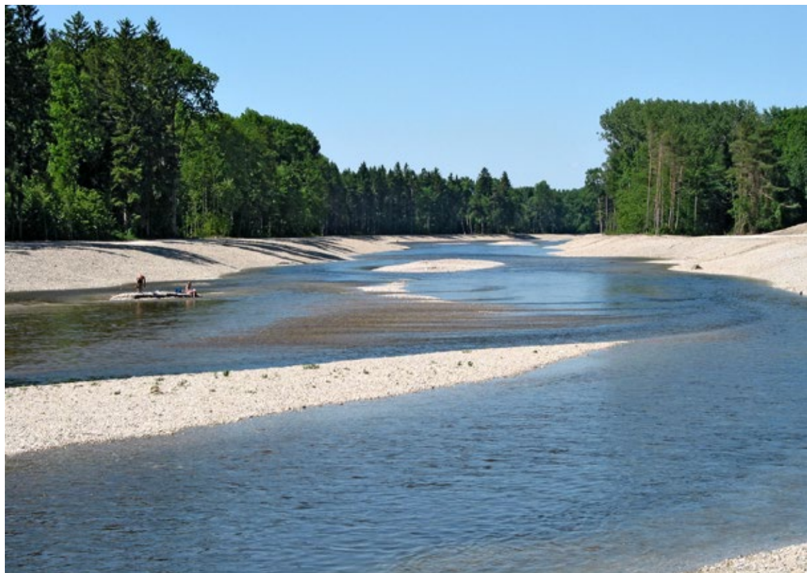
Obr. 69 Část revitalizace koryta v 1. projektovém úseku při dokončování v létě roku 2005.
