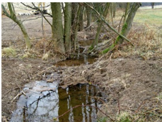
Obr. 7 Koryto Vlčince bezprostředně po vložení jednoho ze stabilizačních spádových objektů – vzájemně propletené kořenové systémy stromů z pokácených břehových porostů fixují dno toku, jejich kmeny jsou uloženy dle přesně stanovených parametrů do dna a břehů následným zasypáním kmenů odtěženou zemínou; březen 2019. (Foto M. Hausvaterová)
