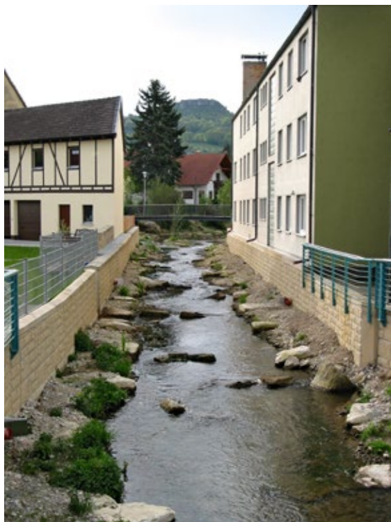
Obr. 10.55 Přírodě blízké pojednání dna potoka v nejstísněnějším úseku druhé etapy revitalizace v ba- vorském Bad Staffelstein, 2012. Postranní stěny koryta, částečně tvořené zdmi budov, jsou zde samonosně zalo- ženy a dno je přírodě blízké. Lze si však představit, že po- dobně by dno vypadalo i v případě, kdy by bylo nezbytné pojednat koryto jako tuhý rám. Pak by ovšem základní struktura kamenů a balvanů, tvořící členitost dna, byla zabetonována do podkladní desky.
