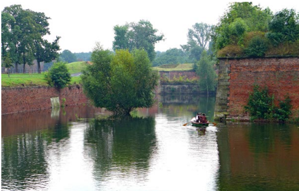
Obr. 10.70 Terezín je poznamenán zločiny německé okupace, nicméně představuje světově významnou památku barokního pevnostního stavitelství. Je velmi dobře, že se město Terezín v poslední době, v rámci odstraňování škod po povodních a celkové péče o pevnost, snaží udržovat a obnovovat také její vodní systém. Již provedené práce mimo jiné umožnily v roce 2017 alespoň v částečném rozsahu zopakovat legendární obranný vodní manévry - zaplavení příkopu obležené pevnosti.
