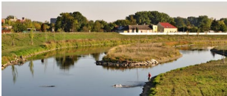
Obr. 88 Čelo ostrůvku opevněné říčním dřevem. (Foto M. Krejčí)
