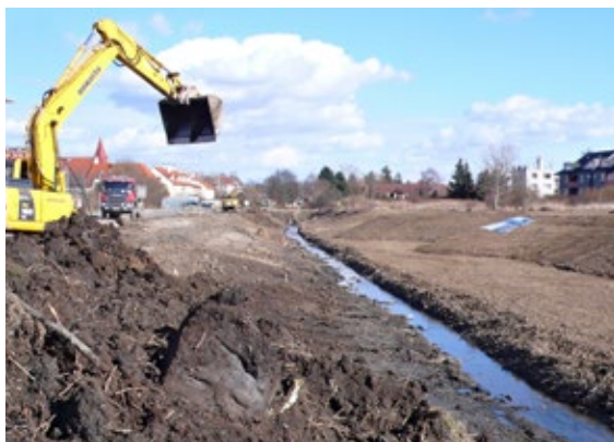
Obr. 80 První fáze prací - rozvolňování potočního pásu rozsáhlým těžením zemin. (Zde v horním úseku u hostivické školy.)
