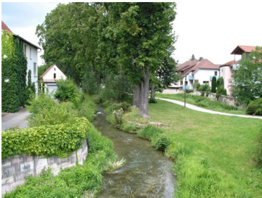
Obr. 10.28 Protipovodňová ochrana města Žebráku; 2014. Technicky pojatá stavba proměnila někdejší přírodě blízký potok v geometrizovanou strouhu a doprovodila jej ochrannými stěnami. Ekologickému stavu potoka se zde zřetelně uškodilo. Zeminové svahy mezi kynetou a zdmi zaujímají v příčném průřezu koryta mnoho místa, omezují nákladně vytvářenou průtočnou kapacitu a kynetě ponechávají velmi malou šířku. Věřme, že projektant správně vyhodnotil časový faktor při návrhu brodu. Těžiště povodí poměrně malého potoka leží jen několik kilometrů nad městem a od srážky, schopné způsobit povodeň, nezbude mnoho času na úspěšnou instalaci mobilního hrazení.
