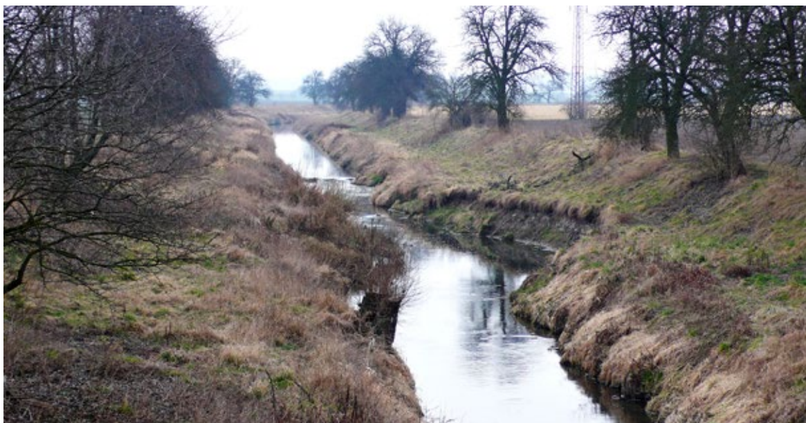
Obr. 8.20 Povodňová narušení břehu kynety technicky upraveného koryta říčky Výrovky naznačují, že by bylo vhodné vrátit tento tok blíže přírodě. Ovšem na výraznější efekty samovolné renaturace by se zde čekalo dlouho – kyneta je velmi hluboká, přímá a opevněná, koryto v polích je navíc doprovázeno protirozlivovými hrázkami. Zde je vhodné uvažovat o celkové revitalizační přestavbě, spočívající ve změkčení a rozvolnění koryta alespoň v půdorysu, vymezeném vnějšími patami dosavadních hrází. Hrázování vodního toku v polích běžně neodpovídá dnešním představám o tom, jak má vypadat říční prostor.
