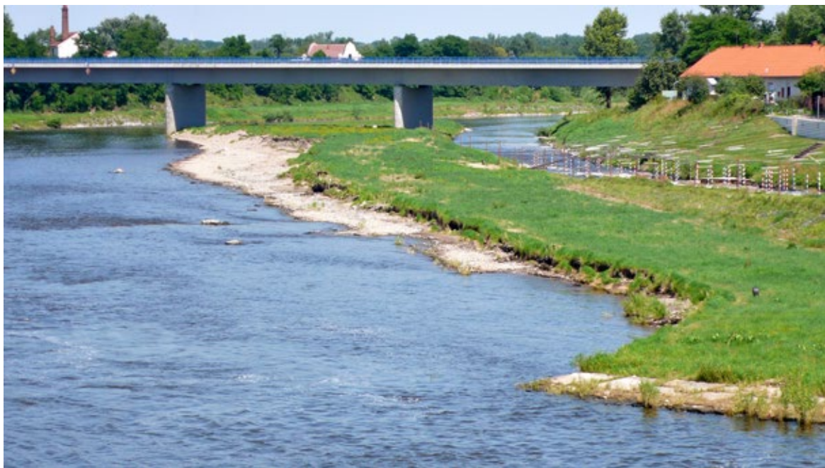
Obr. 10.48 Mělčina v odtěžené bermě pod miřejovickým zdymadlem v roce 2013.
