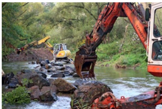
Obr. 99 Práce s kamenivem ze starého opevnění; 2019. (Foto J. Koutný)
