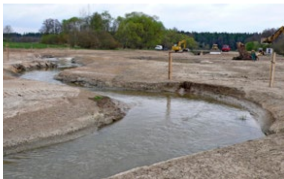
Obr. 44 Revitalizační koryto v době dokončování výstavby, v dubnu 2014. Koryto provedené v souladu s projektem má rámcově správnou geometrii, ale postrádá detailní členitost.
