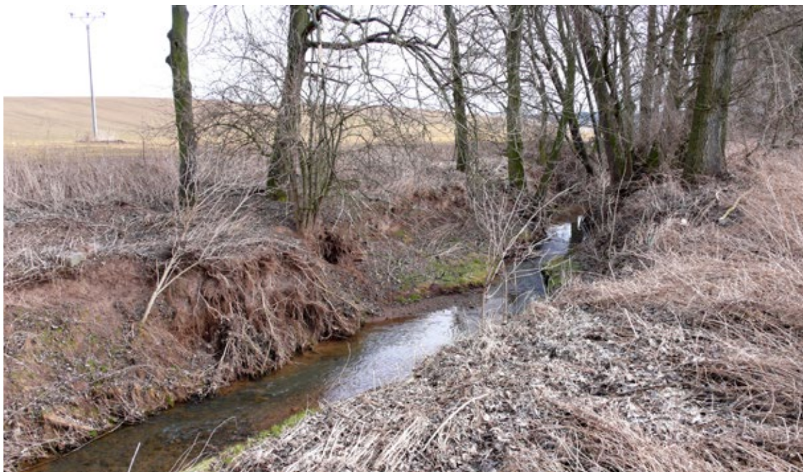
Obr. 8.22 Tento potok v minulosti prodělal nejspíše svépomocnou zemědělskou úpravu. Koryto bylo zahloubeno a napřímáno, není hloubkově ani stranově stabilní. Nebylo opevněno nebo z jeho opevnění do dnešní doby nic nezůstalo, díky čemuž má přírodě blízké dno. O zpřírodnění koryta se pokouší břehový porost, který by bylo škoda zničit. Úsek vhodný k renaturaci, podporované přírodě blízkým změlčováním dna, nejspíše v podobě dnových pasů z kameniva nebo instalací říčního dřeva.
