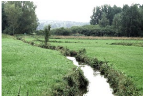
Obr. 13 Potok Trebgast před revitalizací. Starší technická úprava s geometrizovanou trasou koryta. (Foto WWA Hof)
