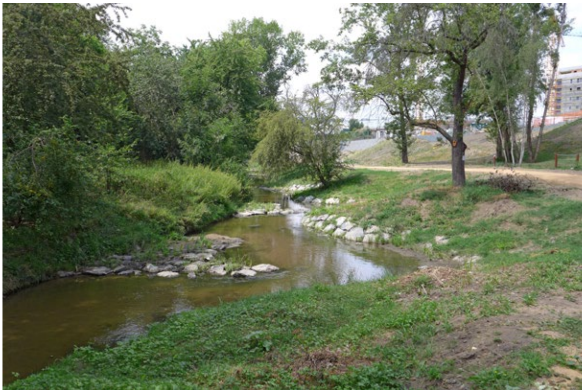
Obr. 10.69 Etapa revitalizace pražské Rokytky z roku 2019, akce Magistrátu hl. města Prahy, financovaná z prostředků města. Prizmatické koryto lichoběžníkového průřezu bylo zbaveno opevnění dlažbou, pomítně rozvolněno a zvlněno vložním výhonů, rovnaných z balvanů.
