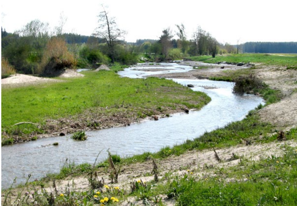
Obr. 71 Rozvolněné koryto říčky Mindel v zátopové ploše suché nádrže nad obcí Dirlewang v roce 2008, krátce po dokončení.
