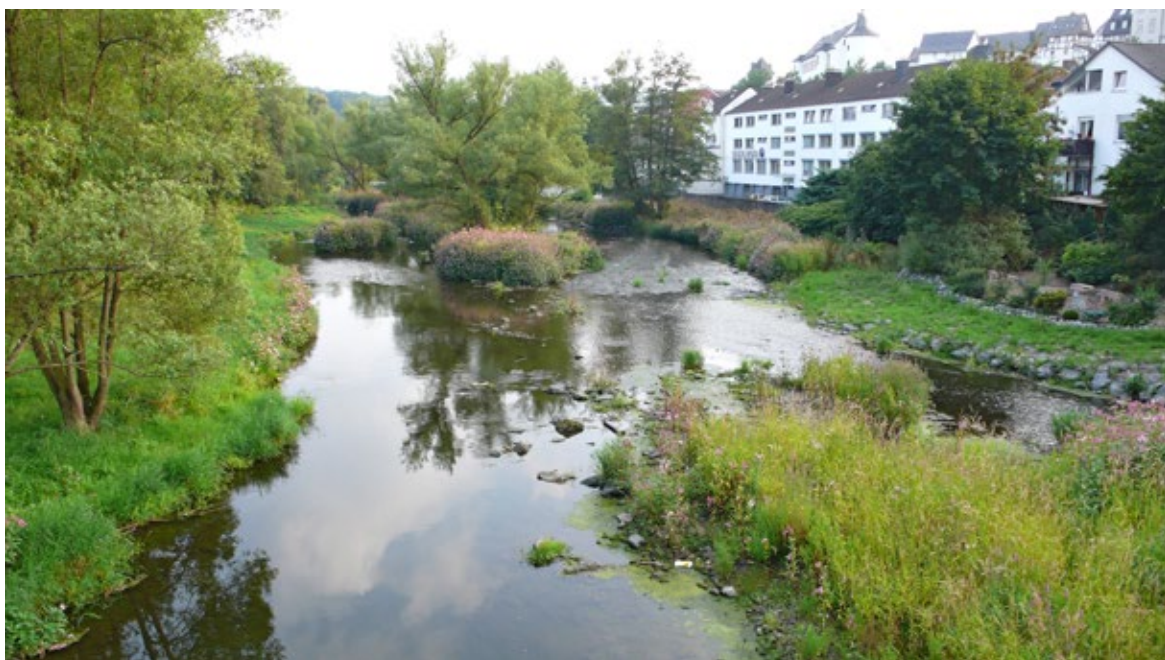
Obr. 10.49 Arnsberg, Severní Porýní - Vestfálsko, 2009. Revitalizovaný povodňový perimetr řeky Ruhr odděluje od zástavby svislá betonová stěna, která však není příliš viditelná. Řečiště je široké, takže členitěji tvarovaná nízká berm, přisazená ke stěně, v něm zabírá poměrně málo místa, a přitom stěnu vhodně kryje a vytváří přírodě blízký břeh. Na bermě rostou stromy a lidé si tam místy udržují i malé rekreační zahrádky....zde může být i zajímavé, začínat se zahrádkou po každé povodni znova a trochu jinak.
