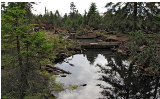
Obr. 22 Stav po realizaci v roce 2013, dubové srubové přehrážky zadržují vody. (Foto P. Marek)
