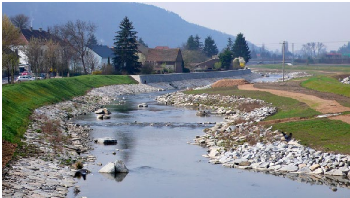
Obr. 10.12 Návrh druhé etapy protipovodňové úpravy Litavky v Králově Dvoře, realizované v letech 2013 - 2014, do jisté míry přihlédl k výhradám, vznášeným vůči etapě první. Zde alespoň kyneta a břeh nepřiléhající k zástavbě mají přírodě bližší tvarování.
