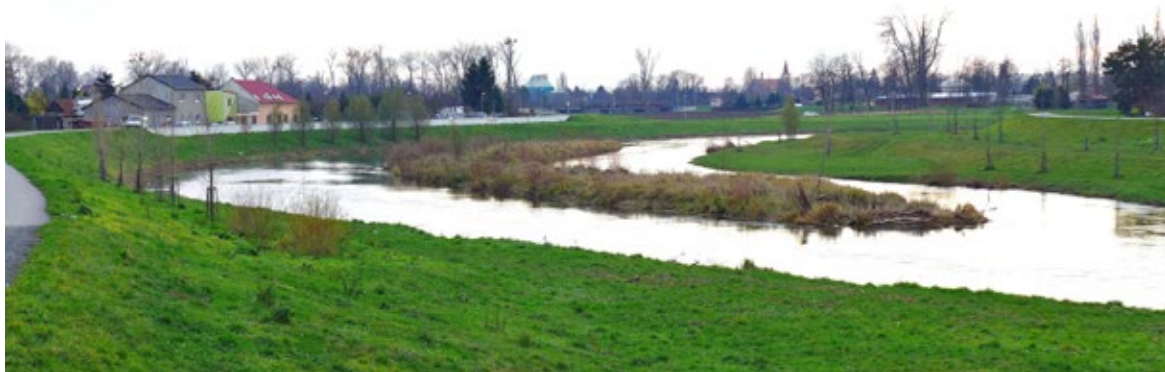
Obr. 10.46 Přírodě blízká protipovodňová úprava Moravy na dolním okraji Olomouce; etapa dokončená v roce 2013; stavba Povodí Moravy, s.p.. Říční perimetr, rozvolněný přírodě blízkým způsobem, je vymezen obvodovými valy, místy doplněnými nízkou ochrannou zídou (na snímku vlevo před frontou domů).
