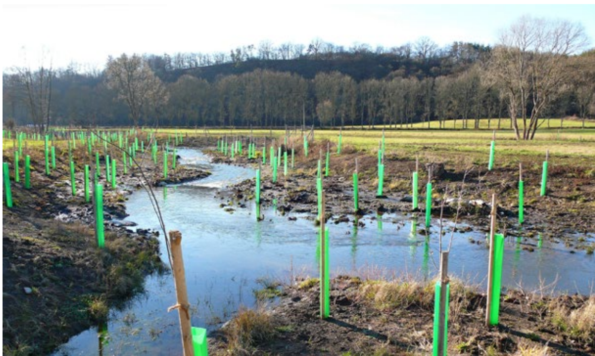
Obr. 42 Revitalizace Loděnického potoka po dokončení, na podzim roku 2015.
