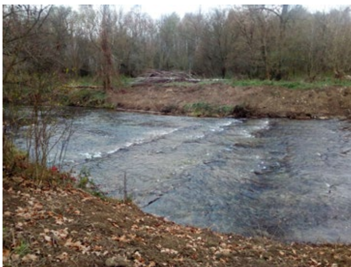
Obr. 100 Dnový pas vytvořený z kamenů někdejšího opevnění břehů stabilizuje úroveň dna a přispívá k vývoji koryta do boku; 2019. (Foto J. Koutný)
