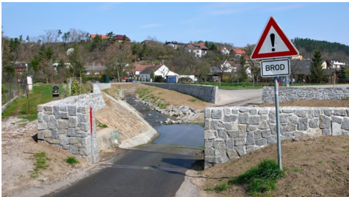
Obr. 10.28 Protipovodňová ochrana města Žebráku; 2014. Technicky pojatá stavba proměnila někdejší přírodě blízký potok v geometrizovanou strouhu a doprovodila jej ochrannými stěnami. Ekologickému stavu potoka se zde zřetelně uškodilo. Zeminové svahy mezi kynetou a zdmi zaujímají v příčném průřezu koryta mnoho místa, omezují nákladně vytvářenou průtočnou kapacitu a kynetě ponechávají velmi malou šířku. Věřme, že projektant správně vyhodnotil časový faktor při návrhu brodu. Těžiště povodí poměrně malého potoka leží jen několik kilometrů nad městem a od srážky, schopné způsobit povodeň, nezbude mnoho času na úspěšnou instalaci mobilního hrazení.
