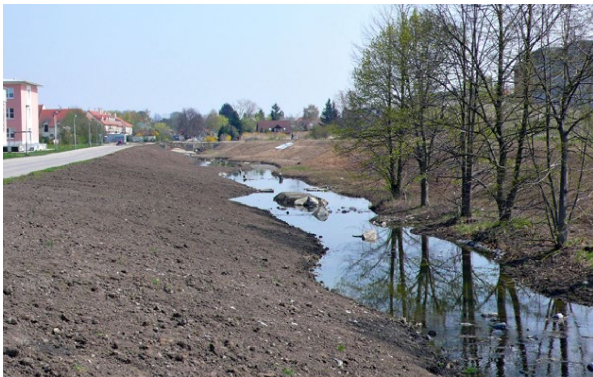
Obr. 10.44 Jaro 2015: V rozvolněném potočním perimetru u hostivické školy, představujícím hlavní povodňové koryto, bylo právě dokončeno modelování přírodě blízké kynety pro běžné průtoky. V délkové jednotce koryta běžně zadržované množství vody a vystavované hladinové plochy se proti stavu před revitalizací zvětšily na více než trojnásobek. Pohled po proudu.
