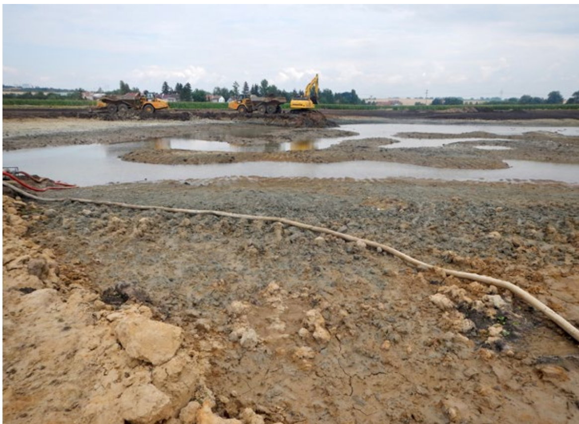
Obr. 31 Nutnost čerpání vody během stavebních prací po skrývce ornice naznačuje revitalizační potenciál lokality pro tvorbu mokřadů a tůňí; realizace 2018. (Foto J. Koutný)
