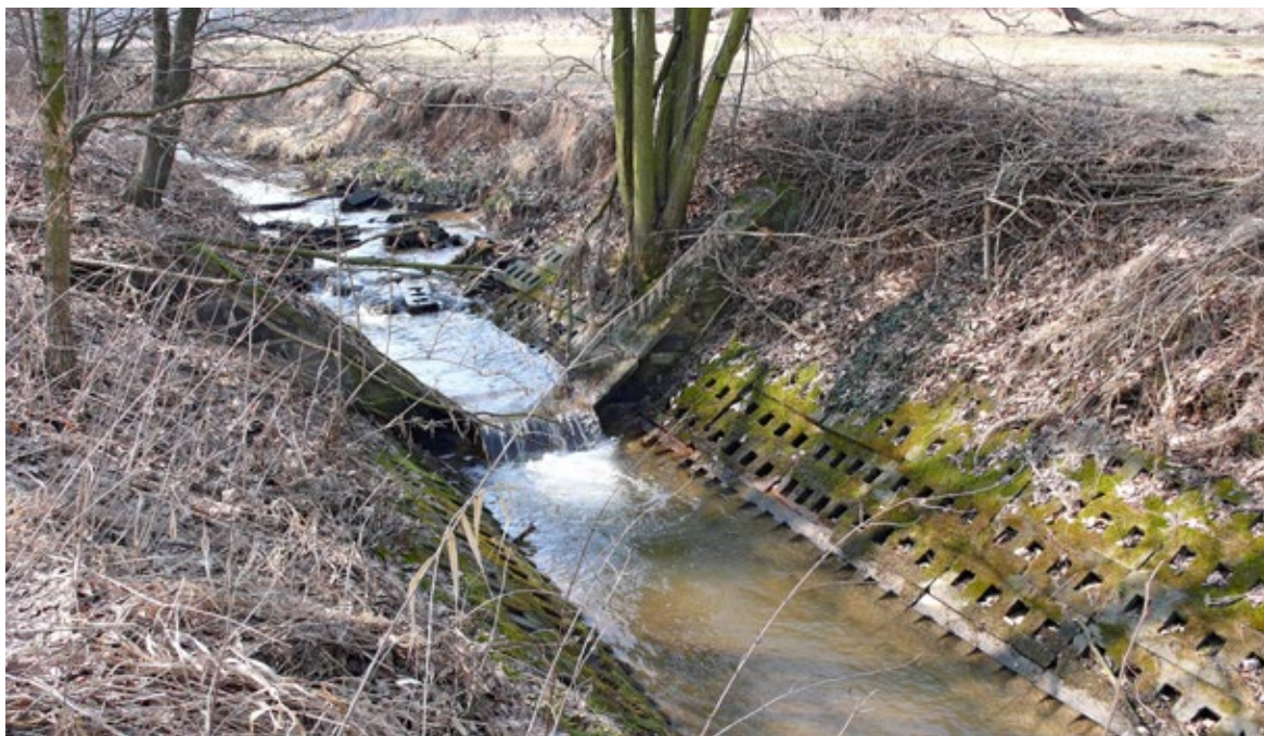
Obr. 8.18 Po věčné stránce omezují renaturační procesy zejména příliš odolné technické opevnění a nadměrné zahloubení upraveného koryta. Pokud by měl být stav tohoto úseku vodního toku významně zlepšen, pak revitalizačním zásahem. Ideálně: Vykoupit nivu, vymodelovat v její rostlé zemině nové, přírodě blízké koryto, staré zasypat.
