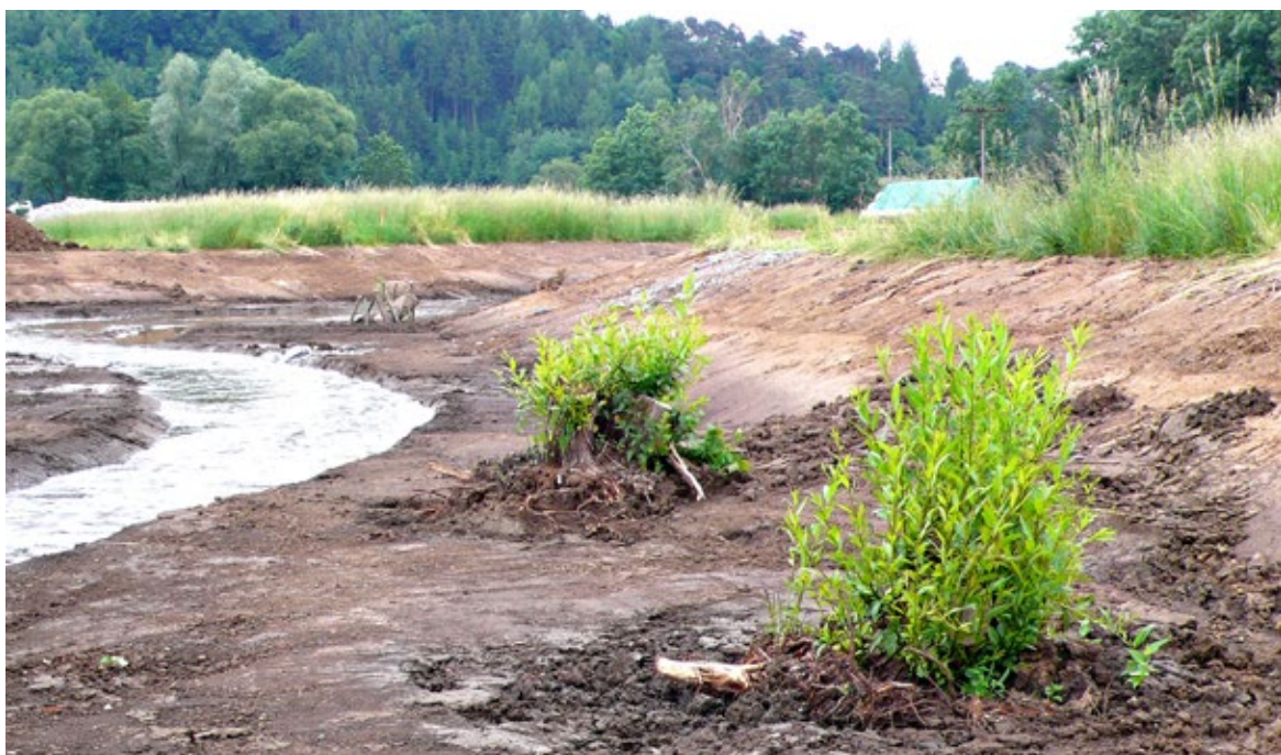
Obr. 9.25 Pařezové implantáty: Při rušení starého, technicky upraveného koryta Loděnického potoka u Nenačovic byly uchovávány hlavně vrbové pařezy a následně byly zakopávány v blízkosti nového, revitalizačního koryta. Funkční způsob ozelenění. (Obrazila i většina olšových pařezů, i když tradované poučky to nepředpokládají.)
