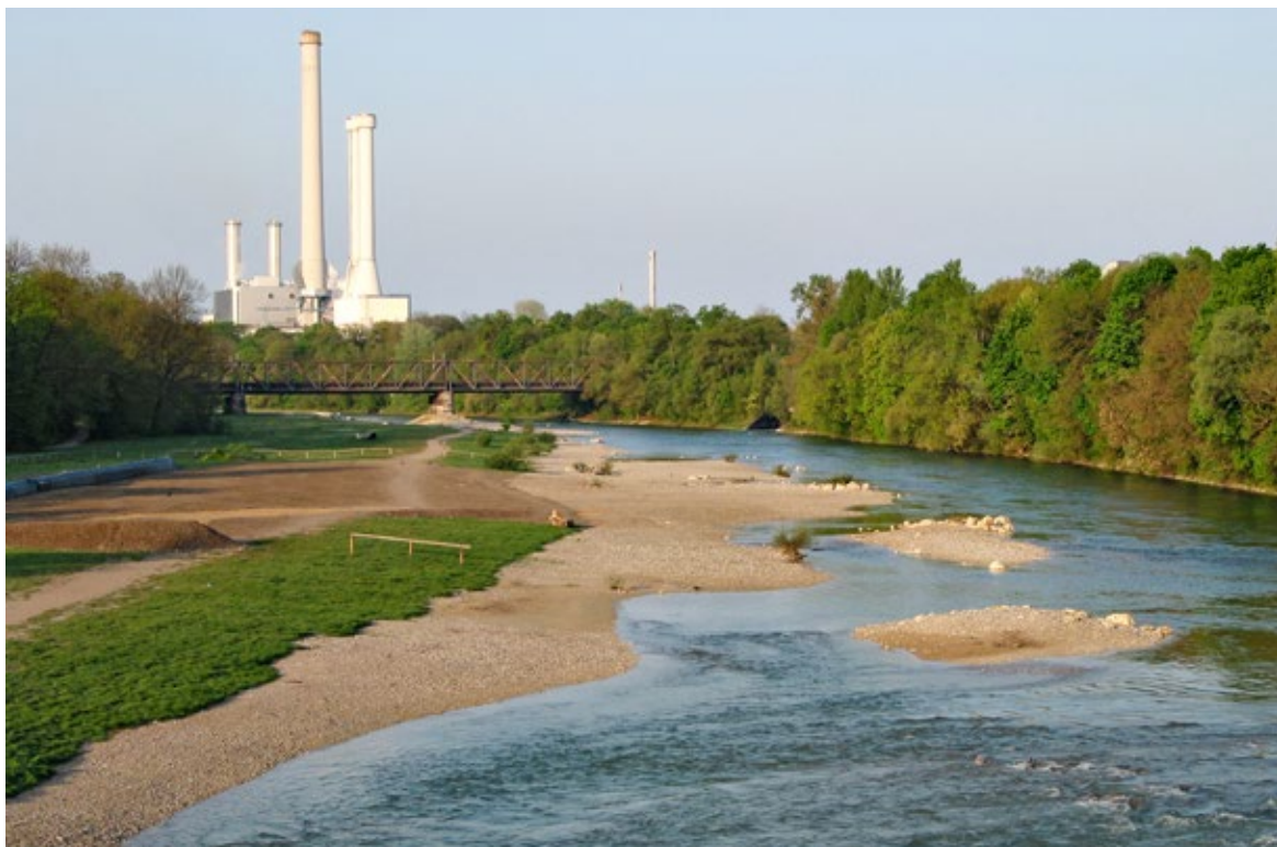
Obr. 10.25 Právě dokončené přírodě blízké rozvolnění úseku kynety řeky Isar v Mnichově, cca 2010.
