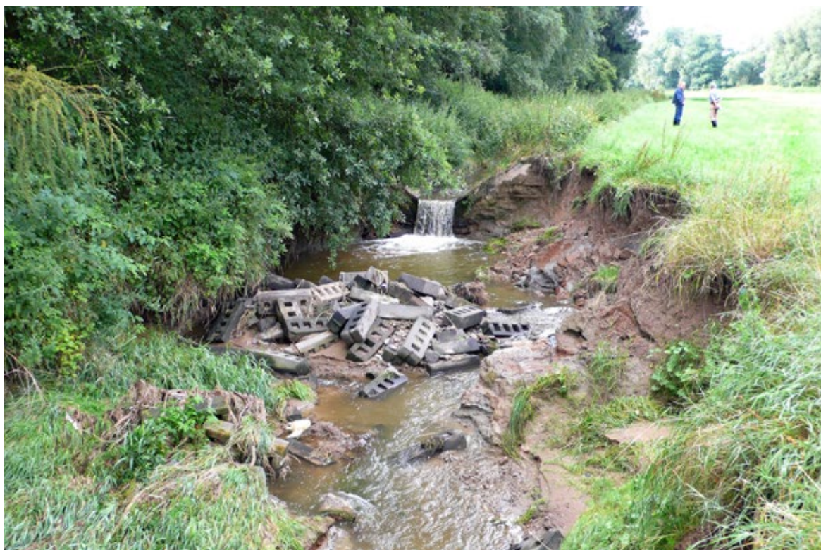
Obr. 8.19 Tato destrukce „melioračního“ koryta vypadá z hlediska členitosti vodního toku zajímavě. Ovšem nové koryto je ještě podstatně hlubší, než rozpadající se „meliorační lichoběžník“, a polovegetační tvárnice v korytě nutno pokládat za odpad (i když příroda tolik nerozlišuje, zda úkrytové struktury tvoří kameny, nebo tvárnice). Úsek vhodný spíše k provedení revitalizace, než k přenechání samovolné renaturaci.
