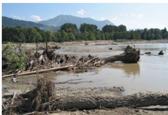
Obr. 77 Přírodě blízké, povodňové kapacitní koryto Iller u Seifenu v okamžiku slavnostního předávání stavby v září 2005. Sotva odezněla povodeň, která koryto „doformátovala“. Splaveniny a dřevěné konstrukce byly následně v korytě ponechány.
