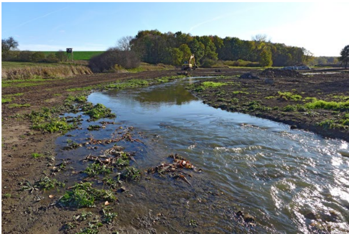
Obr. 49 Revitalizační koryto Říčanky po vložení dnových pasů z kameniva. Jejich provedením byly běžné hladiny vody nastaveny záměrně tak vysoko, aby koryto bylo za běžných průtoků prakticky vyplněno vodou. Takto je podporována akumulace mělké podzemní vody v nivě a zamokření nivního povrchu.
