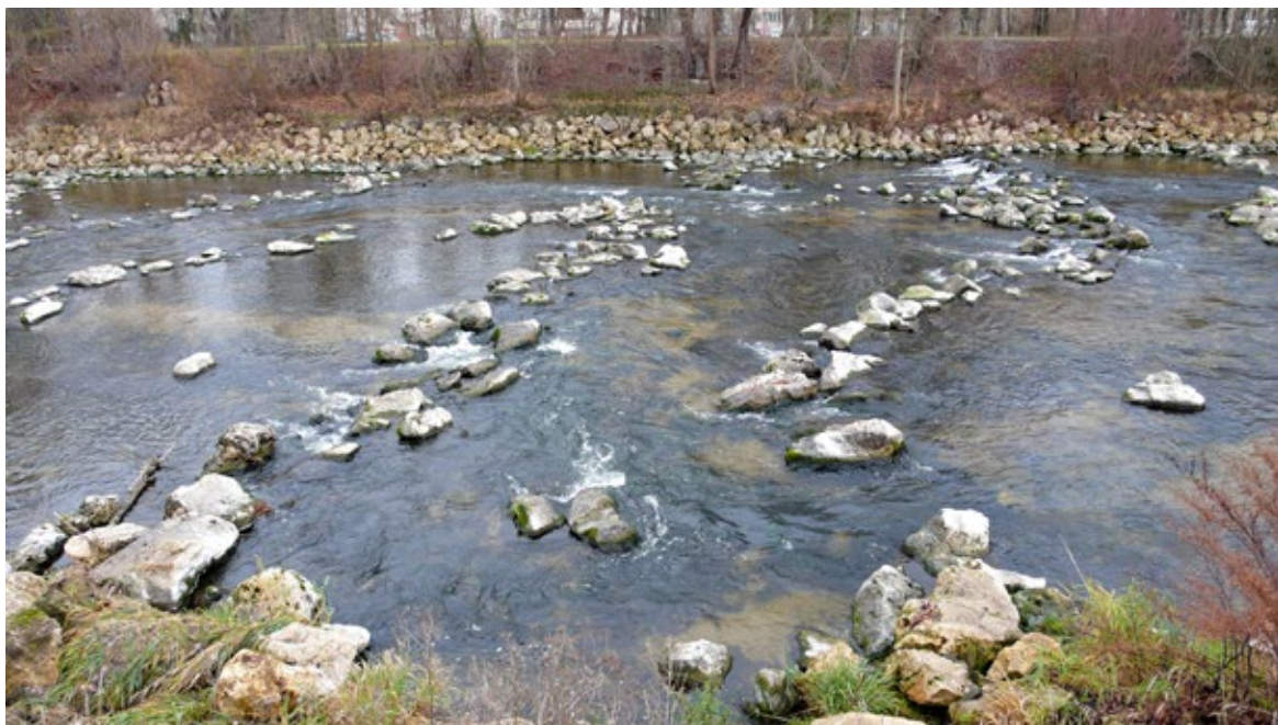
Obr. 10.45 Dnová rampa v korytě řeky Wertach v Augsburgu, která nahradila starý jez Goggeles, 2008. Žebra rovná z kamenů tvoří výhony, které za menších průtoků určují vlásenkovitý průtok vody. Hydrodynamické vzduší zvětšuje aktuálně přítomné množství vody v korytě a zlepšuje podmínky migrační propustnosti.
