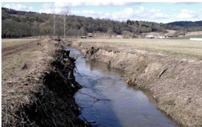
Obr. 39 Staré koryto na jaře 2015, po odstranění porostů a před zahájením stavebních prací.
