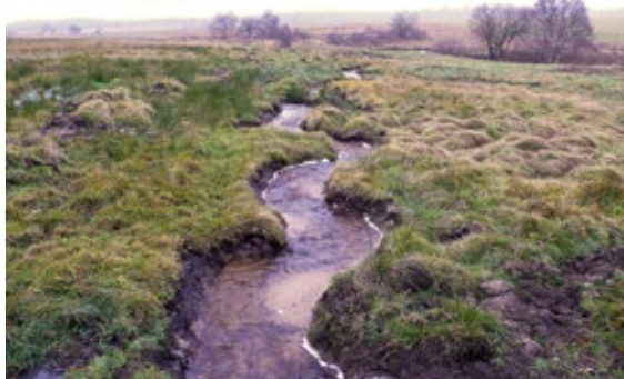
Obr. 10 Modelace revitalizačního koryta Černého potoka. Koryto je hluboké „na rýč“, detailně členité, bez opevnění; 2009.
