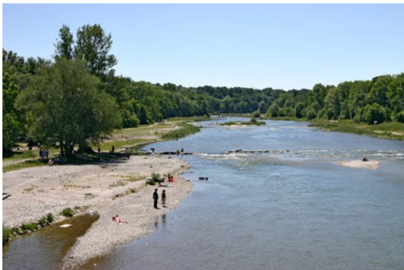
Obr. 10.37 Nosným principem etapové revitalizace Isary v Mnichově bylo poskytnout dostatek prostoru přírodě blízké říční kynetě, provádějící běžné průtoky. Dělo se tak jejím rozvolňováním na úkor postranních suchých berem. Pohled na starší etapu revitalizace nedávno po dokončení, v roce 2005. V porostech po stranách se skrývají hráze, vymezující povodňový perimetr, za nimi leží město. Na obou lících hrází rostou stromy, součástí revitalizační kampaně však bylo nákladné zpevňování některých jejich úseků v korunách zapouštěnými geotechnickými stěnami.
