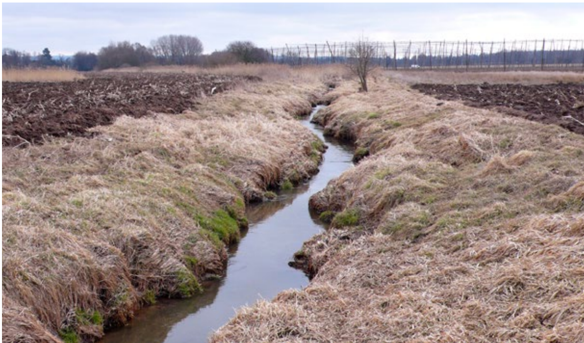
Obr. 8.4 Tento potok v zemědělsky využívané krajině byl v minulosti napřímen a opevněn laťovým plůtkem. Časem se opevnění rozpadlo, břehy se postupně rozvolňují, koryto je poměrně mělké. Zde by nebylo efektivní provádět revitalizaci, tedy zpřirodnění bagrem. Tomuto potoku by stačilo již do jeho koryta rušivě nezasahovat a případně rozšířit přírodě blízké pásy území po jeho stranách.
