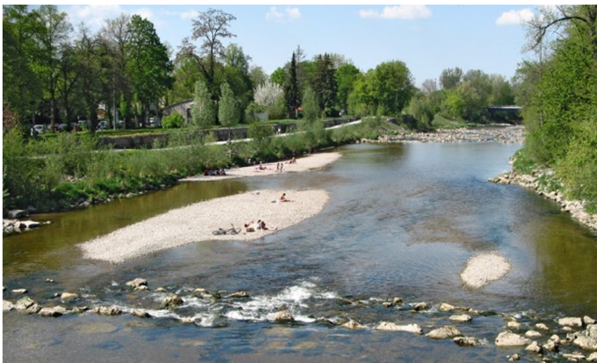
Obr. 10.13 Revitalizace řeky Wertach v bavorském Augsburgu, 2012. Práce s detailní členitostí koryta v prostoru vzdutí bývalého jezu Goggeles. Ten byl kolem roku 2005 odstraněn a nahrazen balvanitou rampou - v pozadí obrázku. Stupně v korytě byly nahrazeny menšími balvanitými rampami. Břehy slouží jako poříční park.
