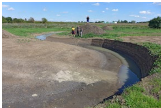
Obr. 48 Modelace meandrujícího revitalizačního koryta Říčanky pod obnovovaným Litožnickým rybníkem, akce hl. města Prahy v roce 2019. Do tohoto koryta bude puštěna voda potoka a následně budou ponejvíce v přechodech mezi oblouky trasy do dna koryta uloženy a vpěchovány stabilizační pasy z kameniva, napodobující přirozené brody.
