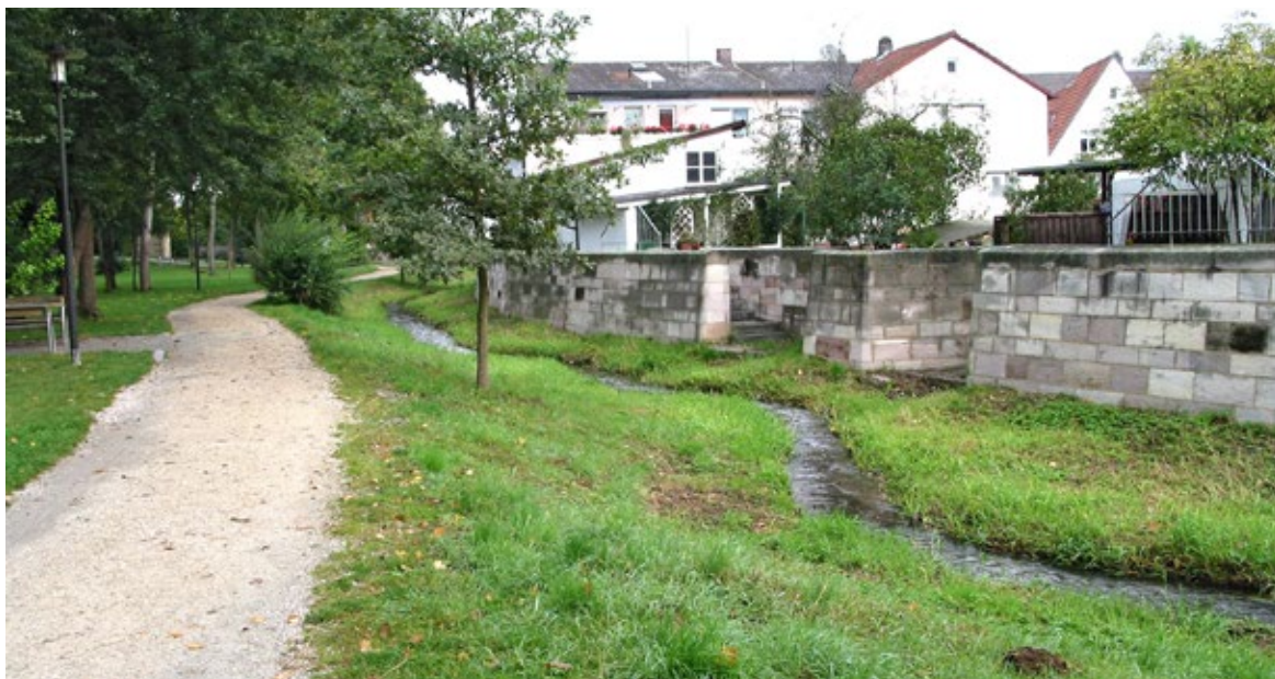
Obr. 10.30 Detail z Bad Staffelstein: Za postranním ramenem potoka jsou v protipovodňové stěně vidět schodiště, umožňující přístup k vodě z jednotlivých navazujících parcel. Tento způsob vyhovění majitelům sousedních pozemků (budou přes ty schody nosit konve s vodou na zalévání?) byl nejspíš dosti nákladný, nikdy tu však nebudou problémy s mobilním zahrazováním prostupů stěnou.
