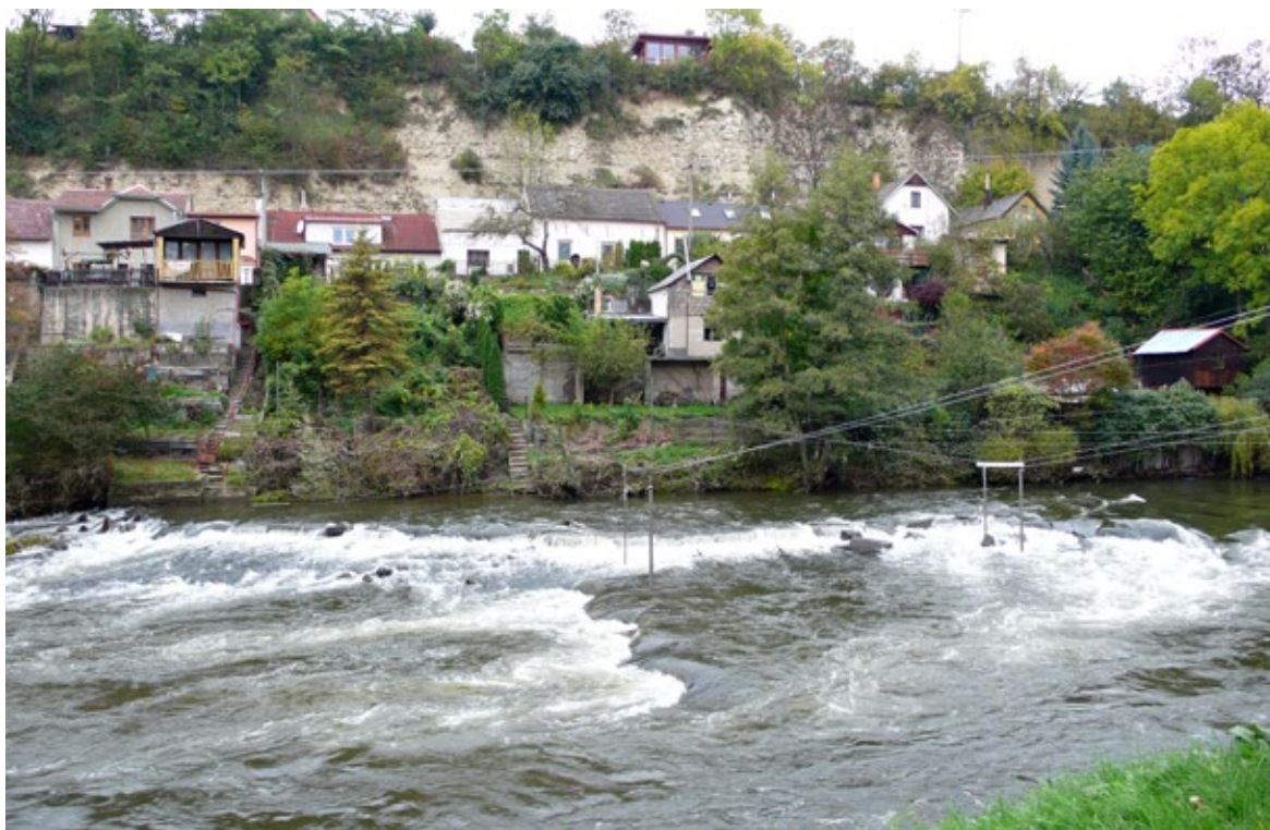
Obr. 10.56 Starý jez na dolním okraji Benátek nad Jizerou již nesloužil původním účelům a za povodní by podporoval zpětné vzdutí směrem do města. Byl ponechán samovolnému rozpadu a mění se v peřej, sloužící vodáckým sportům.
