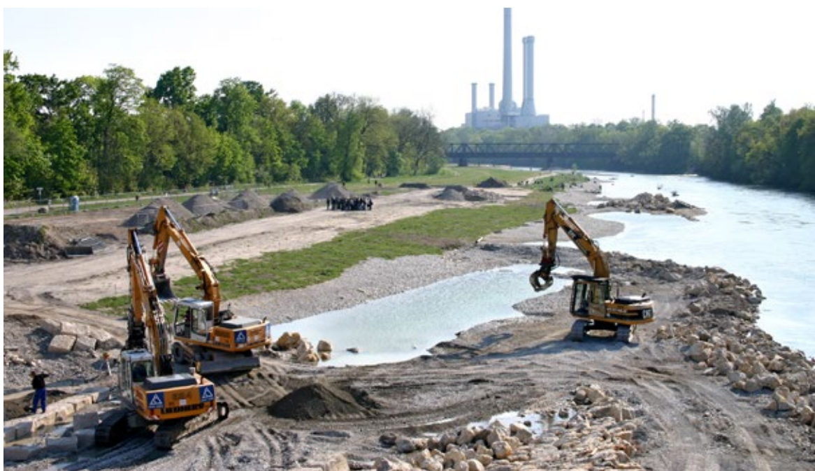
Obr. 10.24 Základním prvkem zatím zřejmě největší intravilánové revitalizace v Evropě - Isary v Mnichově - bylo rozvolňování zavodněné kynety na úkor suché bermy. Realizační etapa cca 2009. Jedno z hesel této revitalizace by mohlo znít: „Více řeky, méně psí louky v bermě“.
