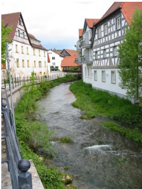
Obr. 10.54 Heiligenstadt v Bavorsku. Koryto říčky ve stísněném historickém středu města je vymezeno ná- břežní stěnou a zdmi domů. Nicméně dno zůstává pří- rodě blízké - tvárné, kamenité a členité. Případné změny ve struktuře dna, způsobené většími průtoky, nemusejí ohrožovat jeho funkci a stabilitu. Členitost a zároveň sta- bilita koryta byla v tomto případě posílena přirovnávkou velkých kamenů k patám stěny a zdí (na snímku z roku 2005 pokryto vegetací).
