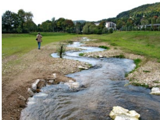
Obr. 73 Přírodě blízká vlnitá kyneta pro běžné průtoky, vymodelovaná ve dně ochranného povodňového průlehu; 2007.
