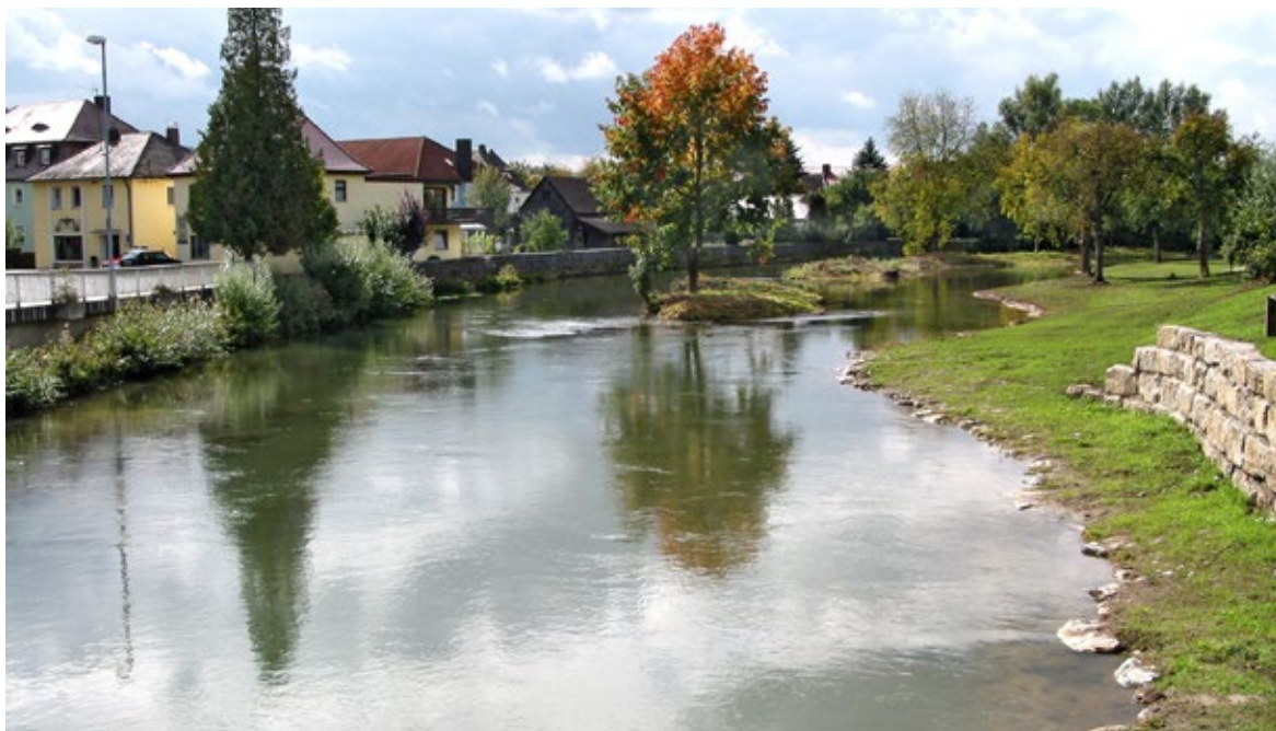
Obr. 10.23 Úsek řeky Wiesent v Ebermannstadtu po rozvolnění, 2008. V linii někdejšího pravého břehu bylo ponecháno několik ostrůvků se vzrostlými stromy. Nově vytvořený pravý břeh je členitý, od břehové čáry vystupuje do bermy ve velmi mírném sklonu, který umožňuje lidem pohodlně přistupovat k vodě. Zcela vpravo stěna z hrubých kamenných kvádrů kladených na sucho, která vybíhá od pobřežního pilíře mostu, z něhož byly snímky pořízeny.
