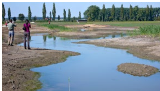
Obr. 64 Budovaný úsek revitalizace Altmühl v roce 2009. Pro potřeby výstavby je momentálně snížena hladina vody v plochem nivním bazénu, následně bude změlčením závěrného úseku koryta vystavena do úrovně blízké okolnímu terénu.
