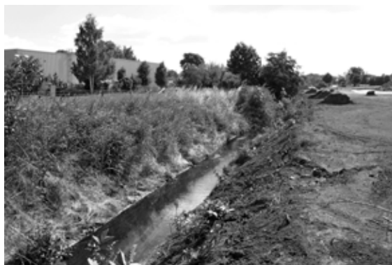
Obr. 79 Charakteristická podoba Litovického potoka v Hostivících při zahajování revitalizace. Produktem starší technické úpravy byla přímá trasa, lichoběžníkový průřez, opevnění dlažbou, minimální tvarová a hydraulická členitost.
