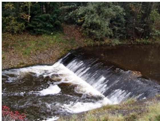
Obr. 91 Výchozí stav 2009 – železobetonový jez na řece Teplé (foto neznámý autor)
