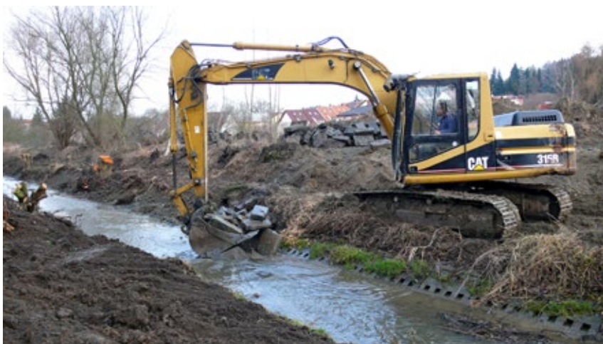
Obr. 1 Zahájení revitalizace Říčanky v Říčanech, 2015 – trhání opevňovacích polovegetačních tvárnic.
