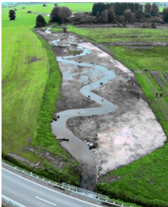
Obr. 14 Letecký snímek dílčího úseku revitalizace po dokončení v roce 2014. Patrně je snížený potoční pás, vytvořený sejmutím půdního povrchu na hloubku 0,5 až 0,7 metru. V ploše pásu pak bylo vymodelováno zvlněné nové koryto. (Foto WWA Hof)
