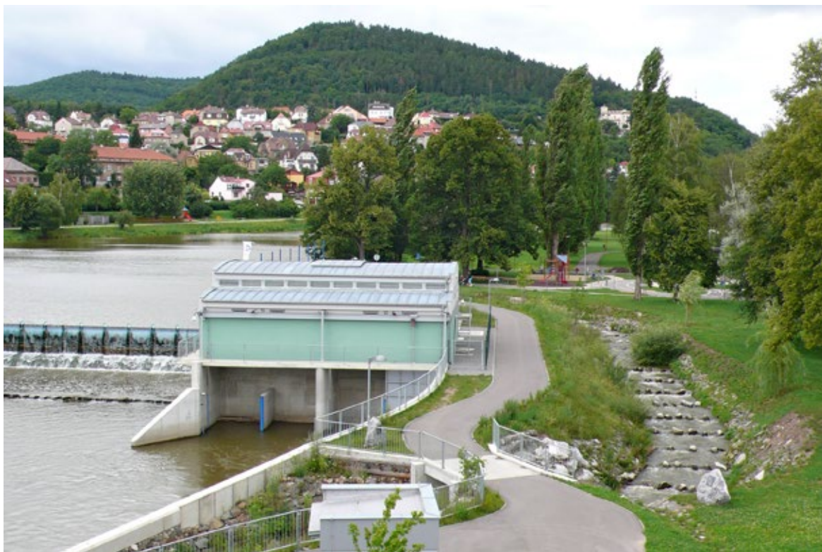
Obr. 94 Beroun – pohled proti proudu na jez, MVE a rybí přechod.
