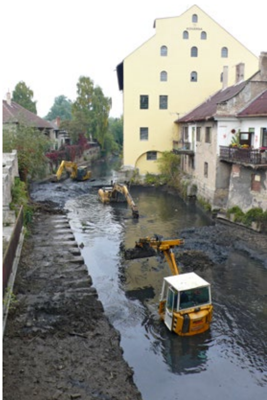
Obr. 10.67 Mlýnský kanál tvoří zajímavou a romantickou vodní osu Kostelce nad Labem. V roce 2015 byl náročným způsobem odbahňován v rámci revitalizační akce města, dotované v rámci OPŽP.
