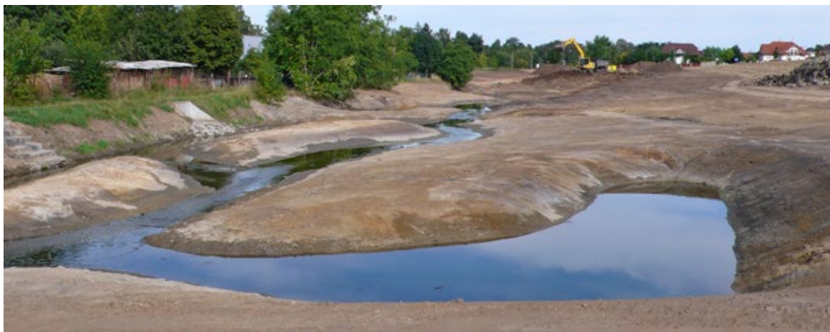
Obr. 10.18 Revitalizace Litovického potoka v Hostivicích (2015; investor město Hostivice) vytvořila prakticky uprostřed města zajímavé parkové území. Rozsáhlým a nákladným těžením zemin byl vytvořen nejen povodňově bezpečný průtokový koridor, ale také prostor pro zajímavou parkovou úpravu.
