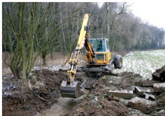
Obr. 18 Koncem roku 2005 začala revitalizace odstraněním nevhodného opevnění z technicky upravených koryt Pekelského potoka a jeho přítoků.
