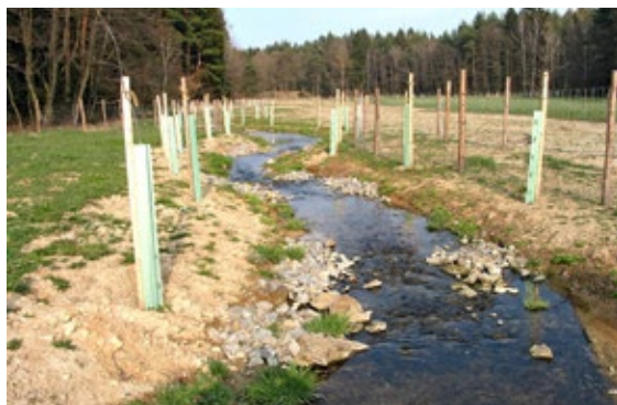
Obr. 19 Revitalizační koryto Pekelského potoka v lesní louce, pohled na podzim roku 2006. Tvarování koryta již naznačuje - dle vzoru přírodních potoků - střídání tůň a kamenitých brodů.
