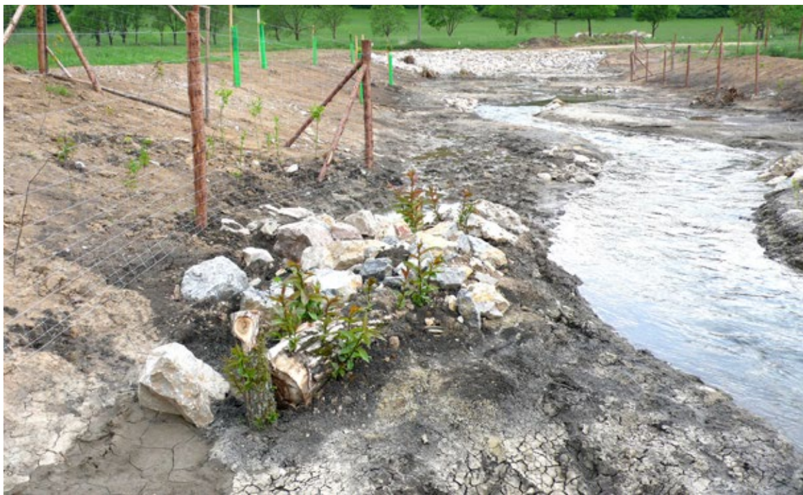
Obr. 9.26 Obrážející živé vrbové poleno, obložené několika kameny.
