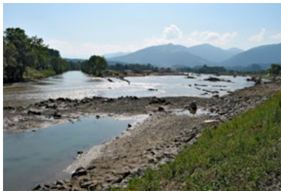
Obr. 76 Pohled proti proudu Iller po povodni roku 2005. V pohledu vlevo staré, technicky upravené koryto řeky. (Později zaniklo při výstavbě dálničního tělesa a postranního povodňového poldru.) Vpravo právě stavebně dokončené a povodní doformátované nové koryto řeky. Ještě více vpravo není vidět nově postavenou ochrannou hráz, za níž se v nivě nalézají několik obcí a továrna Bosch.
