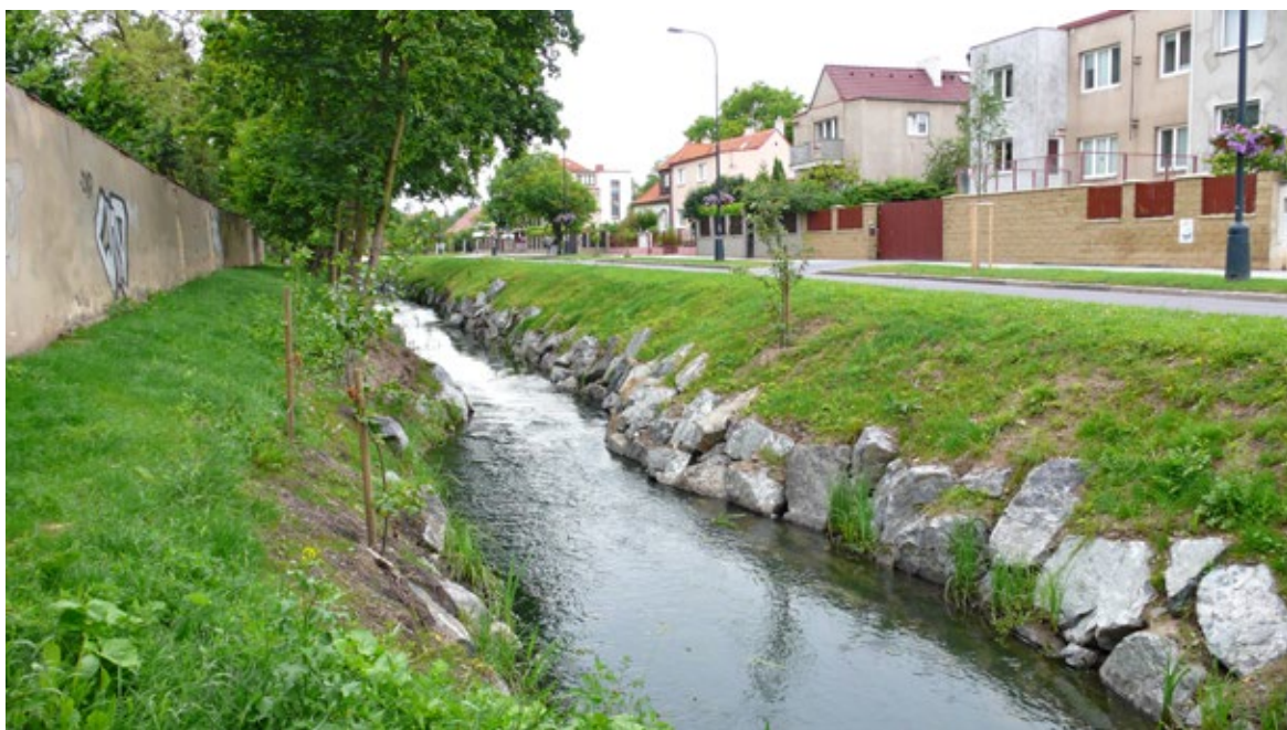
Obr. 10.7 Litovický potok v Praze – Ruzyni, 2010. Podél zdi obory Hvězda tu po desetiletí tekł potok kanálem, překrytým betonovými deskami. Magistrát města Prahy jej nechal otevřít. (Financováno z prostředků hl. m. Prahy.) Stísněný prostor mezi oborní zdí a silnicí neumožňuje výraznější rozvolnění trasy a rozevření příčných průřezů, nicméně potoku byla vrácena alespoň základní ekologická hodnota.
