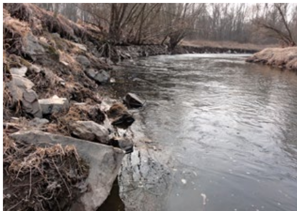
Obr. 96 Koryto Moravy u Štěpánova před zásahem, v roce 2015. Opevnění břehů technicky pojatým pohozen (strmý sklon, geometricky pravidelné tvary) se postupně rozpadá, přesto však udržuje charakter koryta degradovaného technickou úpravou. (Foto M. Krejčí)
