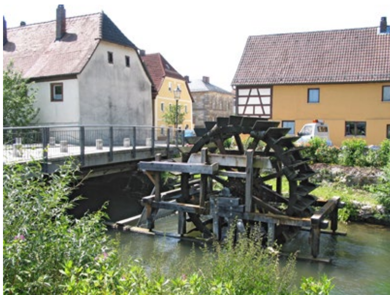
Obr. 10.65 Retro – mlýnské kolo jako návštěvnický vděčný kulturní prvek může být osazeno do mlýnského kanálu v bavorském Ebermannstadtu díky tomu, že přítok do kanálu je kontrolován stavidlem. V korytě vystaveném povodňovým průtokům by kolo dlouho nevydrželo. I tak žádá soustavnou údržbu.
