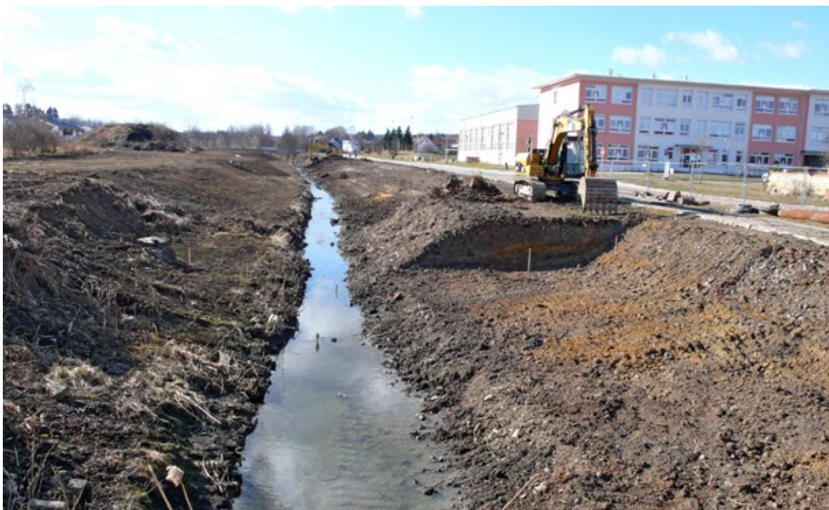
Obr. 10.43 Hostivice, další fáze výstavby revitalizace: V úseku před školou probíhá rozvolňování potočního perimetru - právě je dobře vidět řez tělesem odstraňované zeminy. (Pohled proti proudu.)
