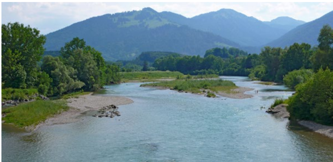
Obr. 78 Přírodě blízké koryto řeky Iller u Seifen po několika vegetačních sezónách. Nepoučený sotva pozná, že nejde o přírodní koryto, ale o vodohospodářskou stavbu.
