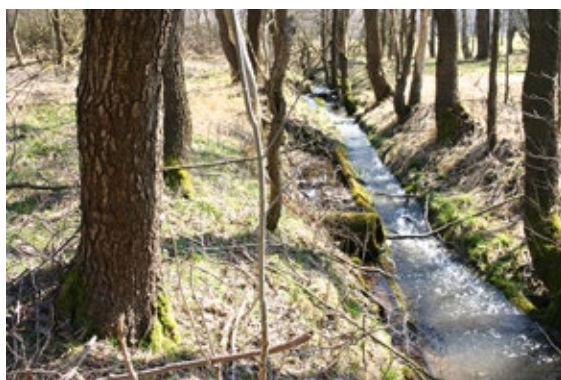
Obr. 5 Technicky upravený potok Vlčinec před revitalizací – úsek s poměrně zachovalým opevněním, udržujícím i po mnoha letech po provedené úpravě koryto v přímé trase a prizmatickém profilu; duben 2015. (Foto M. Hausvaterová)
