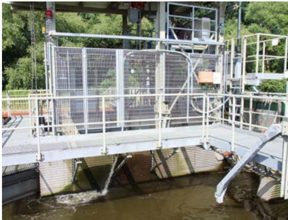
Obr. 3 Odlovná klec na technickém rybím přechodu v Geesthachtu (Foto: Tereza Barteková)
